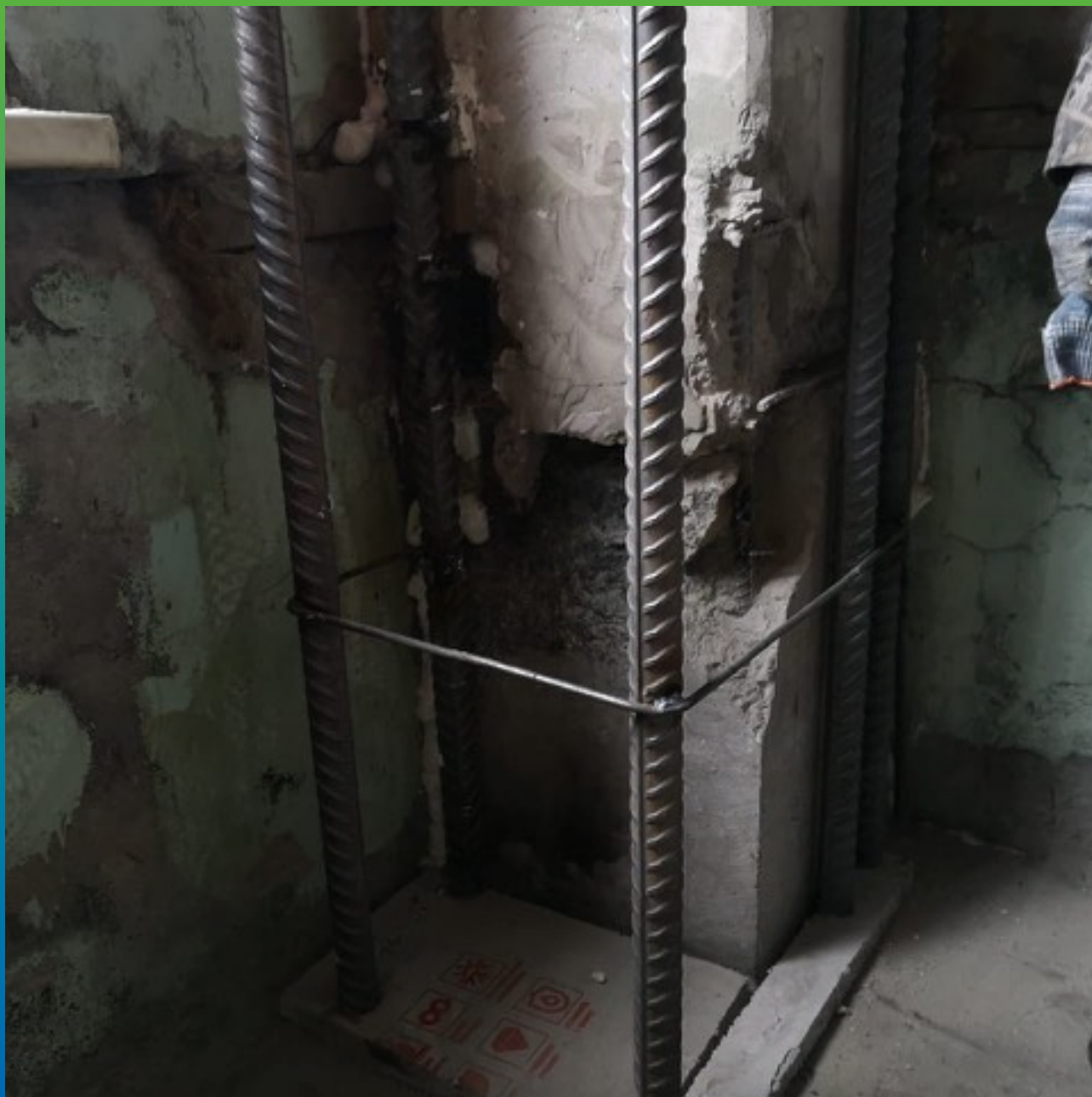
Монтаж каркаса арматуры
