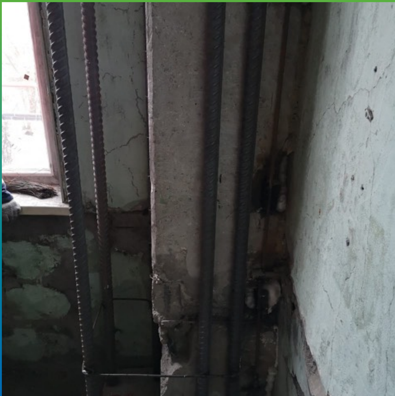
Установка каркаса арматуры
