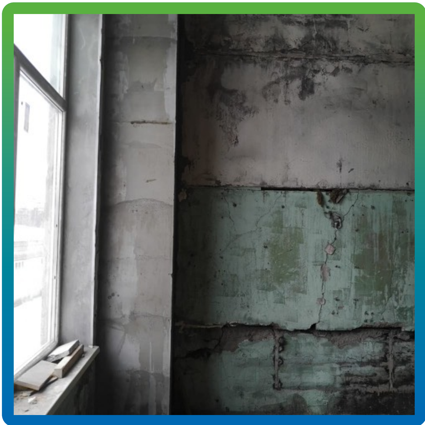
Финишный вид колонны после ремонта
