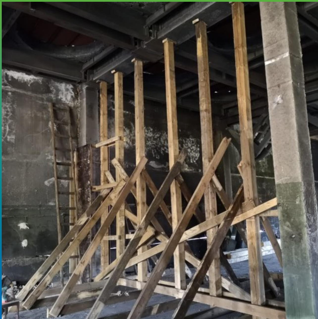
Заливка Стармекс ФМ7
