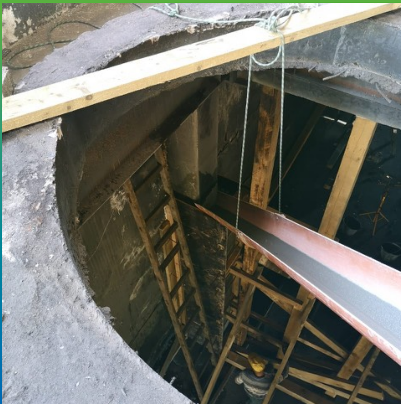
Заливка Стармекс ФМ7
