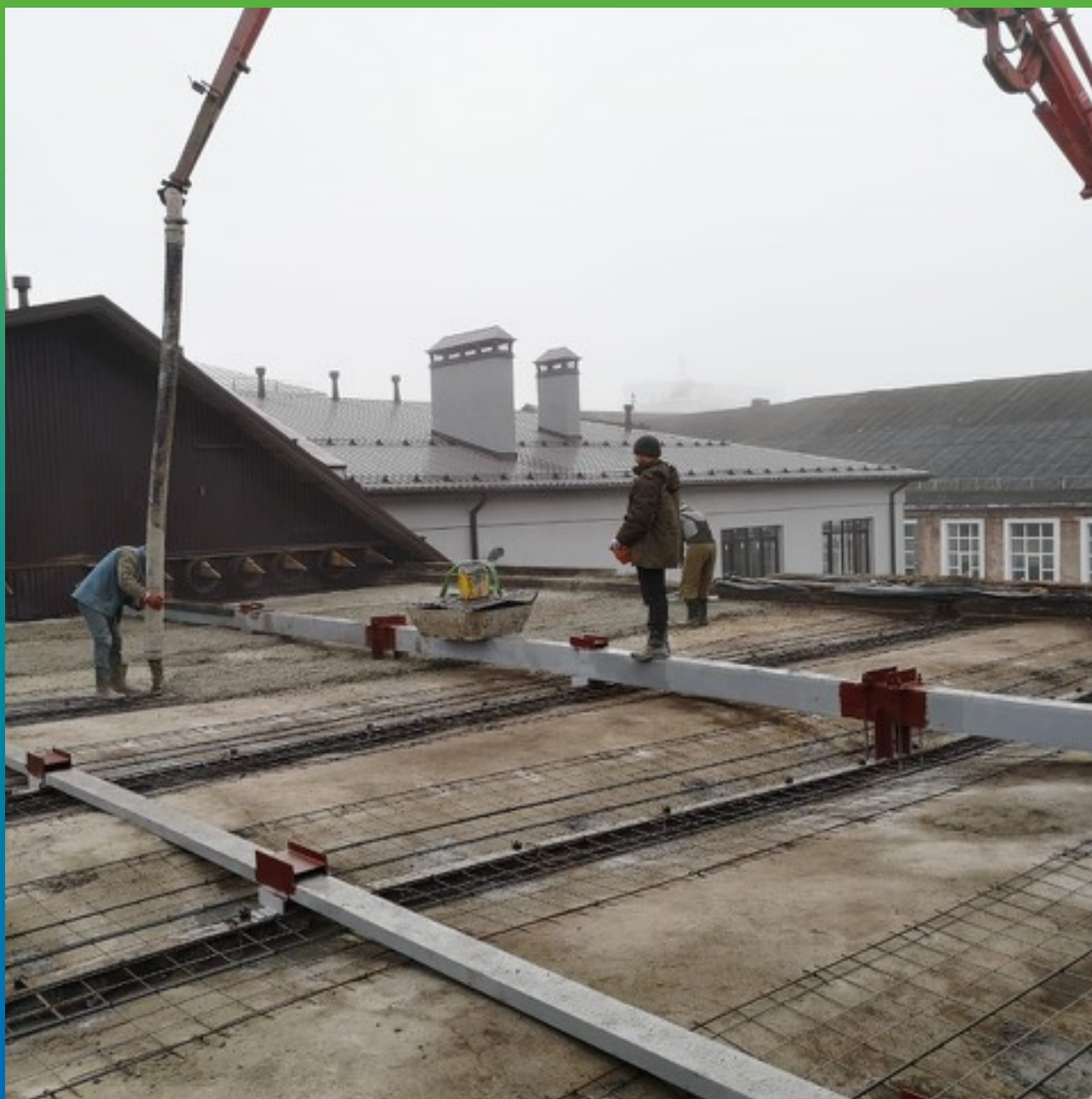
Заливка стяжки
