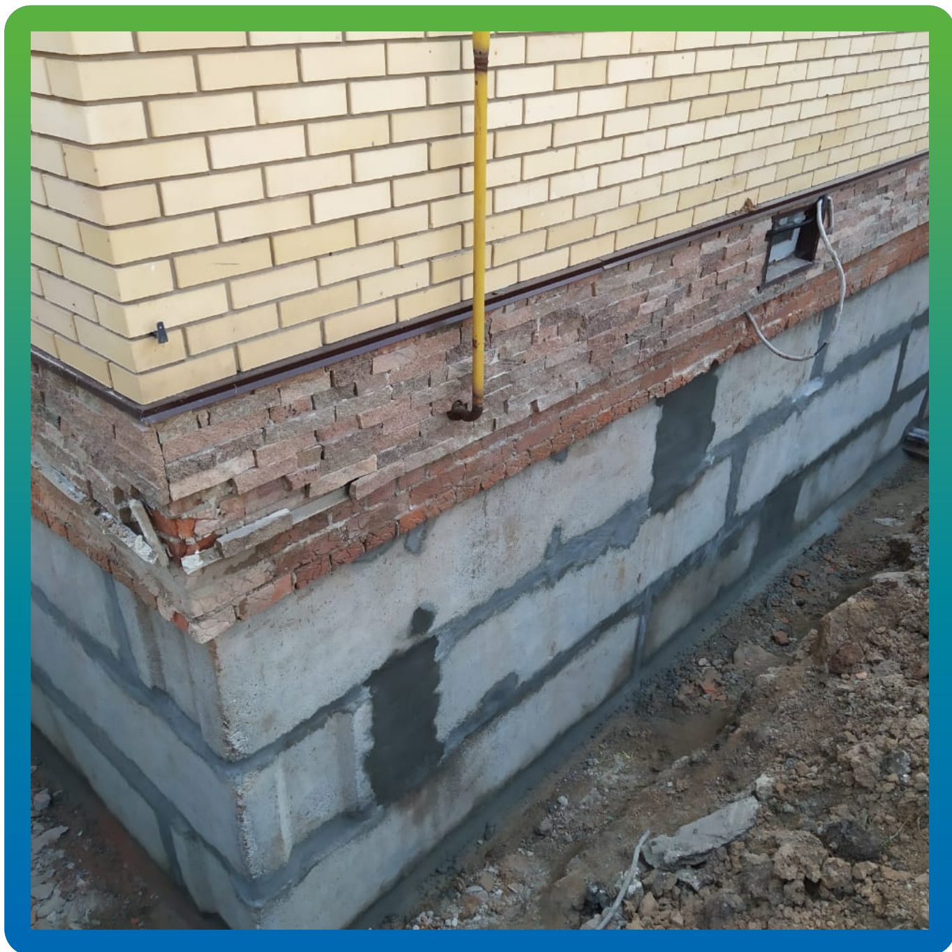
Швы, зачеканенные составом Стармекс РМЗ
