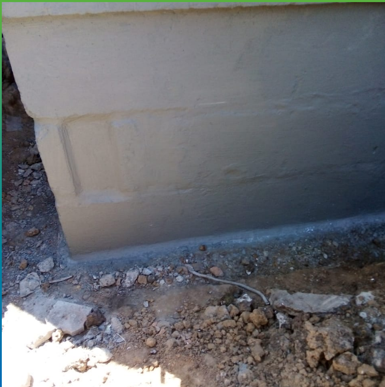
Стармекс Сил Флекс, уложенный на поверхность блоков фундамента
