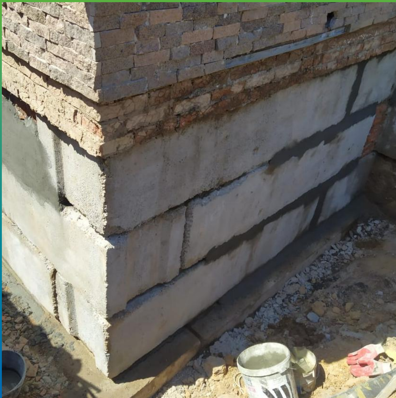
Очистка стен перед укладкой гидроизоляционного состава Стармекс Сил Флекс
