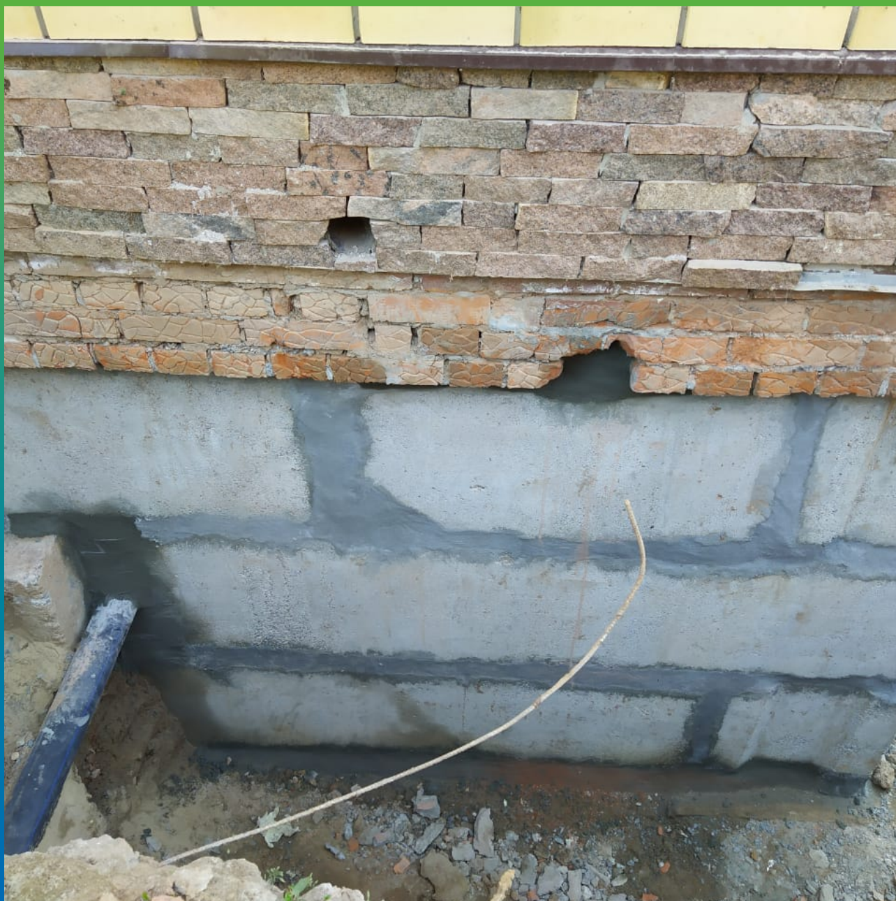
Швы, зачеканенные составом Стармекс РМЗ
