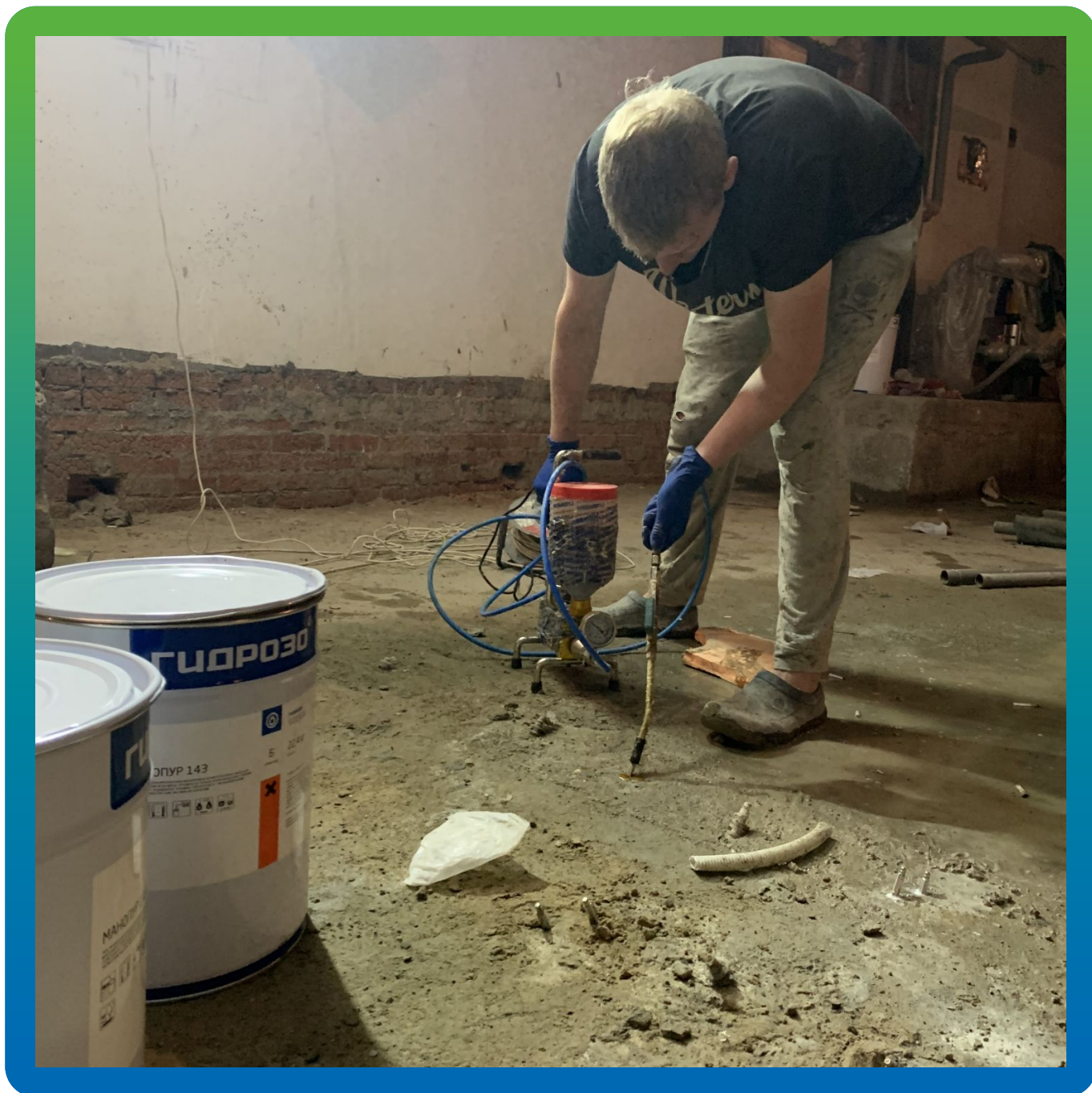
Прокачивание инъекционного состава в шпур
