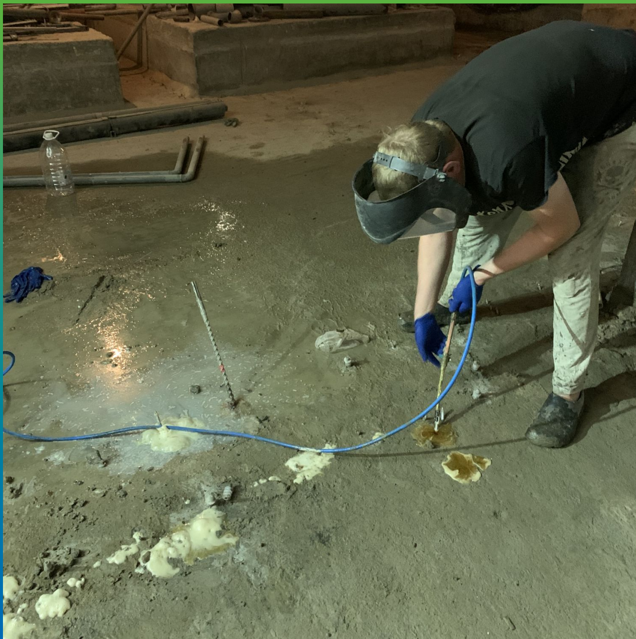
Прокачивание инъекционного состава до выхода материала из соседнего шпура
