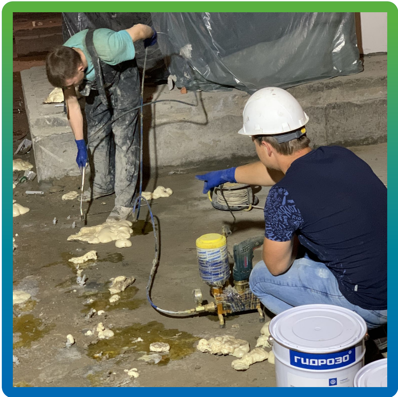
Процесс инъектирования
