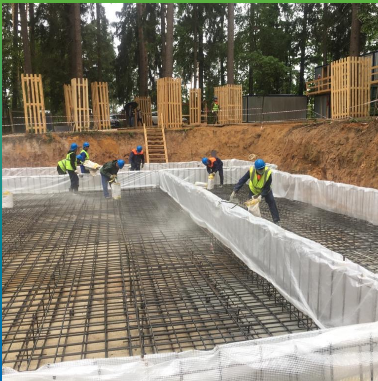
Гидроизоляция фундаментной плиты методом просыпки
