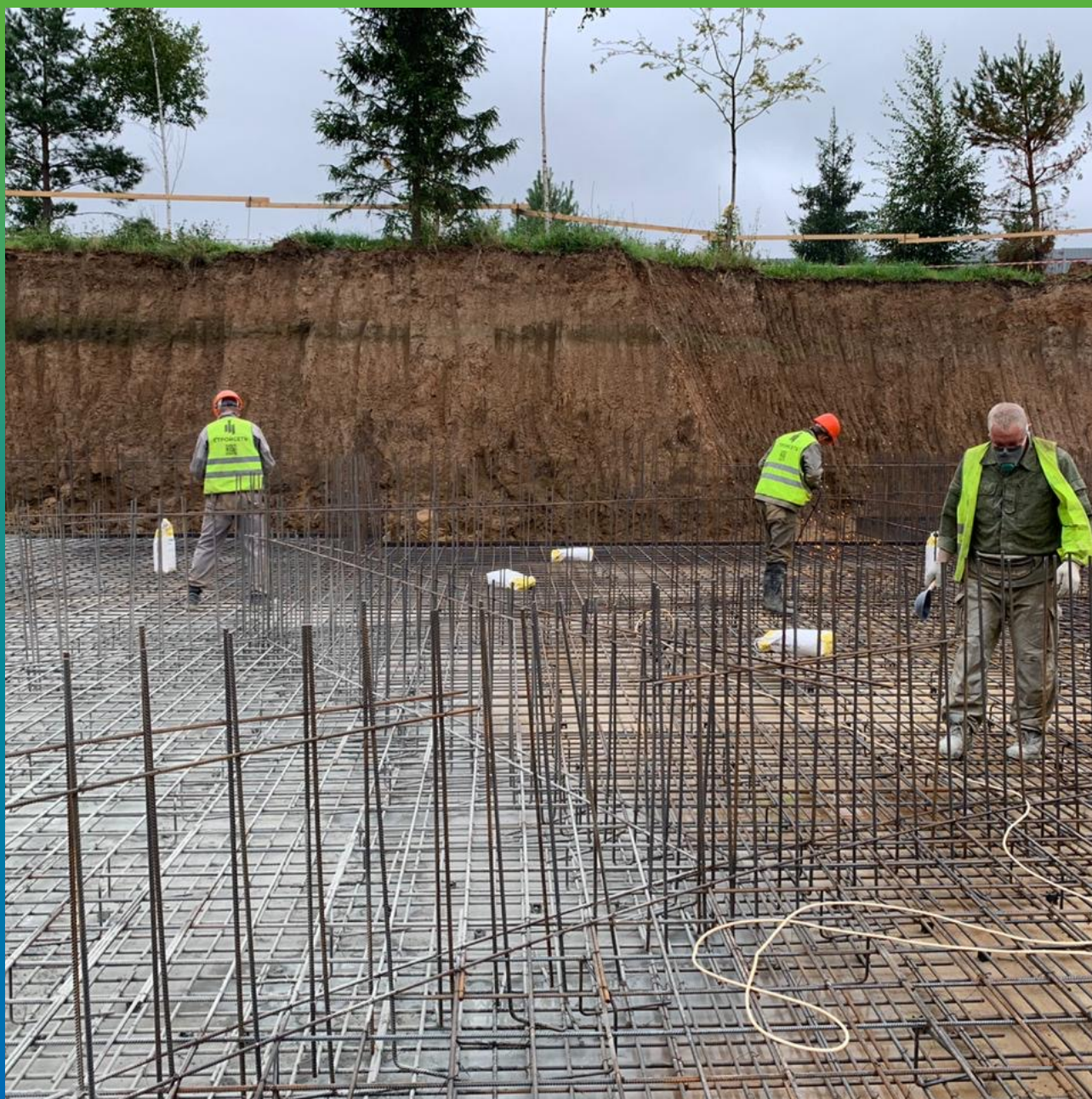
Гидроизоляция фундаментной плиты основания просыпкой Стармекс Сил
