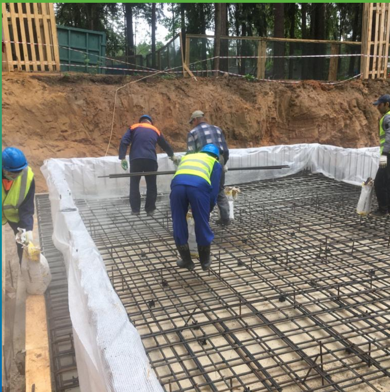
Гидроизоляция фундаментной плиты основания Стармекс Сил
