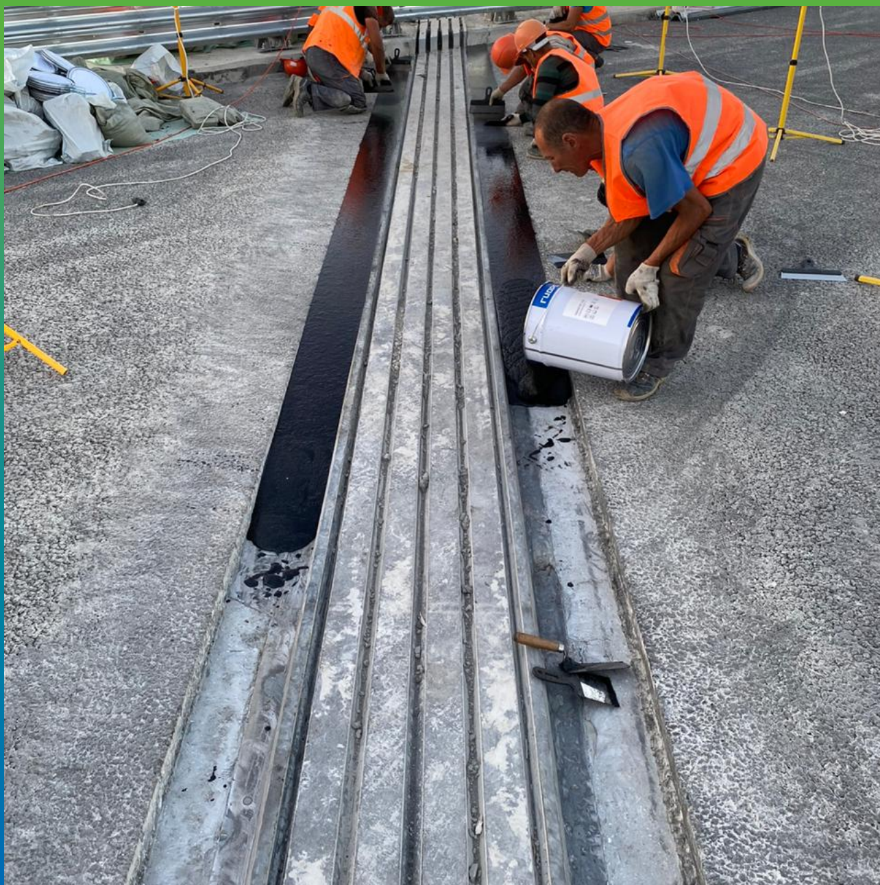
Заливка готового состава в штробу.
