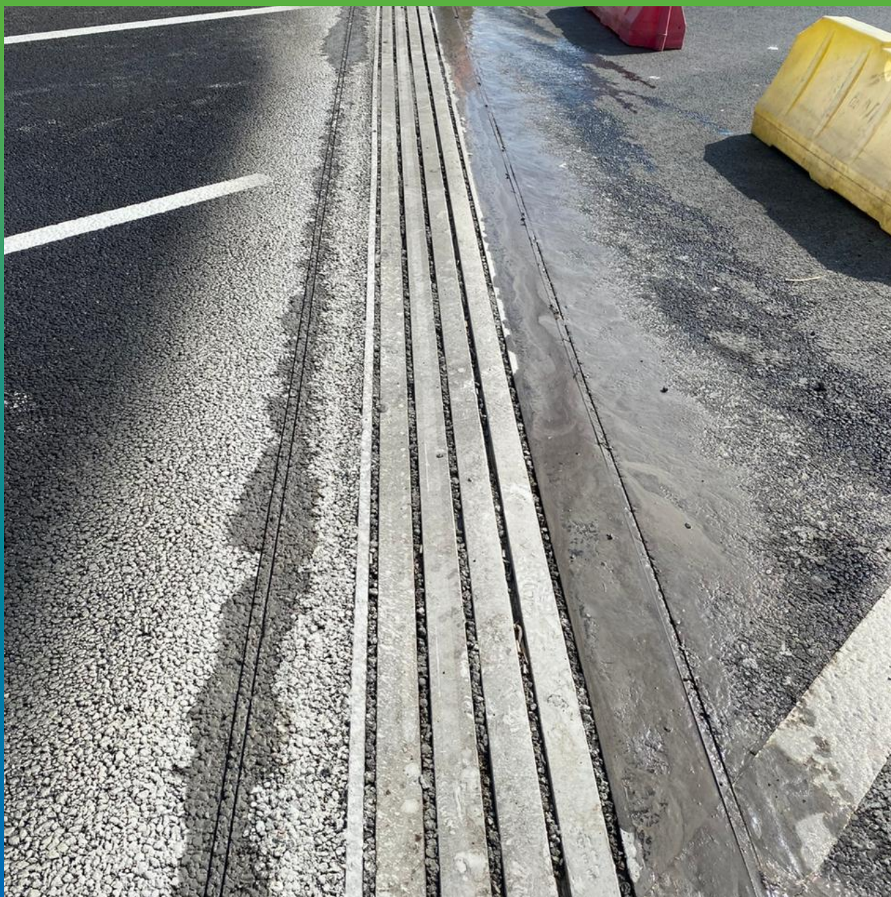
Устройство пропилов в асфальтобетоне швонарезчиком.
