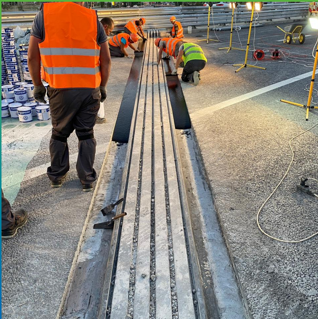
Заливка готового состава в штробу. Выравнивание при помощи шпателя.
