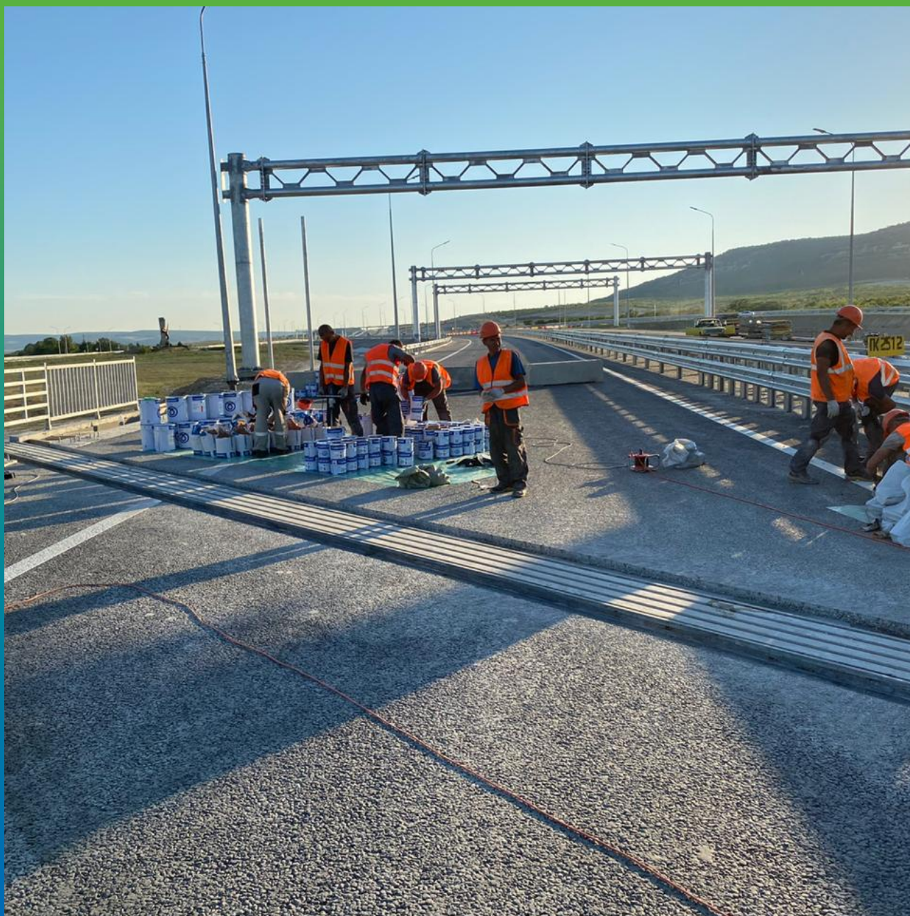
Подготовка и замес материала к укладке в штробу.
