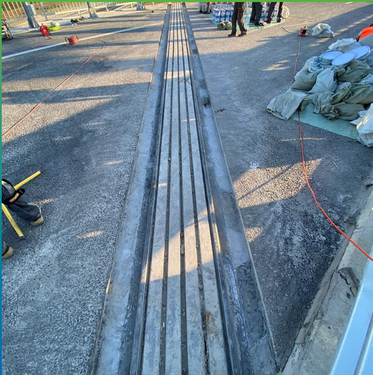
Очистка штробы после демонтажа асфальтобетона
