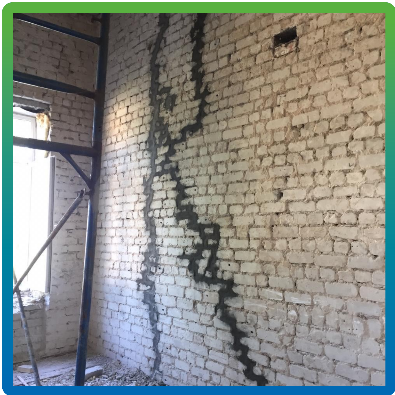
Отремонтированные стены спортзала
