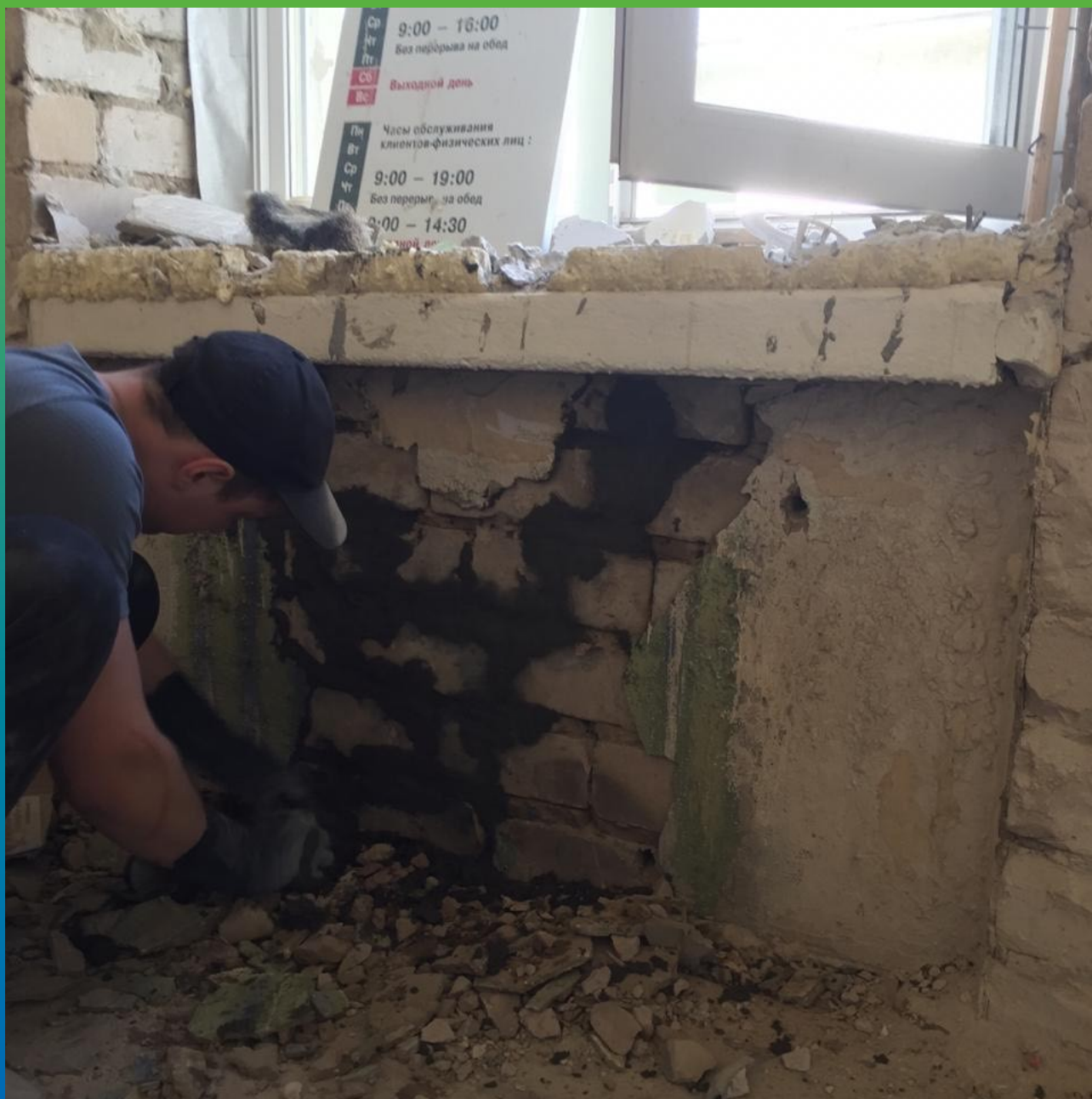
Зачеканка трещин ремонтным составом Стармекс РМЗ
