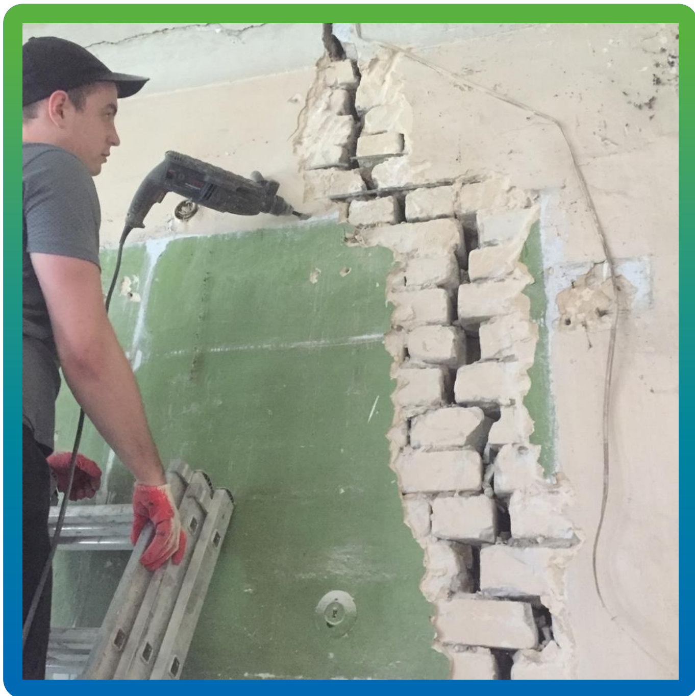
Демонтаж штукатурки для производства последующих ремонтных работ
