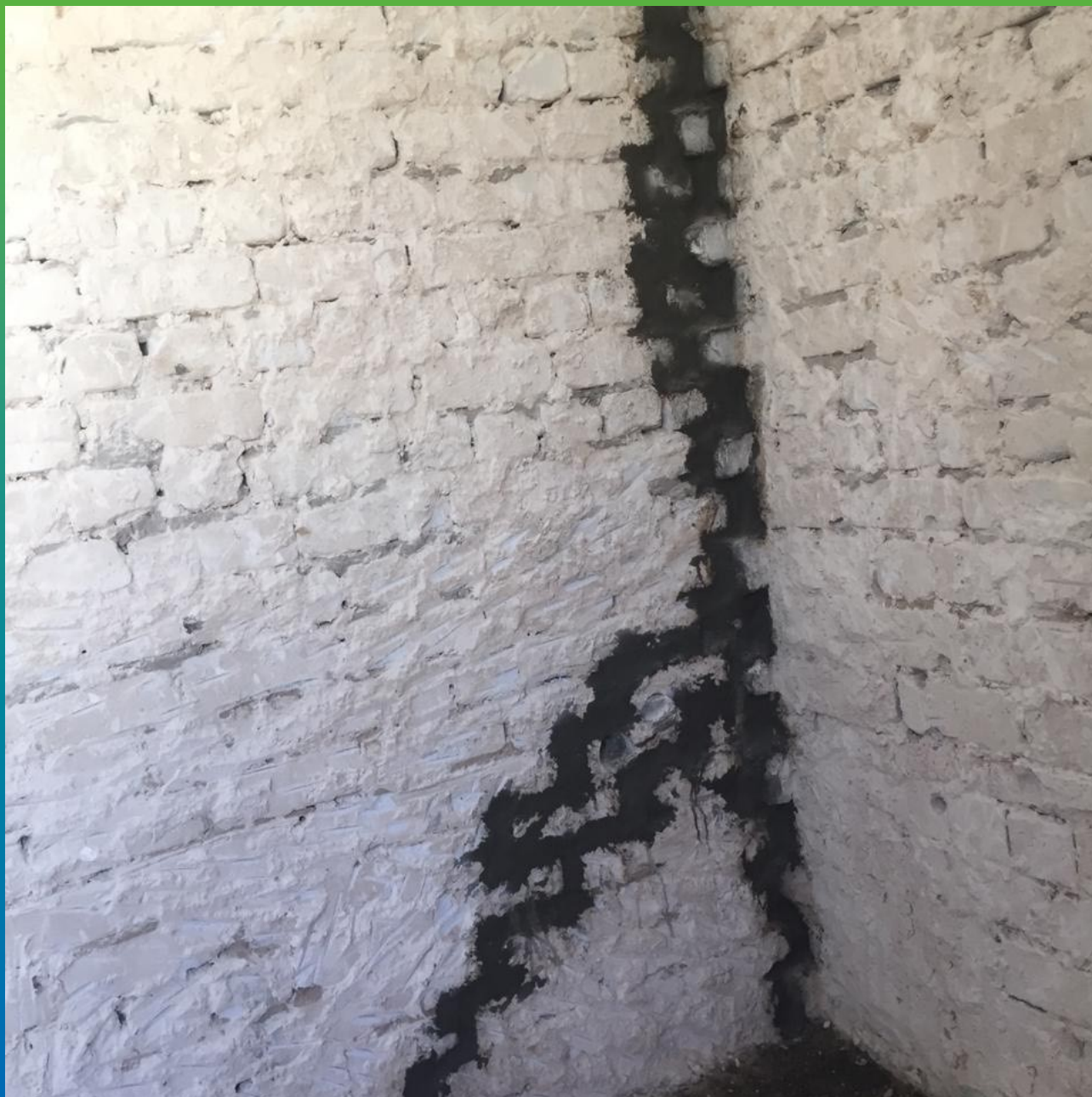
Зачеканка трещин ремонтным составом Стармекс РМЗ
