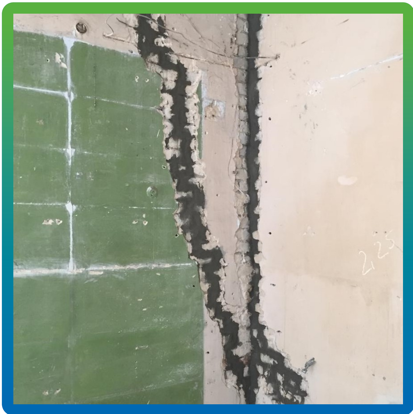
Зачеканка трещин ремонтным составом Стармекс РМЗ
