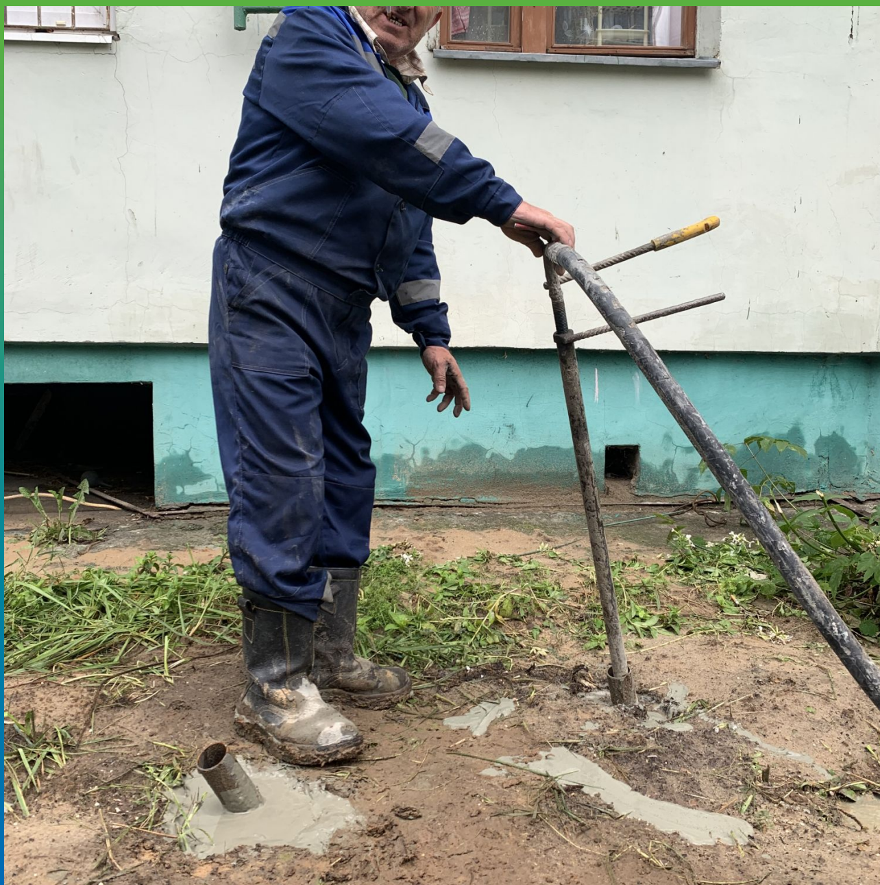
Нагнетание состава Маноцем Файн в скважину
