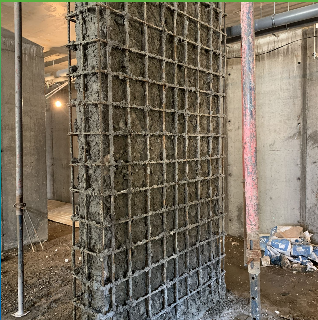
Состав, нанесенный на колонну в один слой
