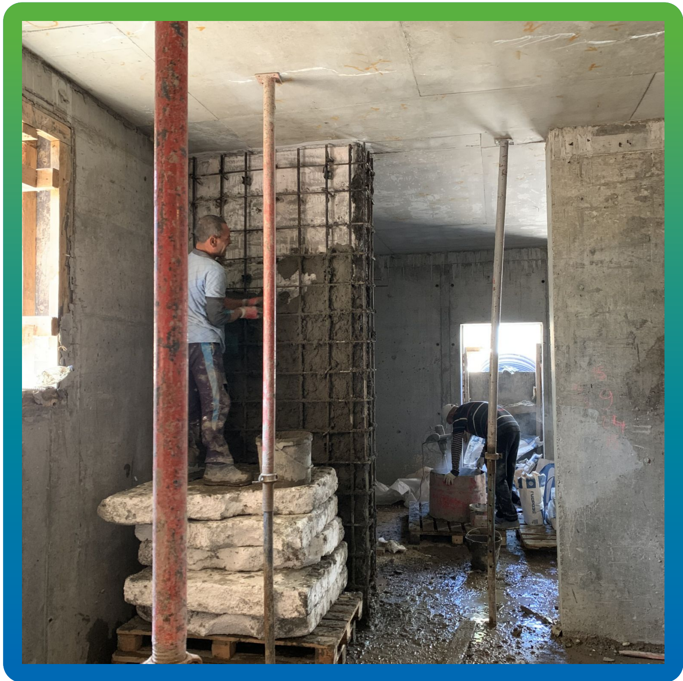
Нанесение состава Стармекс РМЗ на колонну
