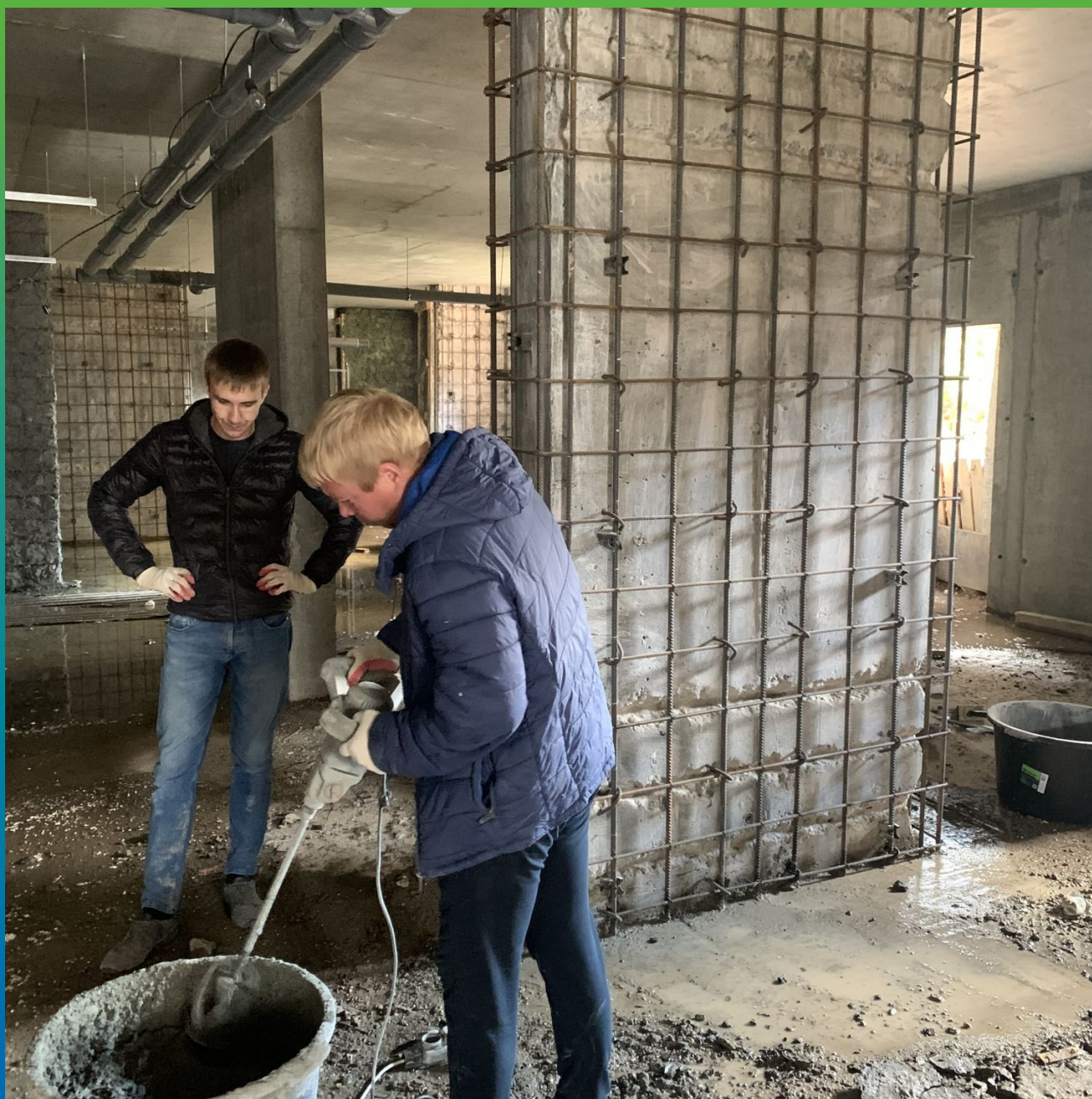
Приготовление состава для проведения работ по арматурному каркасу, закрепленному на колонну
