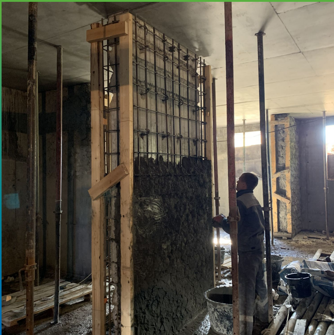
Нанесение состава Стармекс РМЗ на колонну
