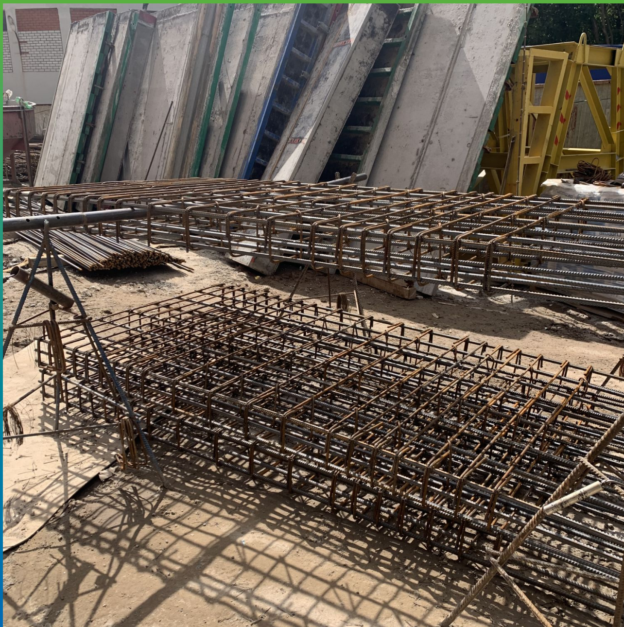
Арматурный каркас, подготовленный для монтажа на колонну
