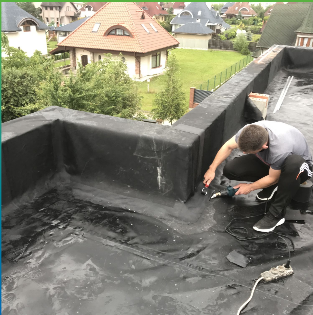
Обварка узлов примыканий
