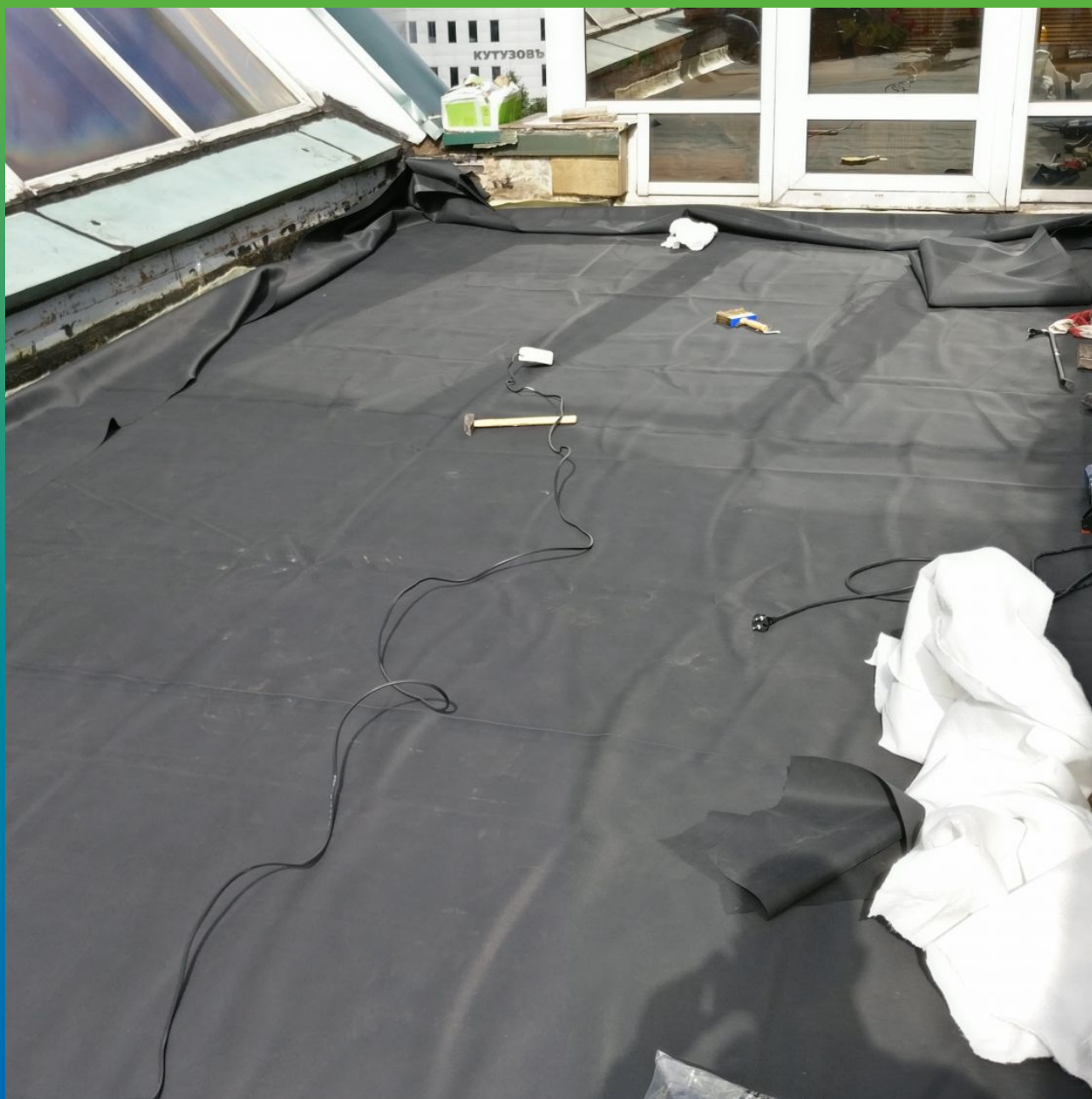
Разравнивание Мембраны ЭПДМ Преласта СТ по основанию
