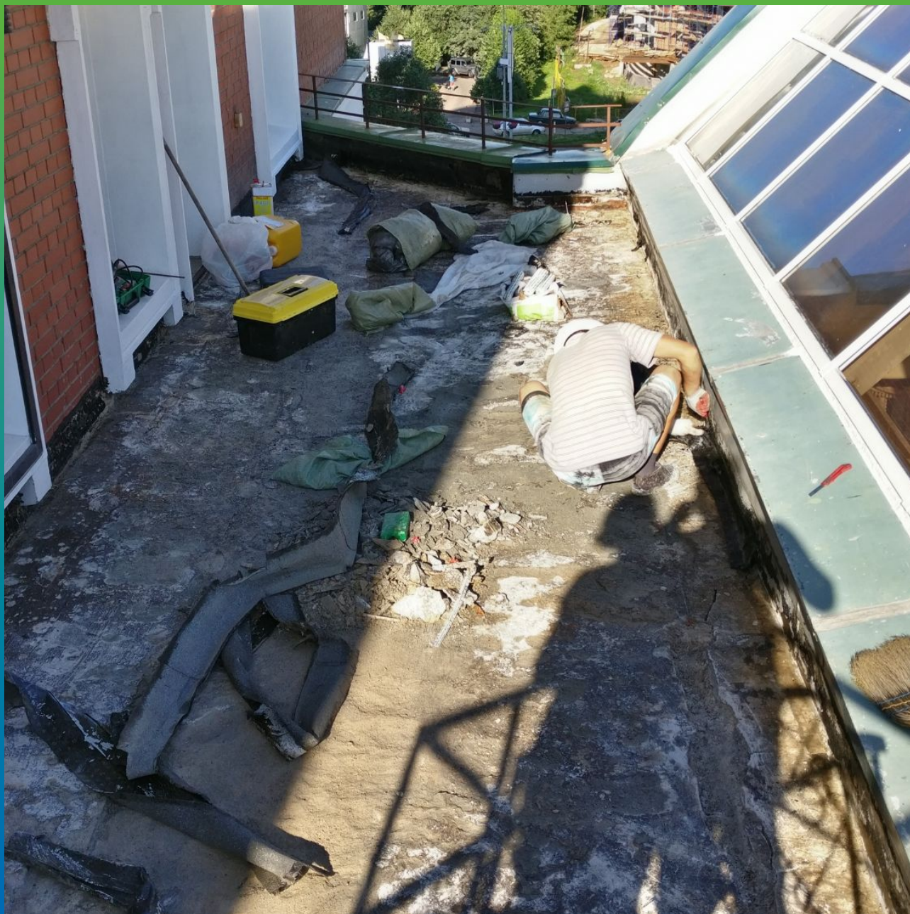
Демонтаж битумного материала и подготовка основания
