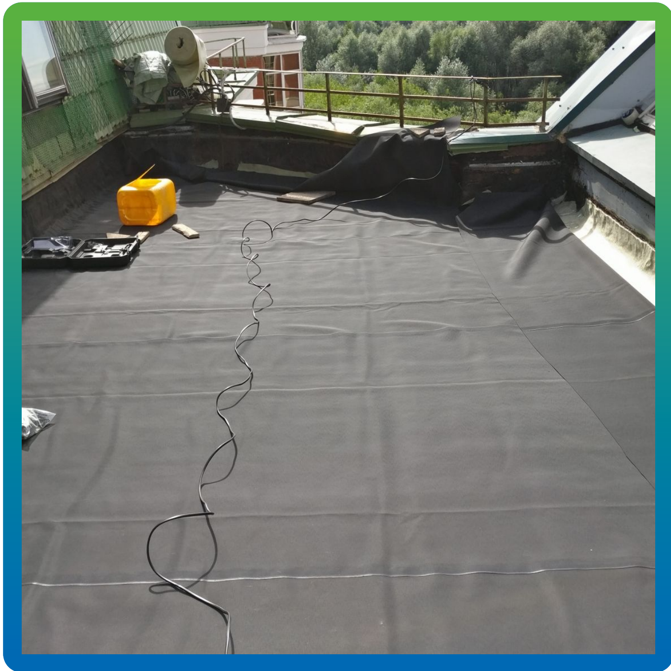
Заведение на вертикальные основания и проклеивание
