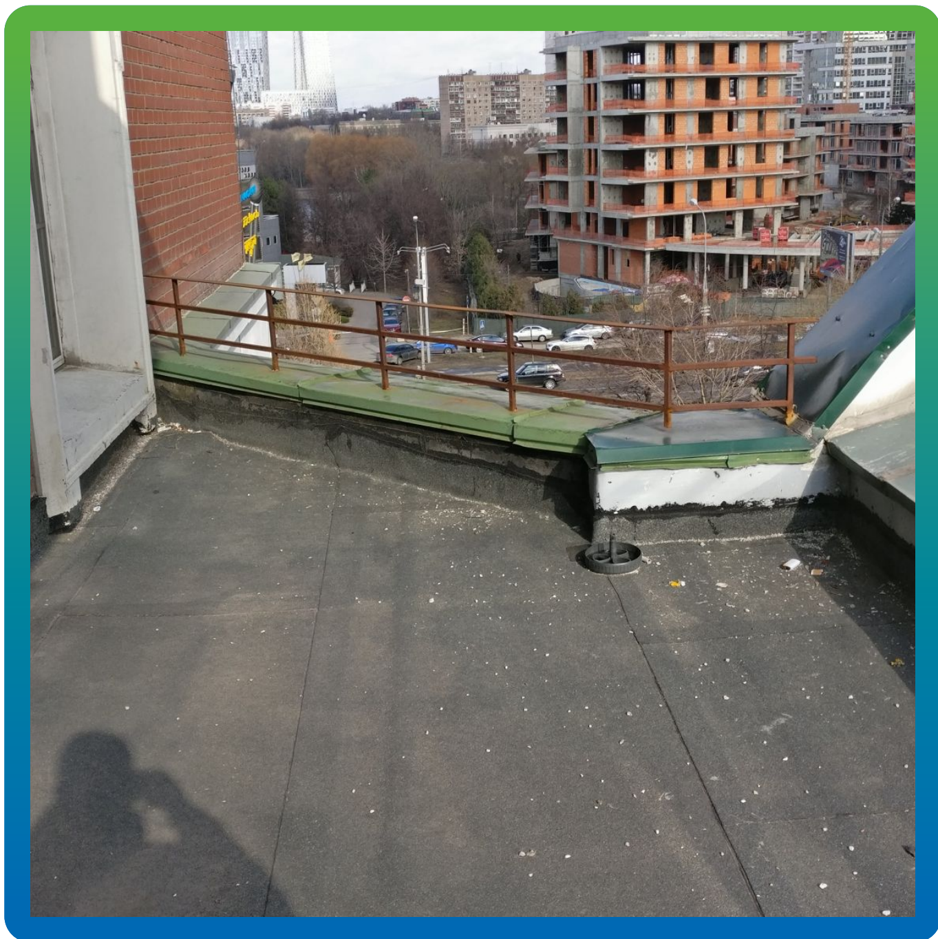
Вид объекта до начала работ
