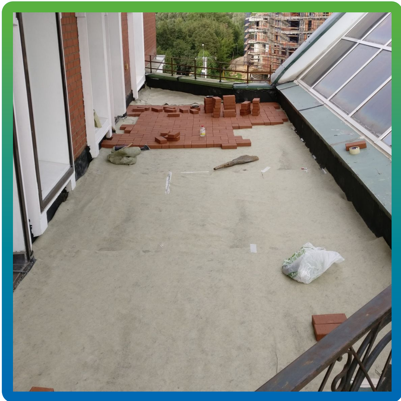
Расстил защитного слоя геотекстиля и последующая укладка плитки.
