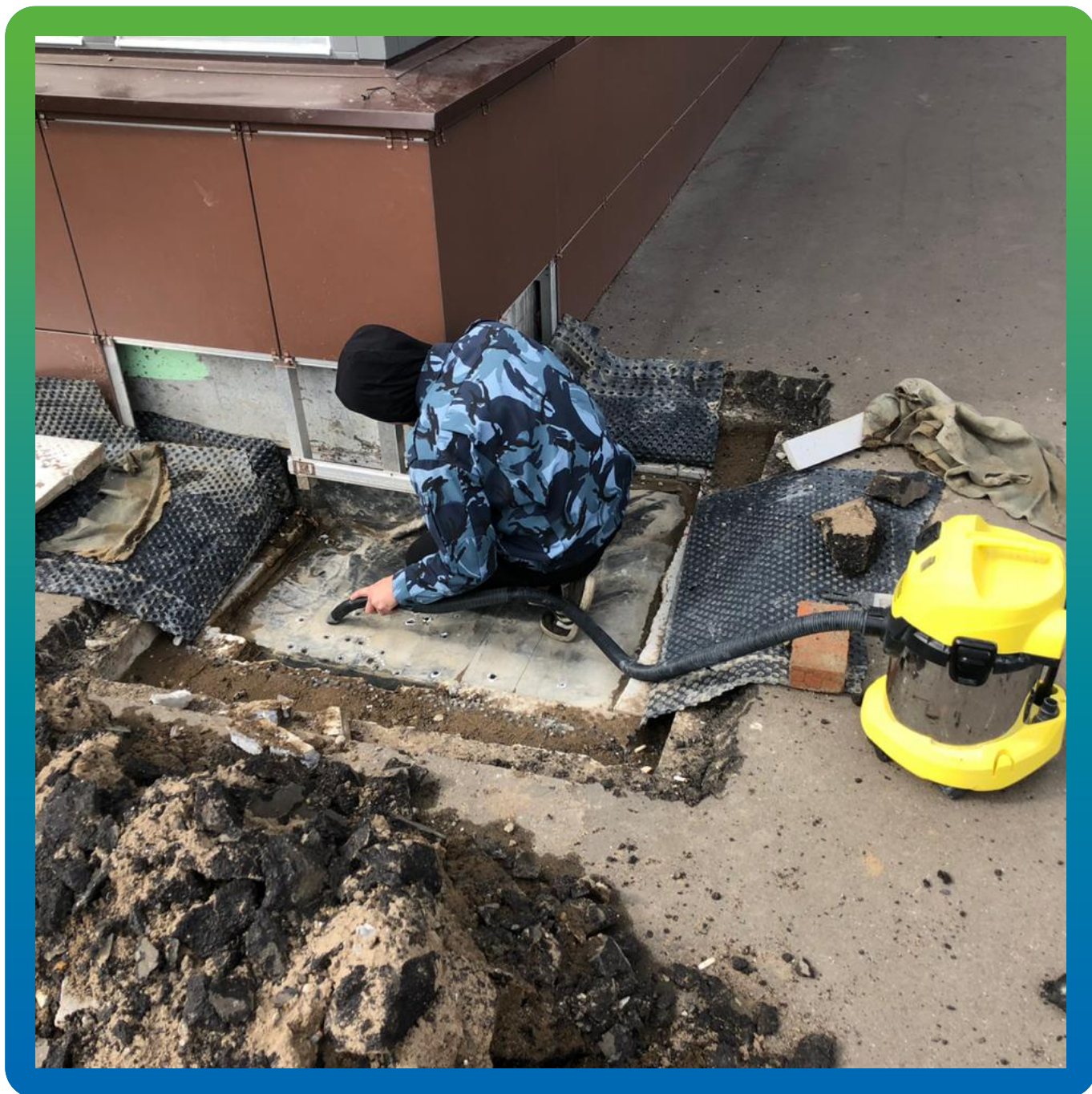
Очистка участков для ремонта
