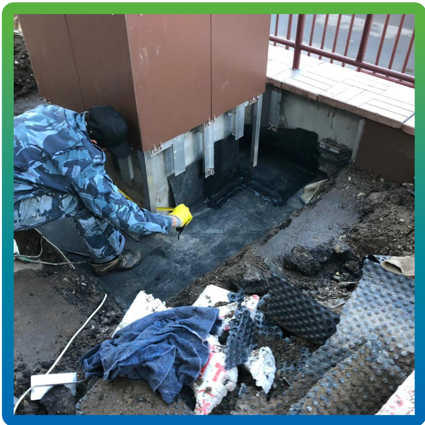
Процесс ремонта и восстановления гидроизоляции
