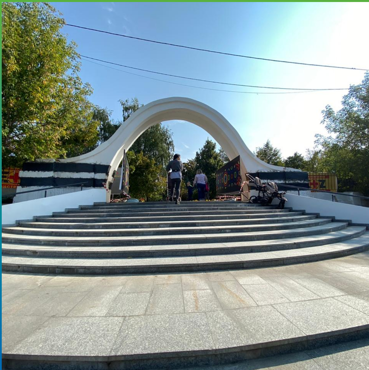
Армошел, монтированный на арку
