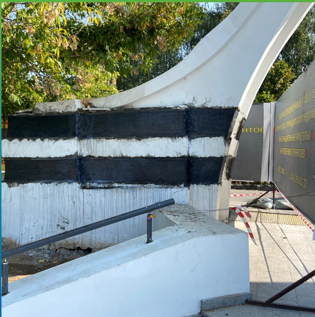
Армошел, монтированный на арку
