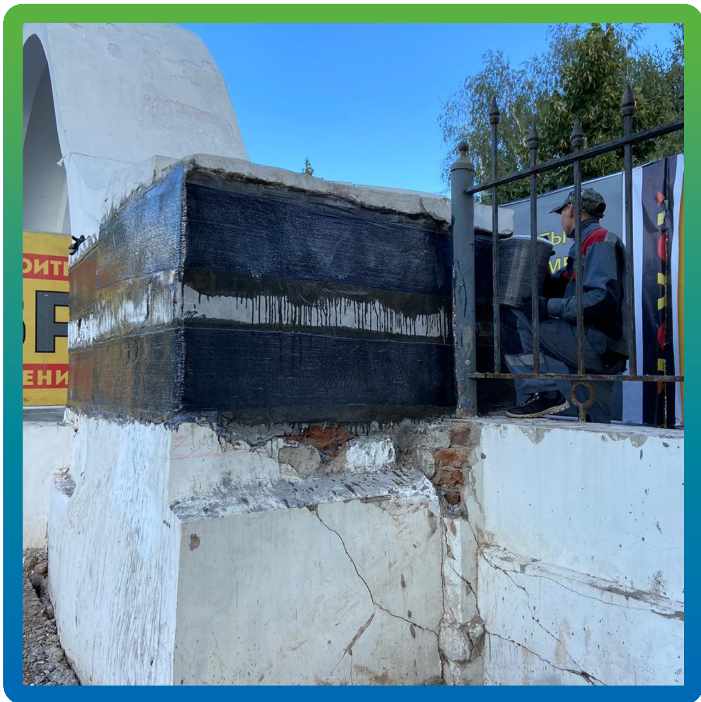
Монтаж системы Армошел
