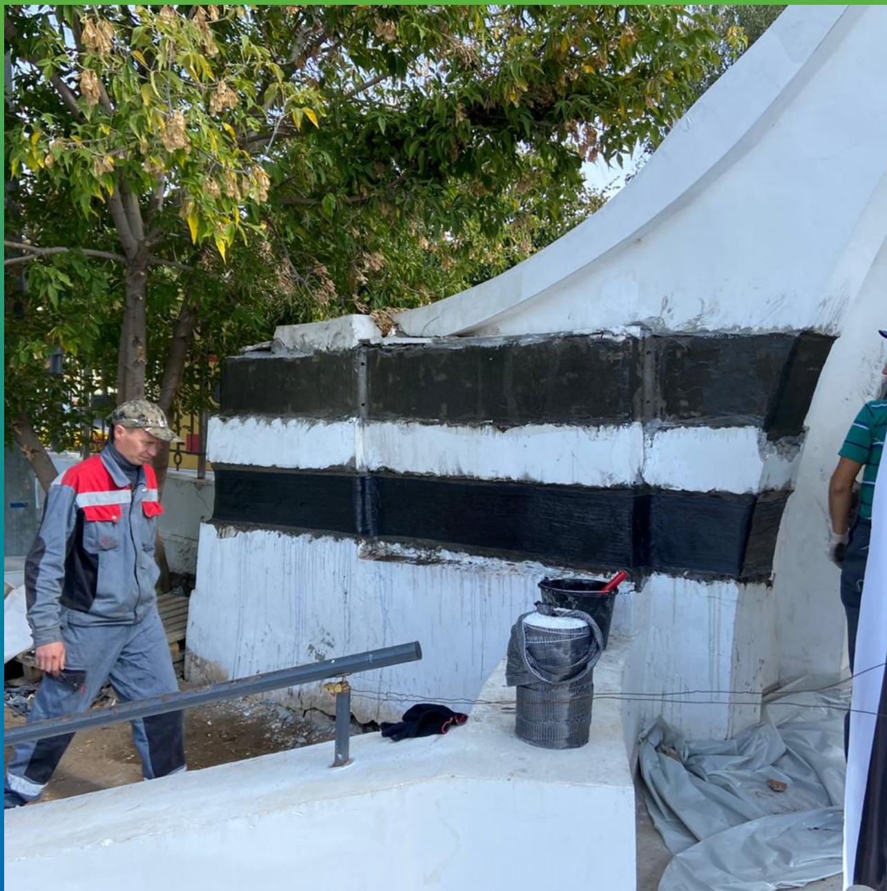
Монтаж системы Армошел
