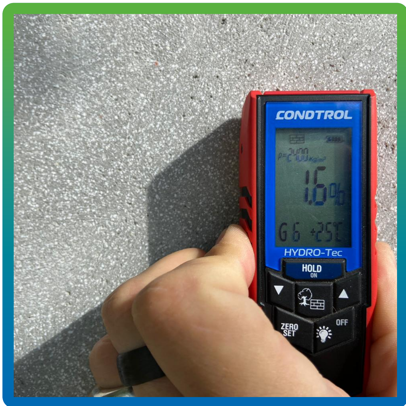
Замер влажности основания перед устройством системы Армешел
