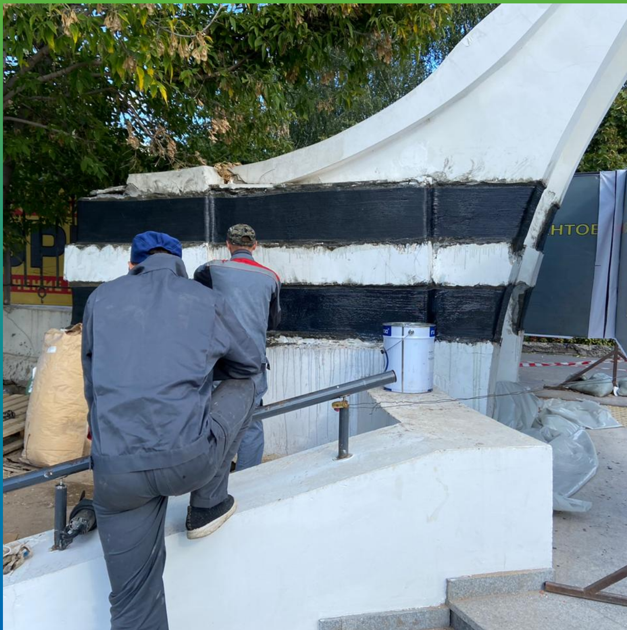
Монтаж системы Армошел
