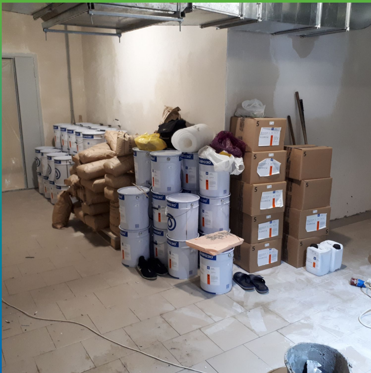
Материалы Гидрозо на объекте
