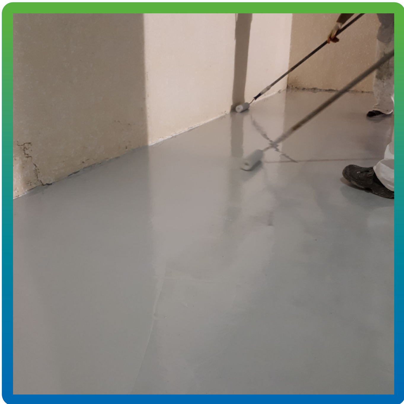
Накатка валиками несколько слоев эпоксидного покрытия ДенТоп ЭП 501
