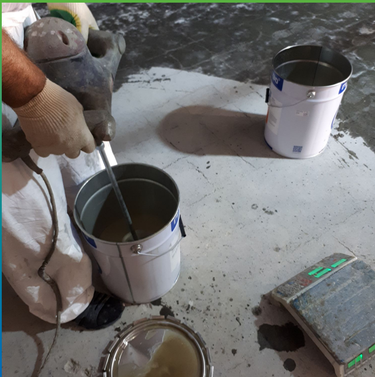
Замешивание грунтовки ДенТоп ЭП 104
