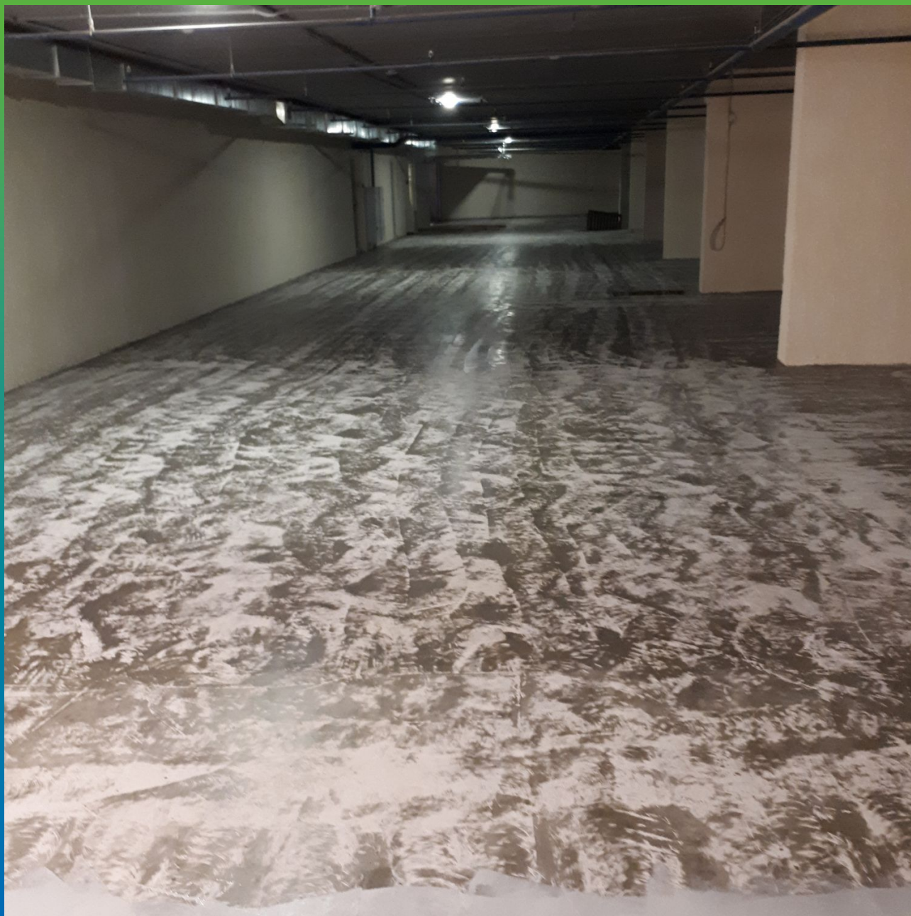
Насечки на загрунтованной поверхности перед нанесением финишного цветного полимерного покрытия
