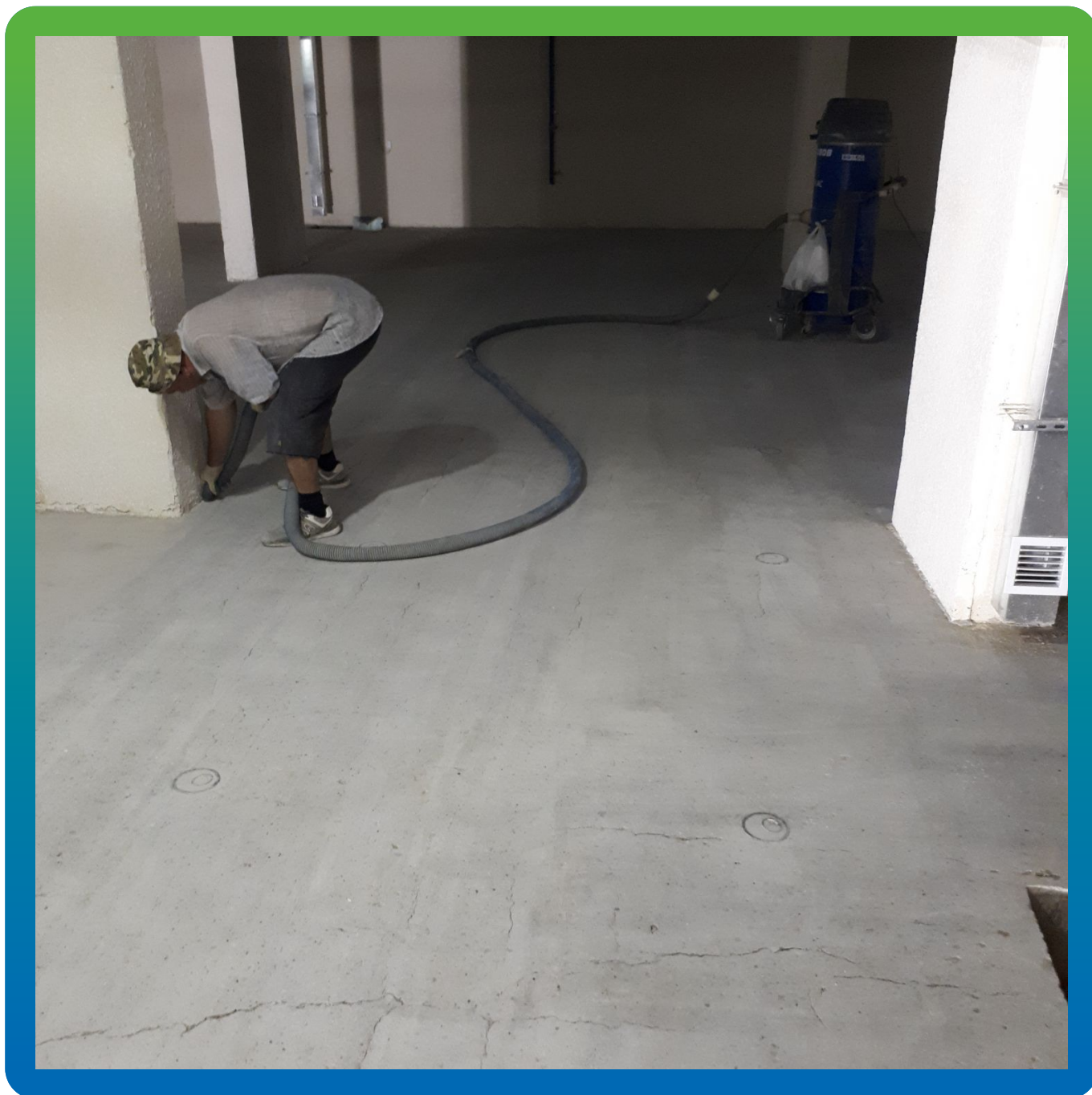
Обеспыливание промышленным пылесосом
