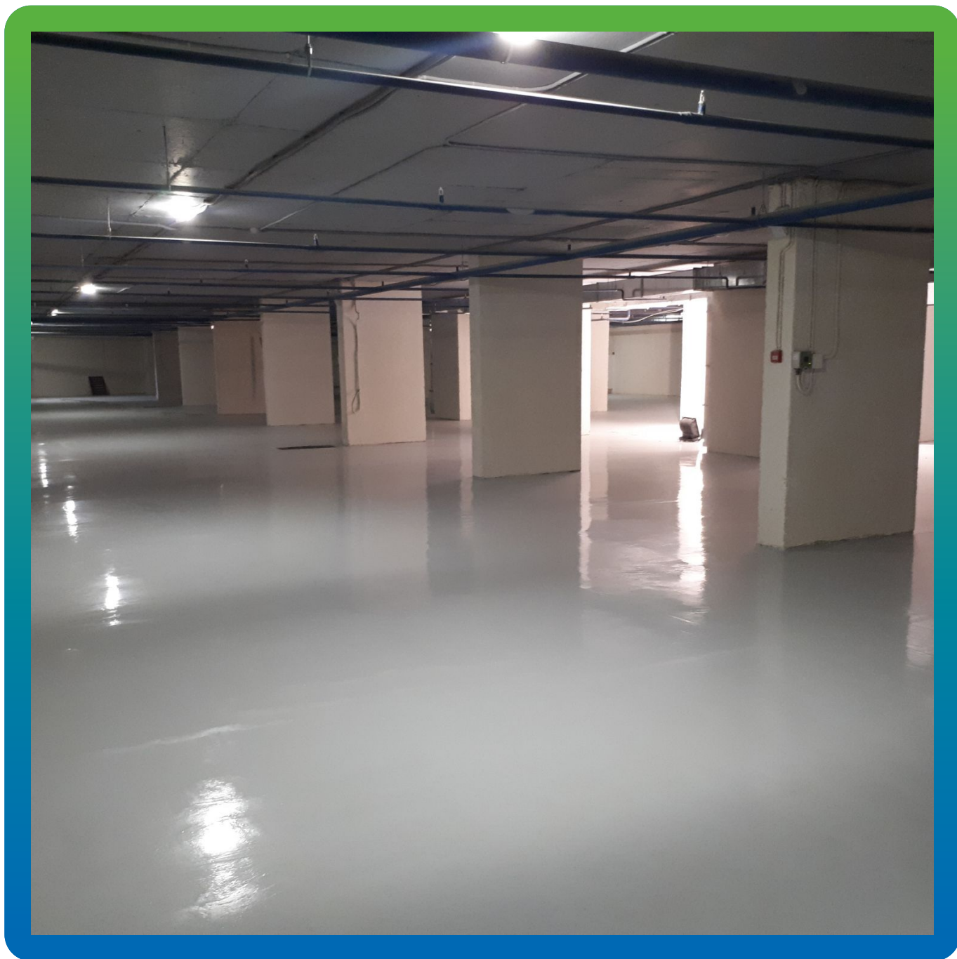
Вид паркинга, покрытого ДенТоп ЭП 501
