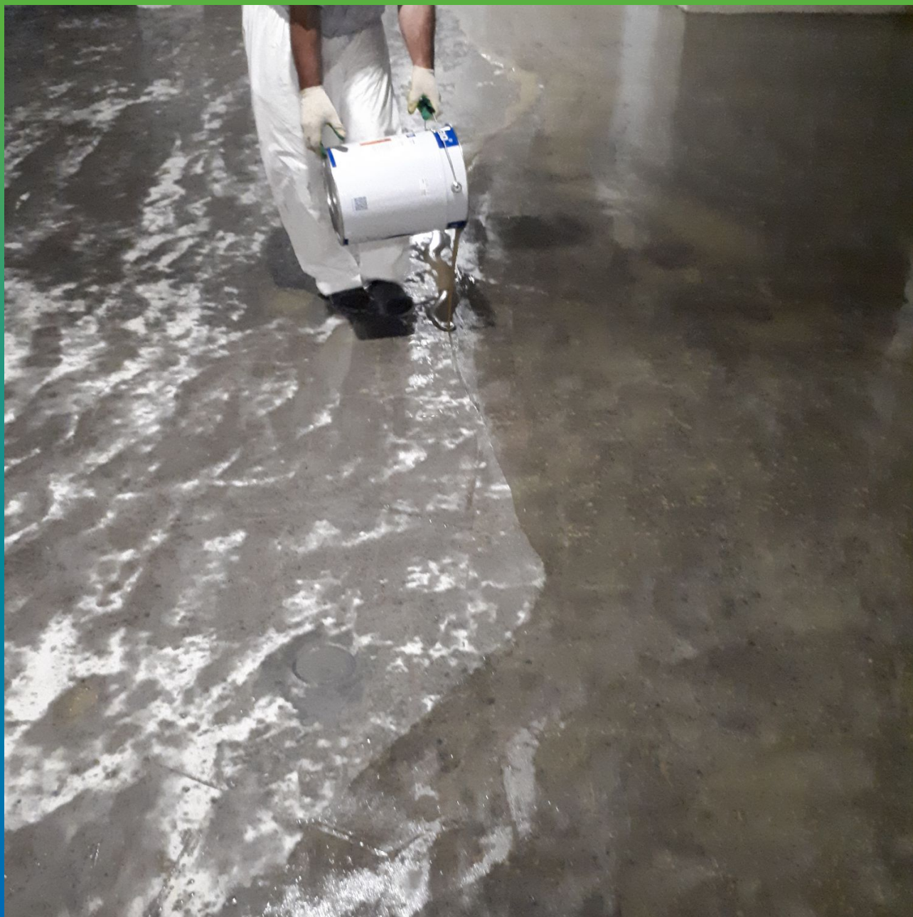
Распределение грунтовки по поверхности равномерным проливанием
