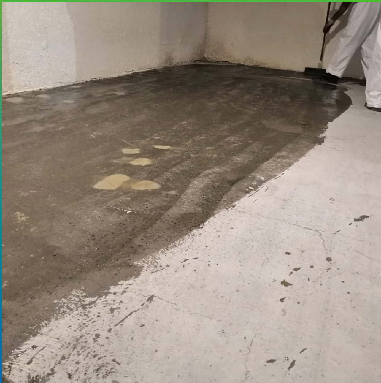
Покрытие первым слоем грунтовки ДенсТоп ЭП 104
