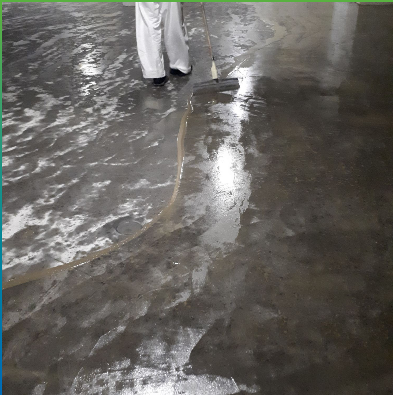
Выравнивание поверхности грунтовкой ДенсТоп ЭП 104 с кварцевым песком
