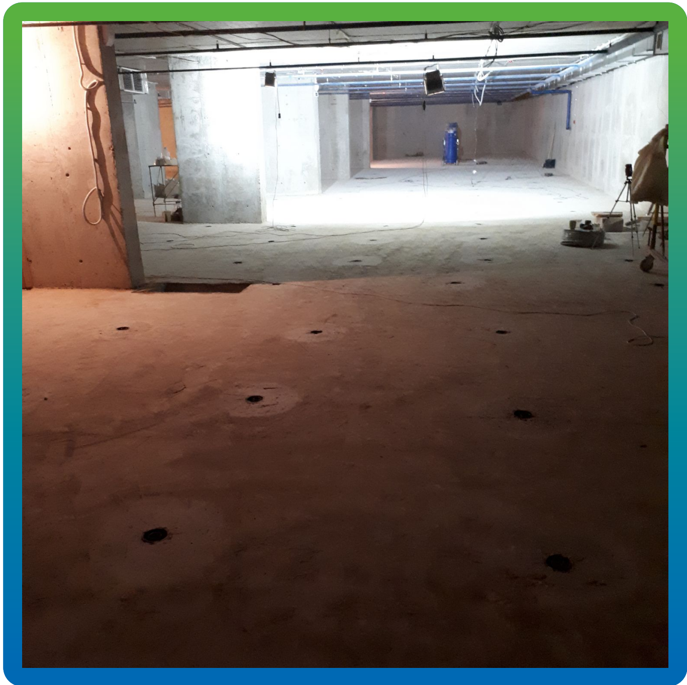
Вид отшлифованной плиты паркинга
