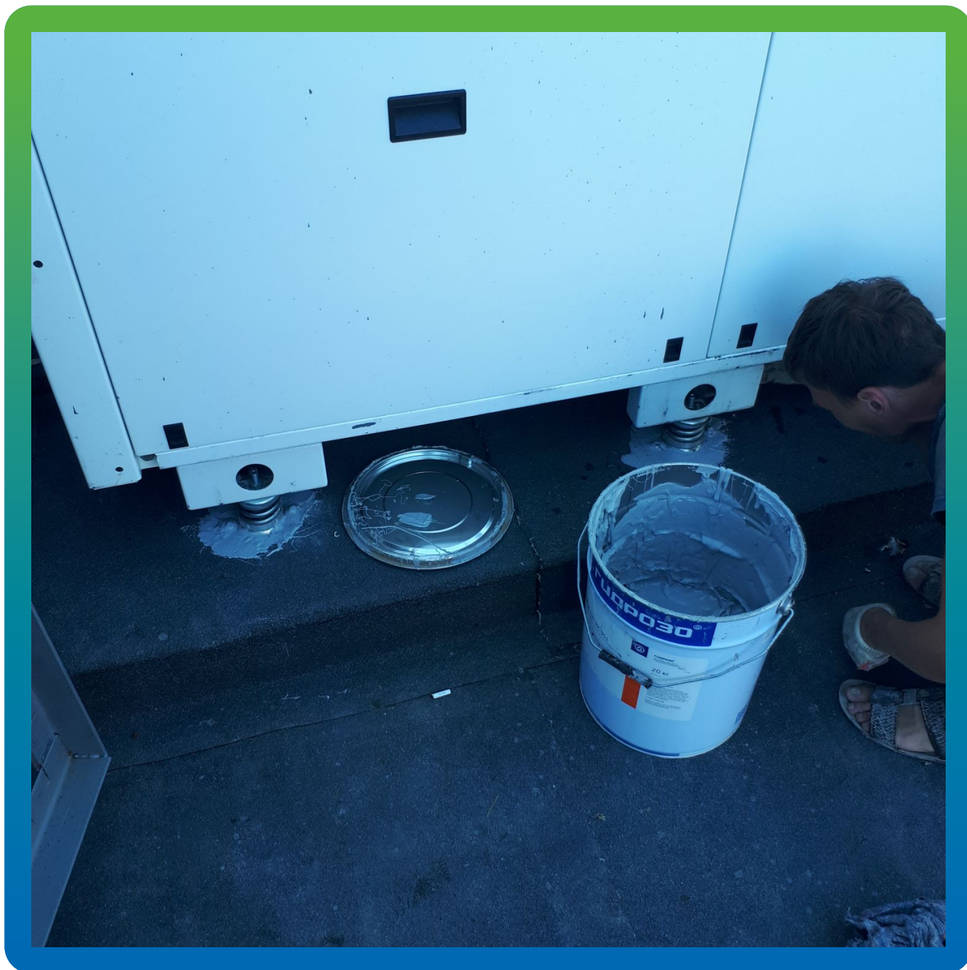
Выполненная герметизация проблемных мест материалом ДенТоп МС 351
