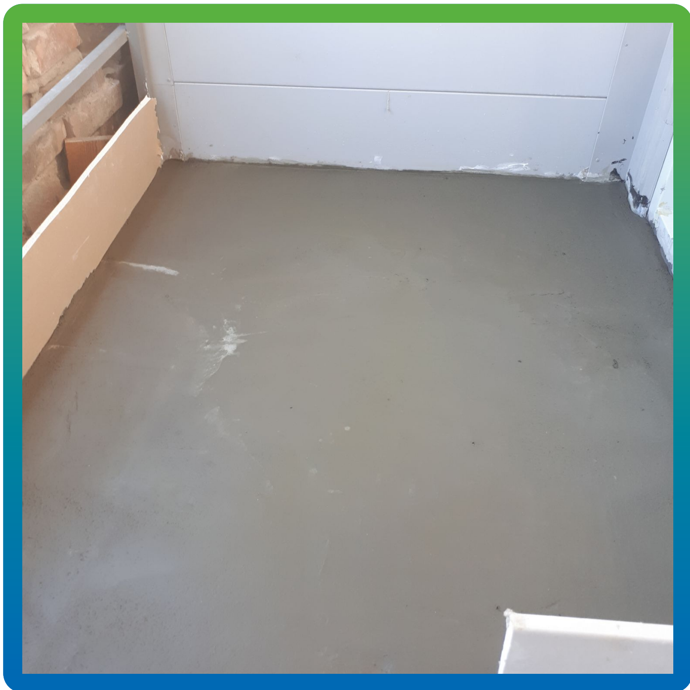
Площадка, выровненная подливочным составом Стармекс ФМ7
