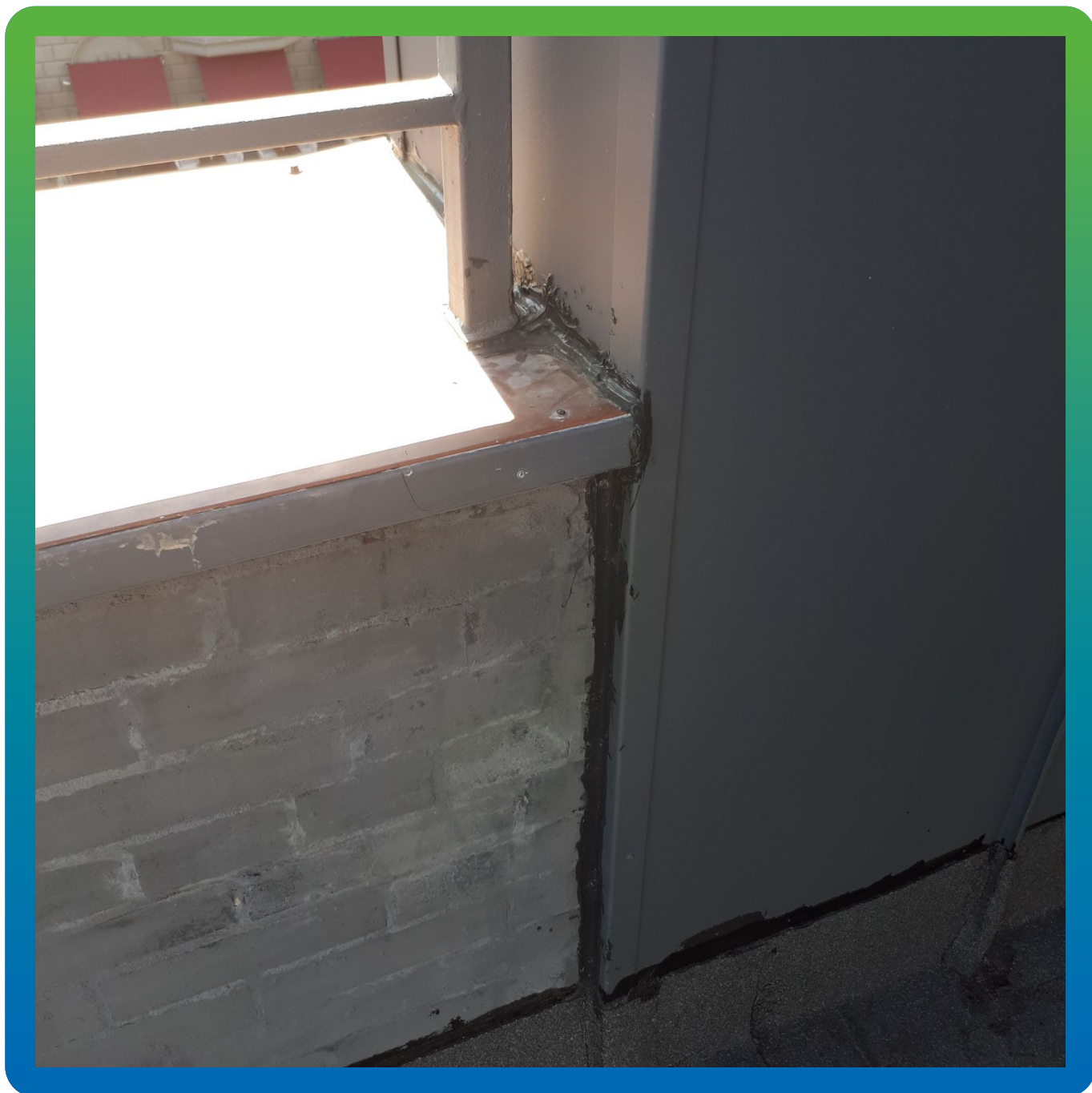
Герметизация примыканий при помощи Манодил Бонд Ф
