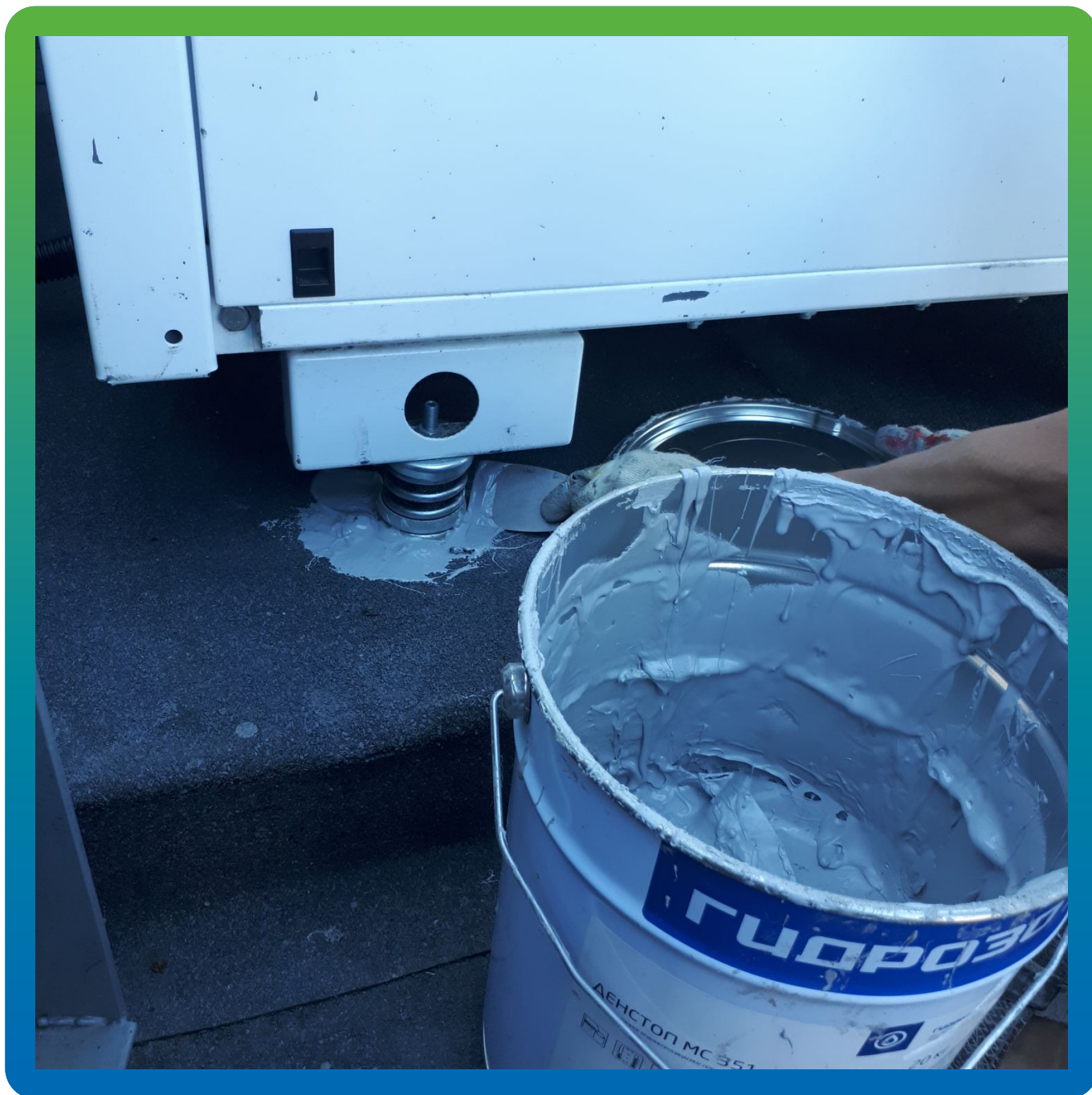
Герметизация опор при помощи эластичного состава ДенТоп МС 351
