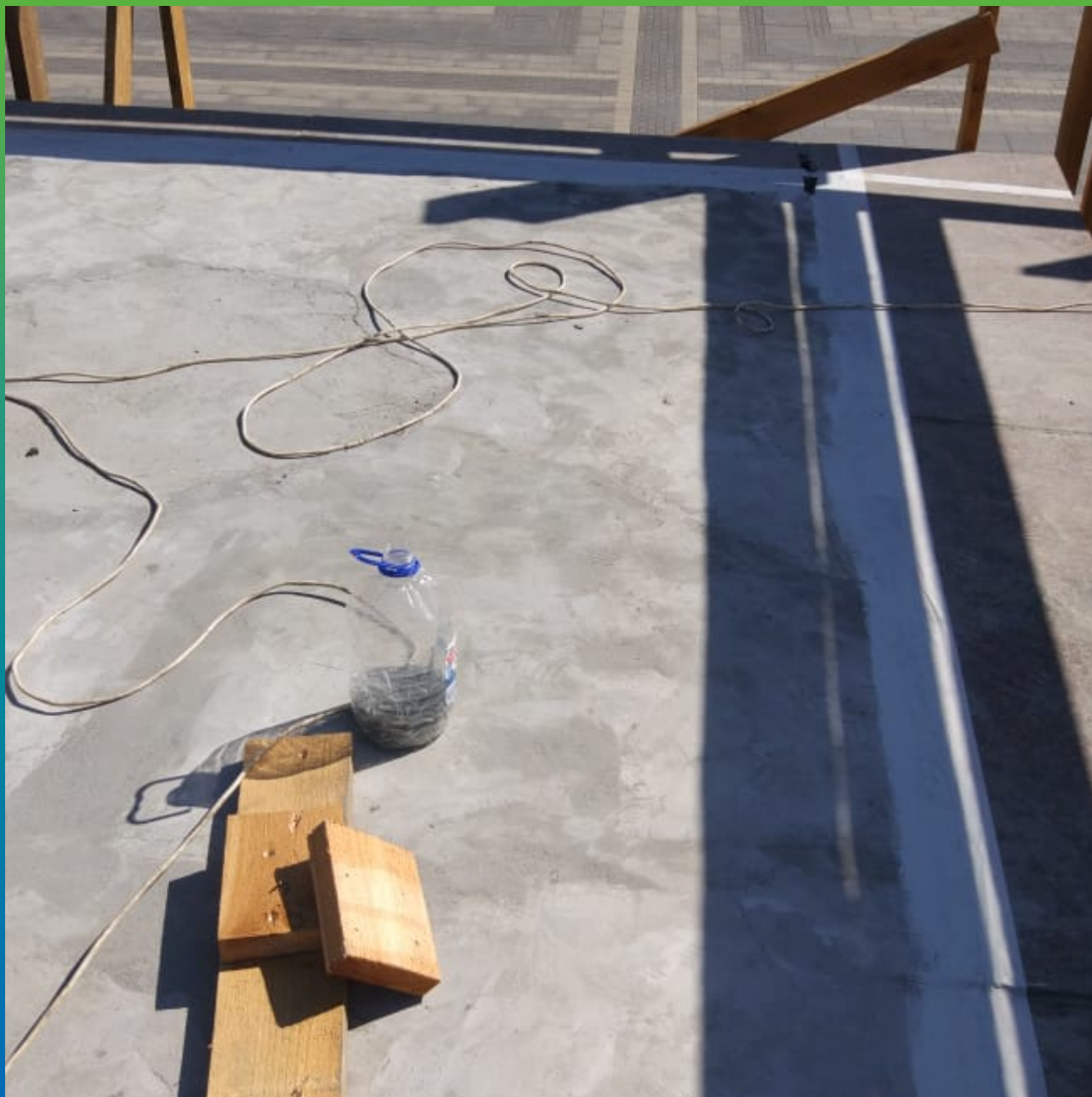
Отремонтированная поверхность перед окраской
