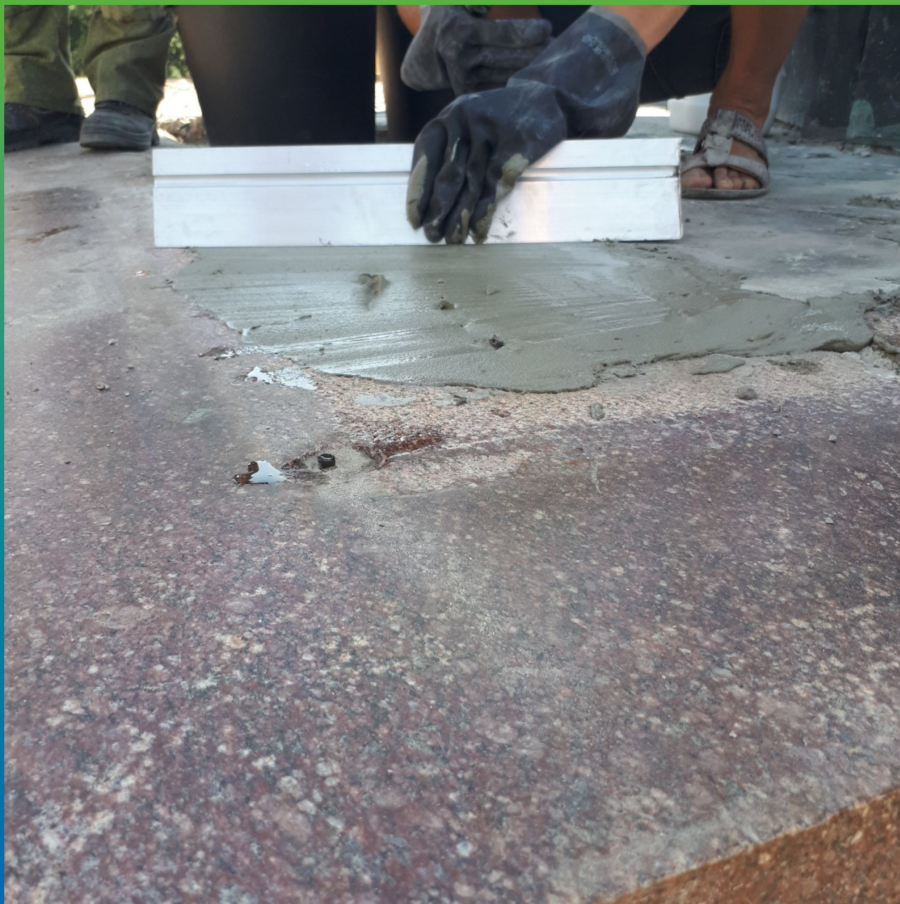
Выравнивание ремонтного состава Стармекс РМ Супер
