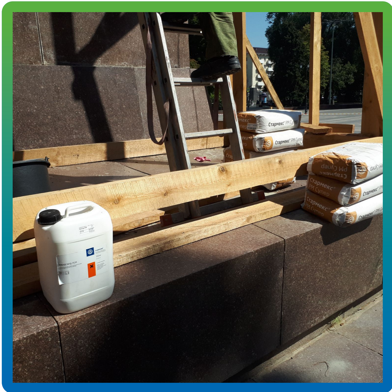
Материалы Гидрозо на объекте
