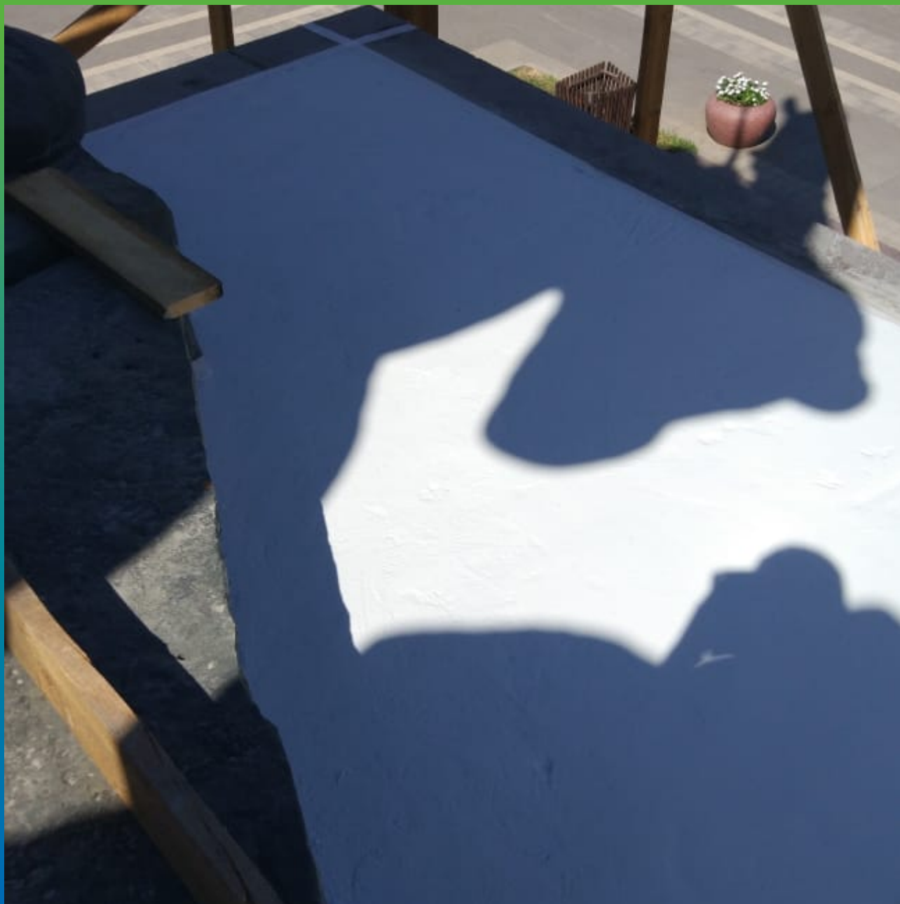
Финишный вид после окраски
