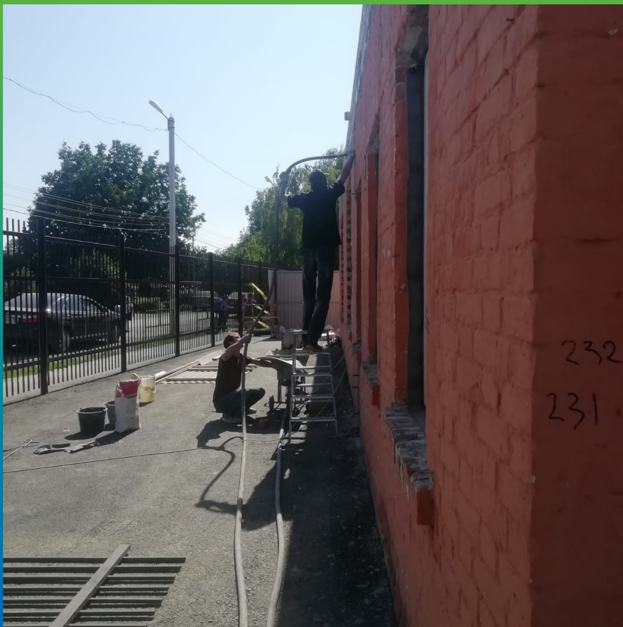
Инъектирование Маноцем Грут в трещины кирпичной кладки
