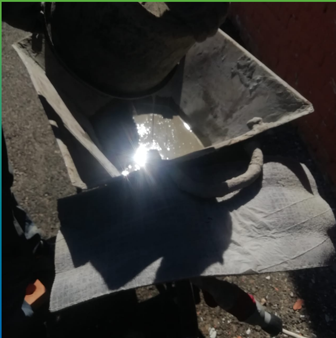
Подача материала в бункер перед инъектированием
