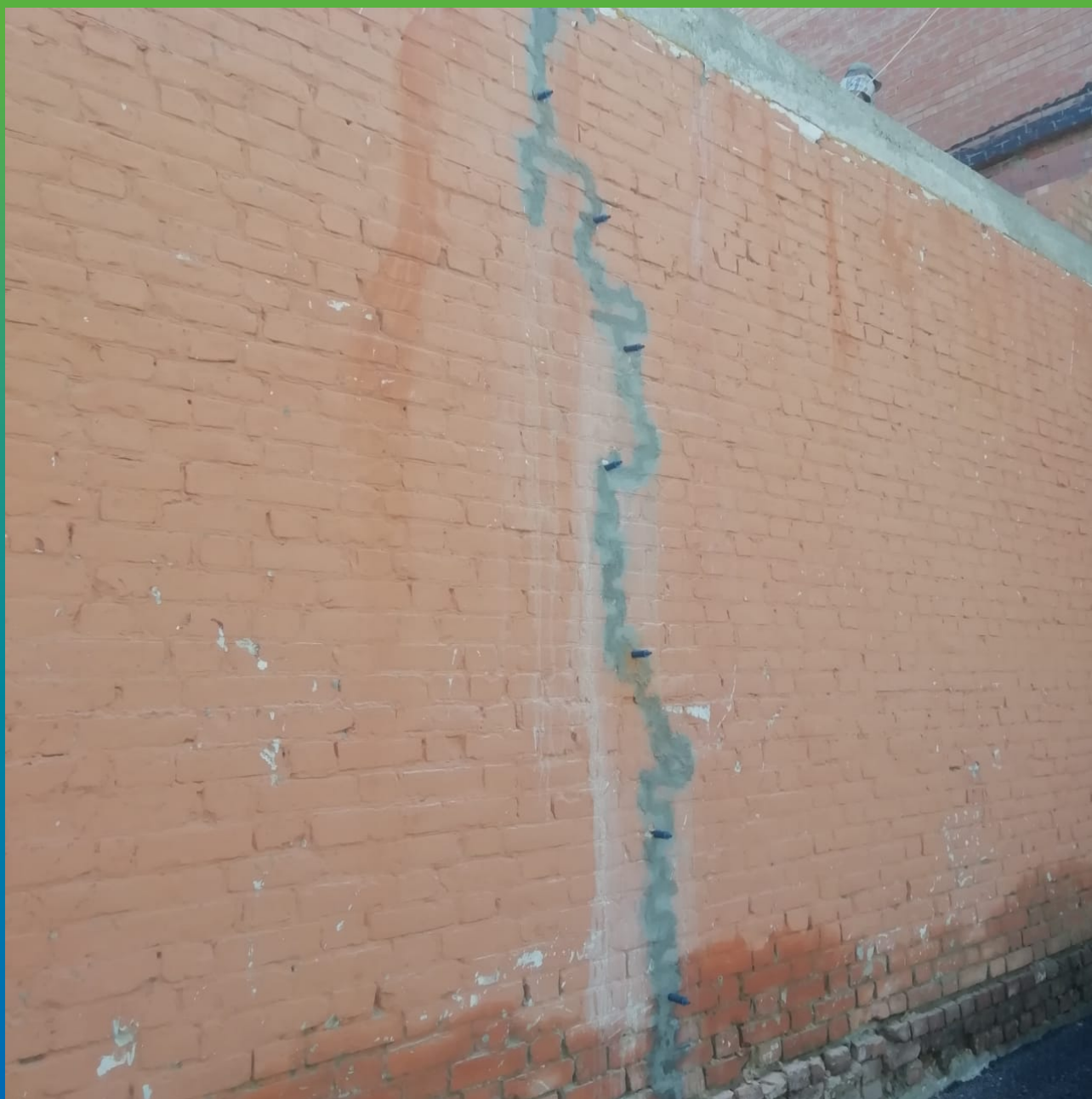
Установленные пакеры для прокачки микроцемента
