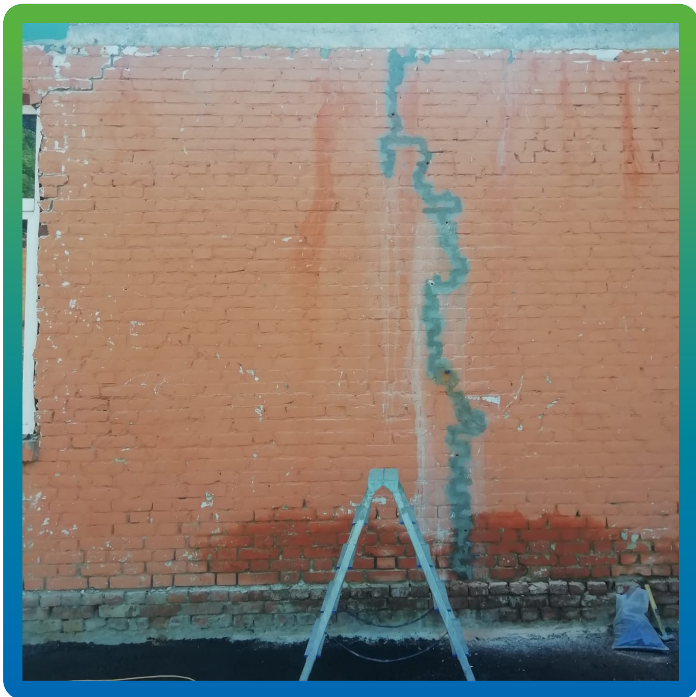
Бурение отверстий под пакеры БМ 2839
