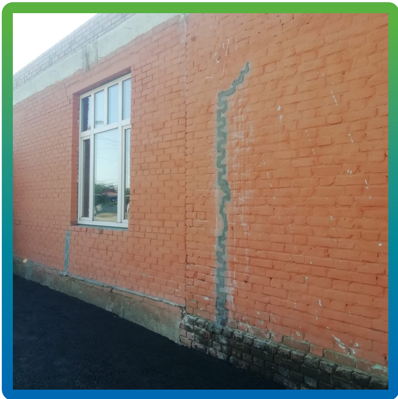
Зачеканенная рем.составом Стармекс РМЗ трещина в кирпичной кладке
