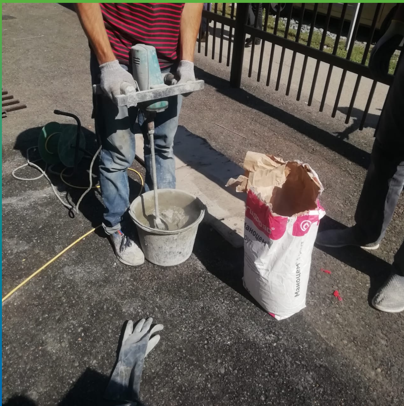
Приготовление микроцемента Маноцем Грут
