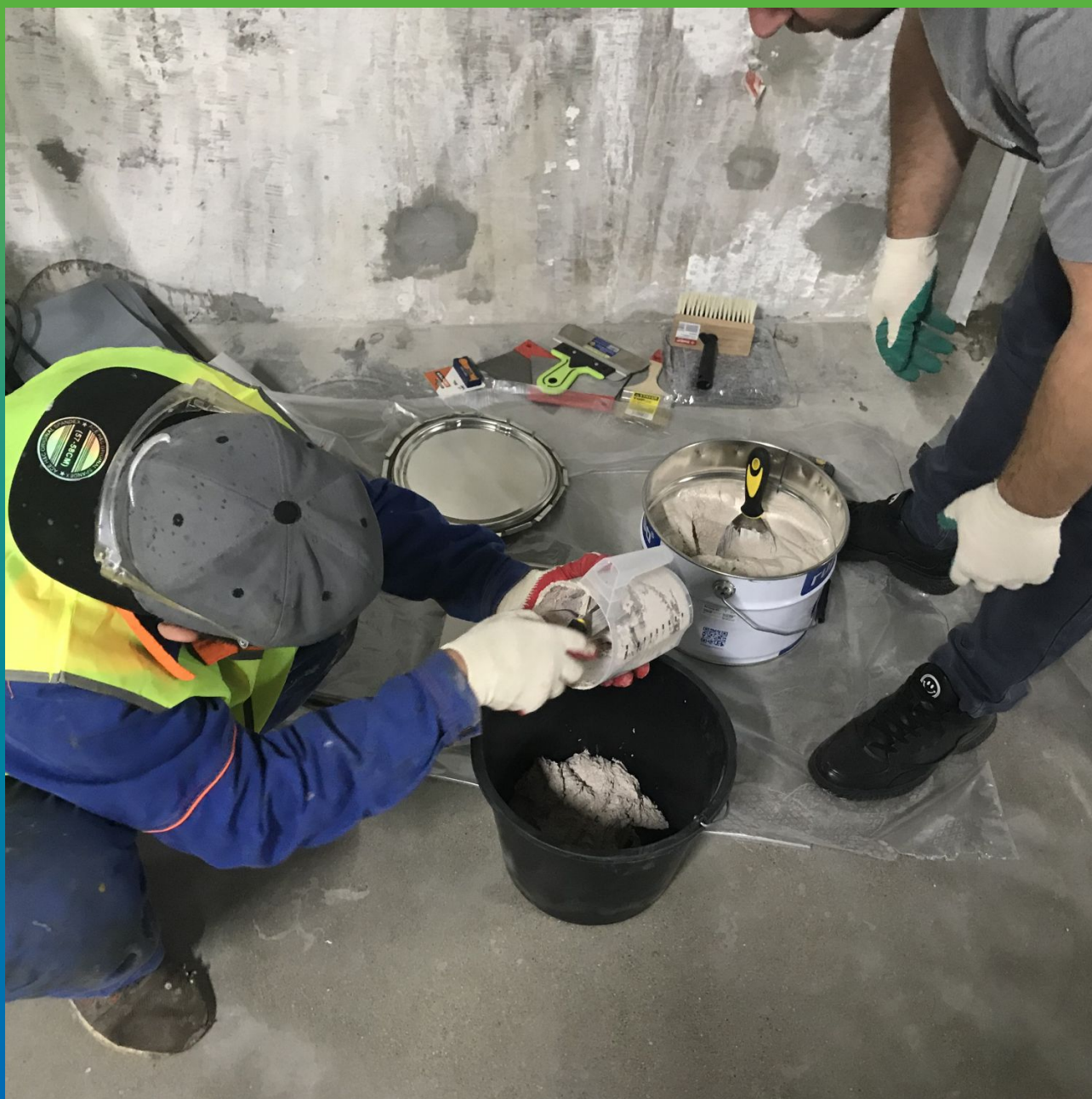
Подготовка клея Манопокс 331
