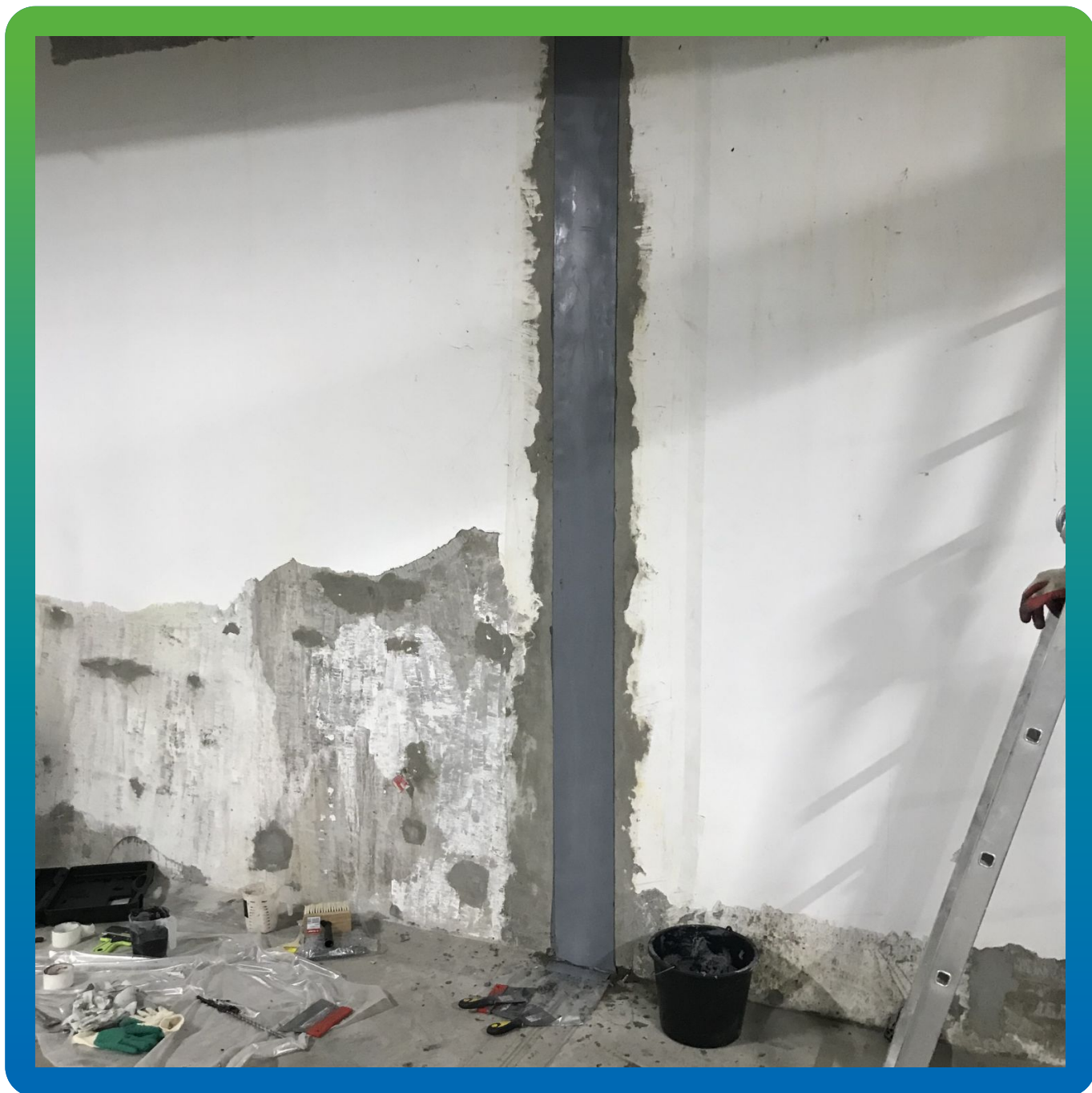
Финишный вид смонтированной ленты Манодил Про на клей Манопокс 331
