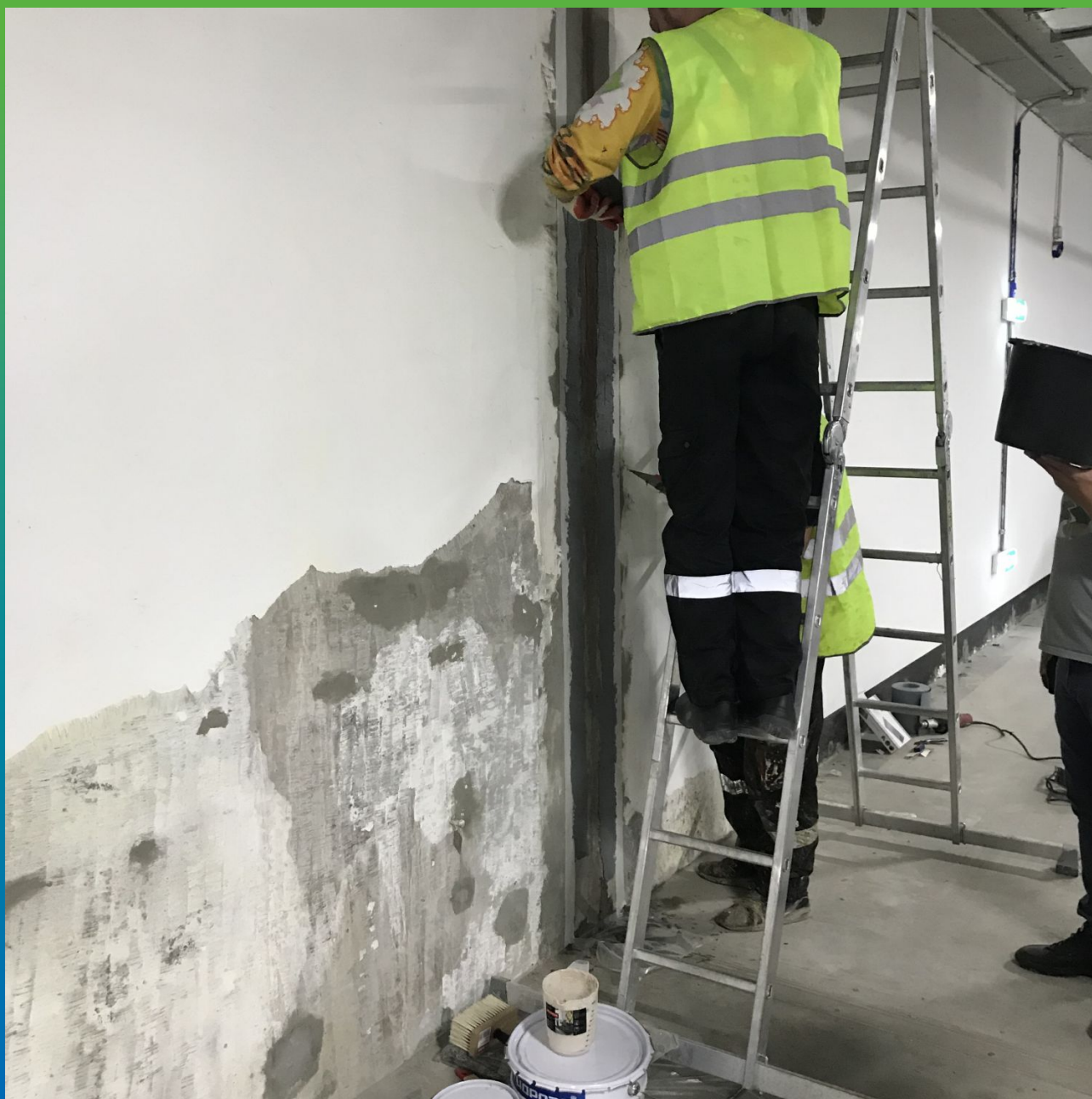
Нанесение Манопокс 331
