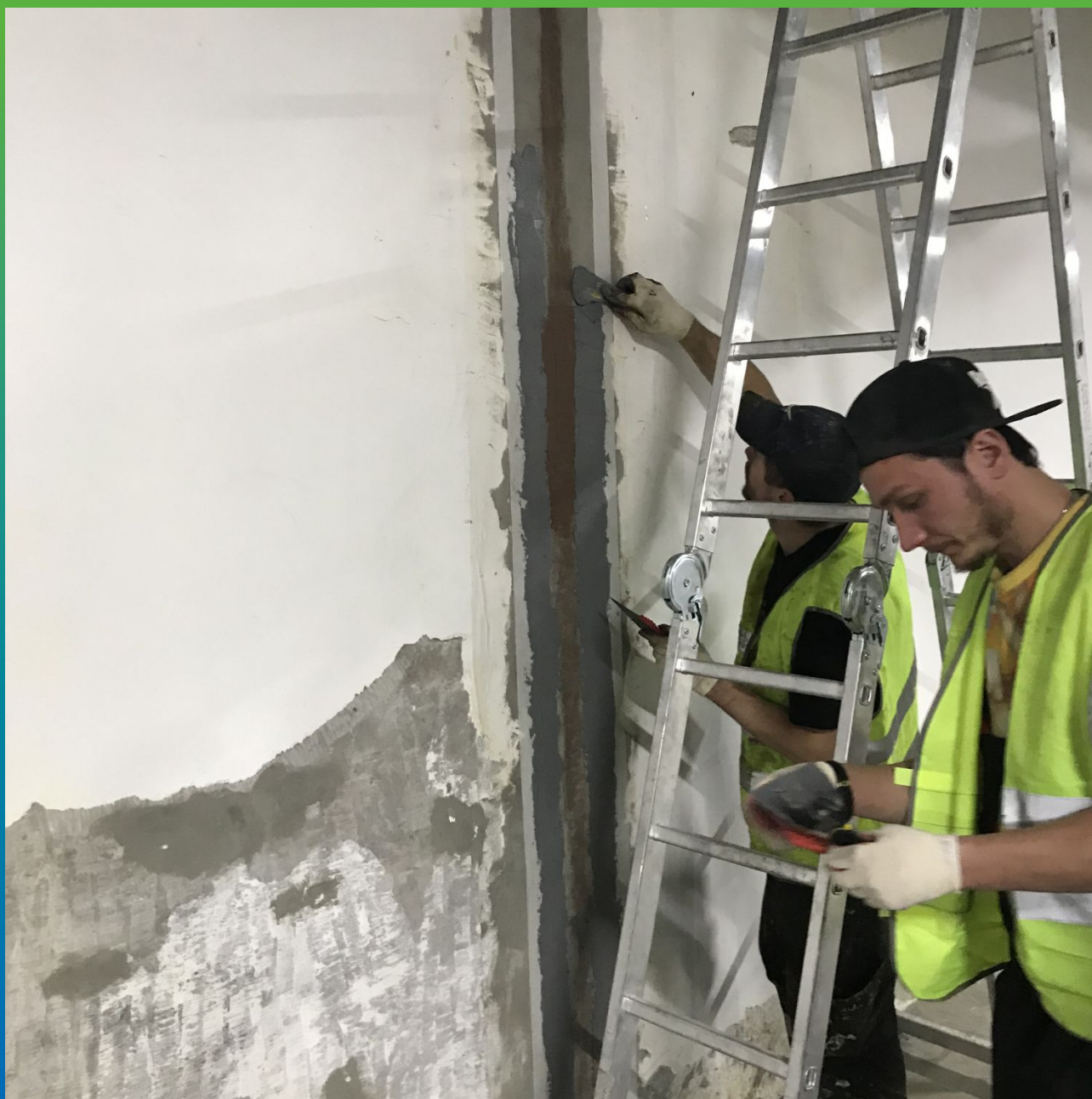
Нанесение клеевого состава Манопокс 331 на поверхность стены
