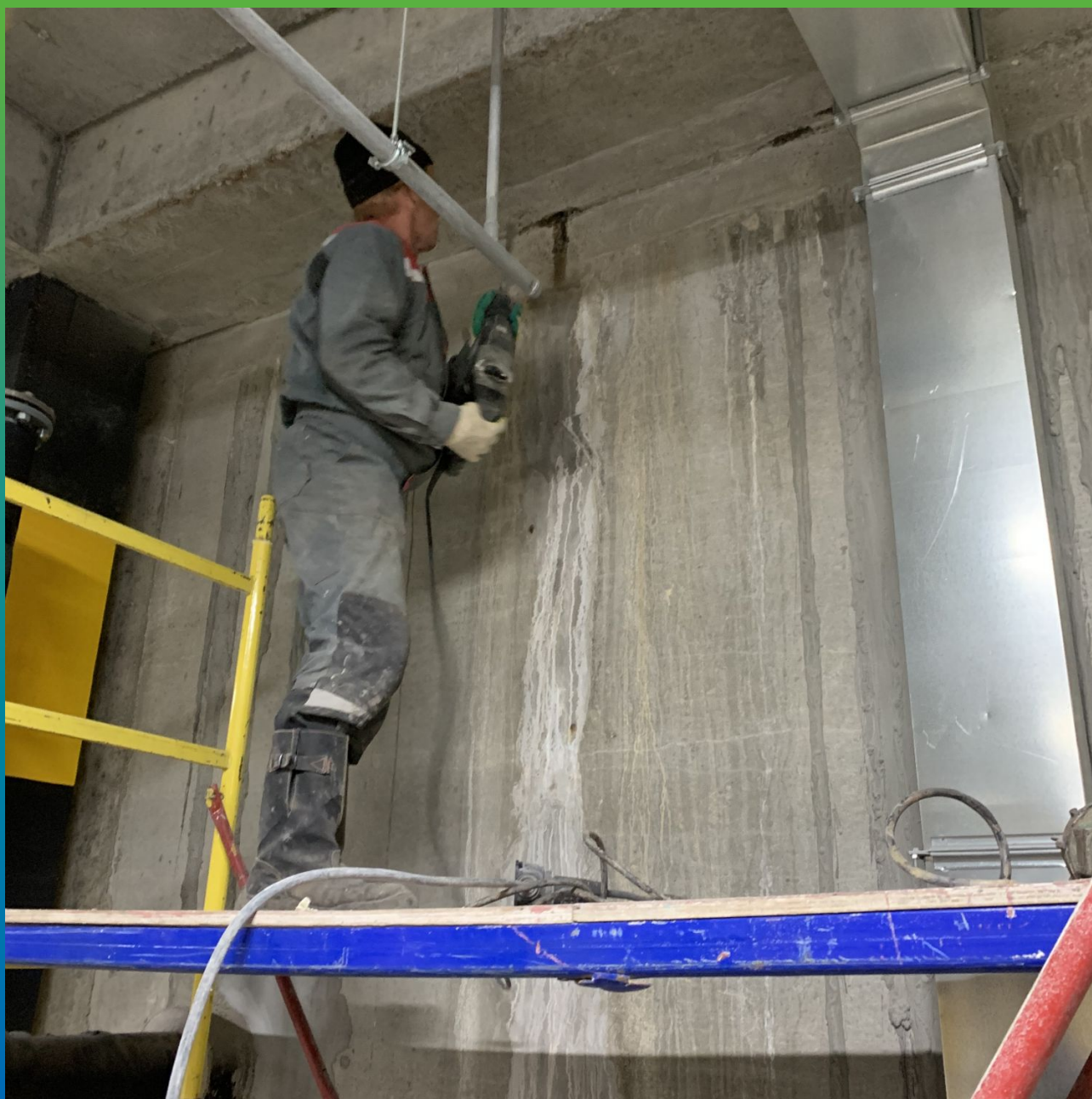
Подготовка шва для приклеивания ленты Прелести СТ
