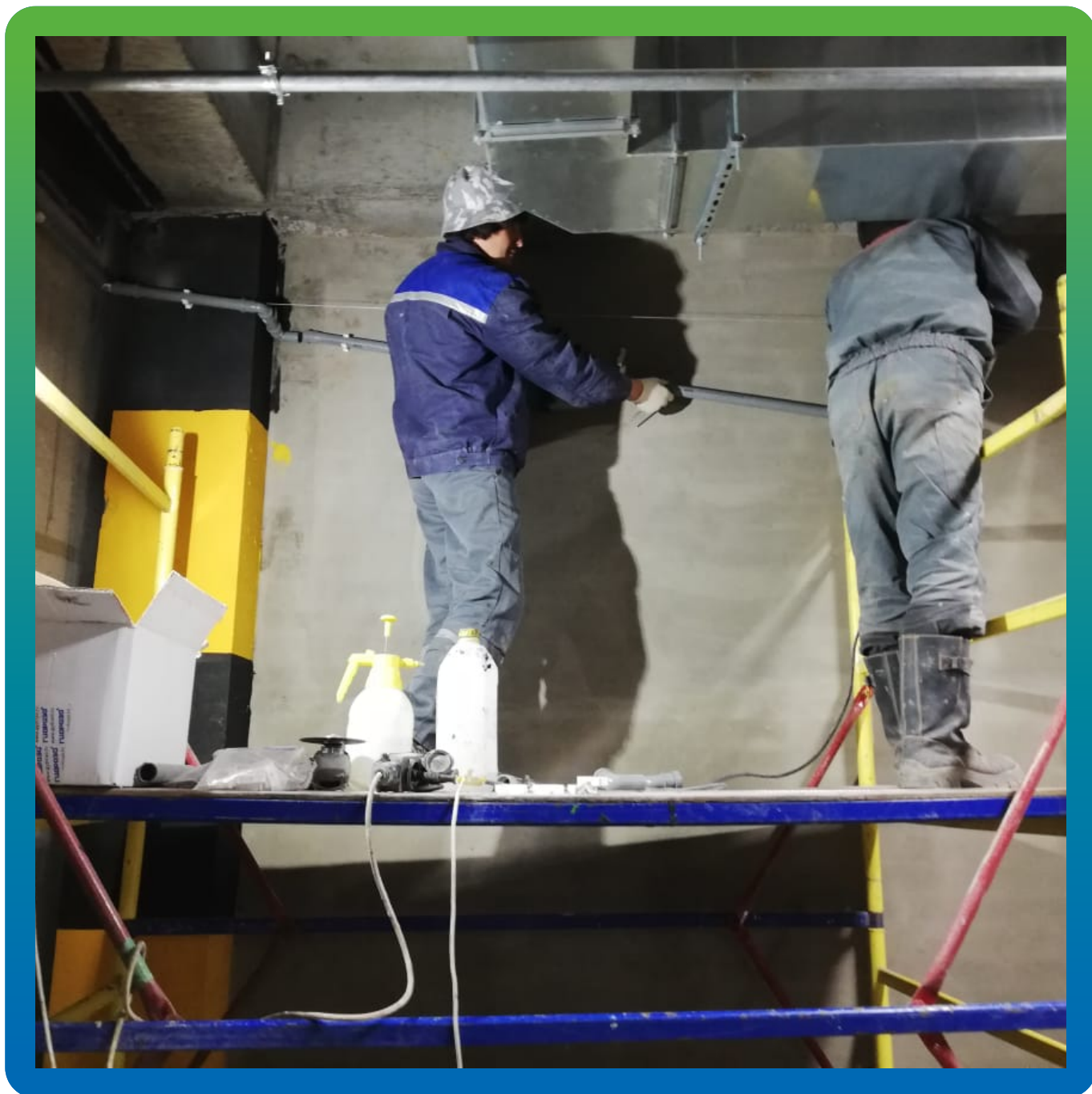
Монтаж водоотводной трубы
