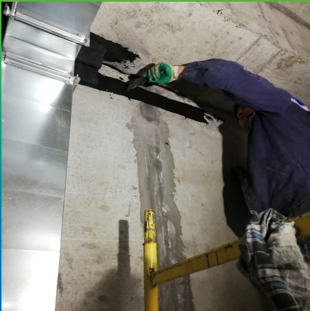
Нанесение Манодил Бонд Ф
