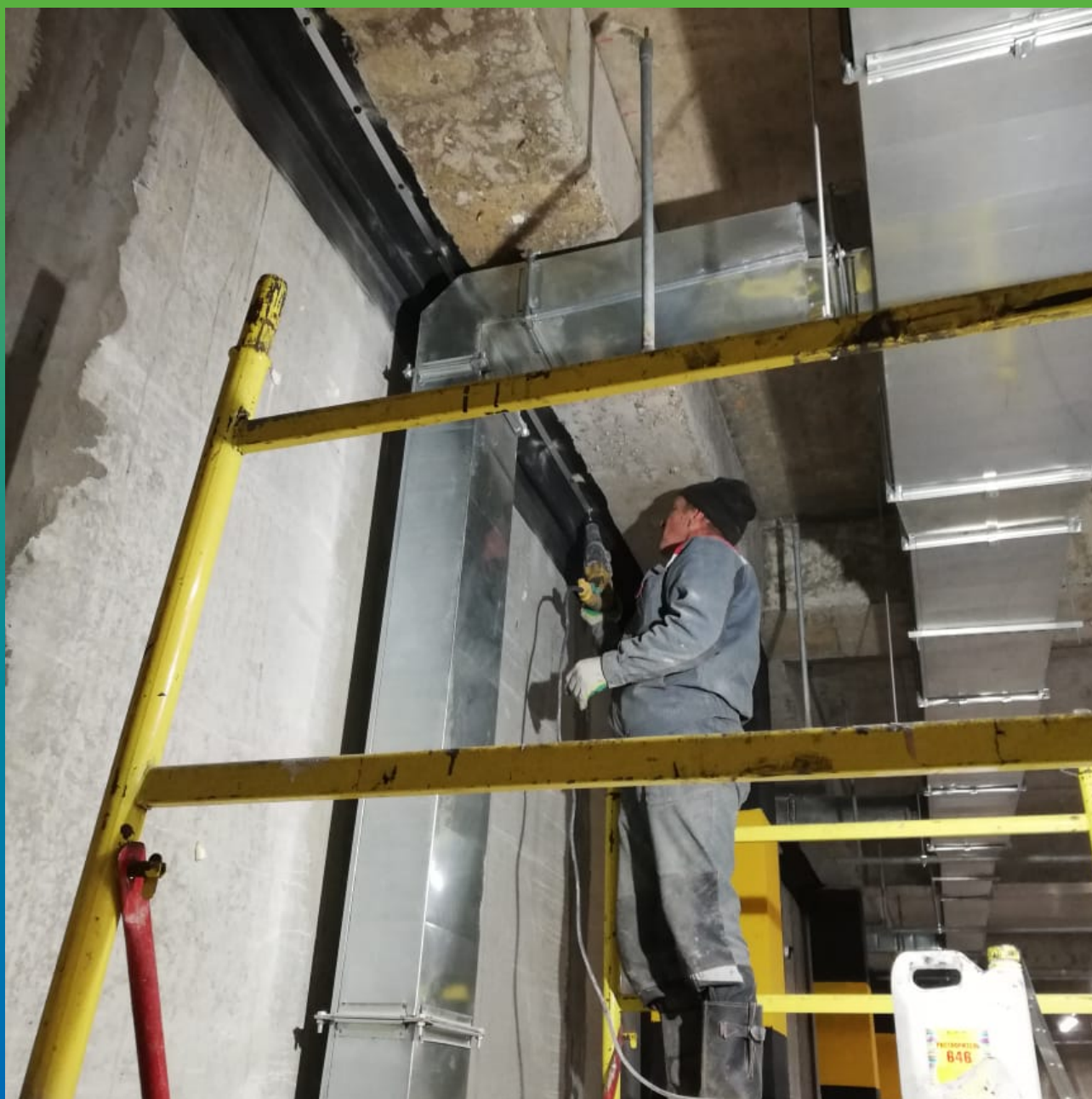
Крепление прижимной планки
