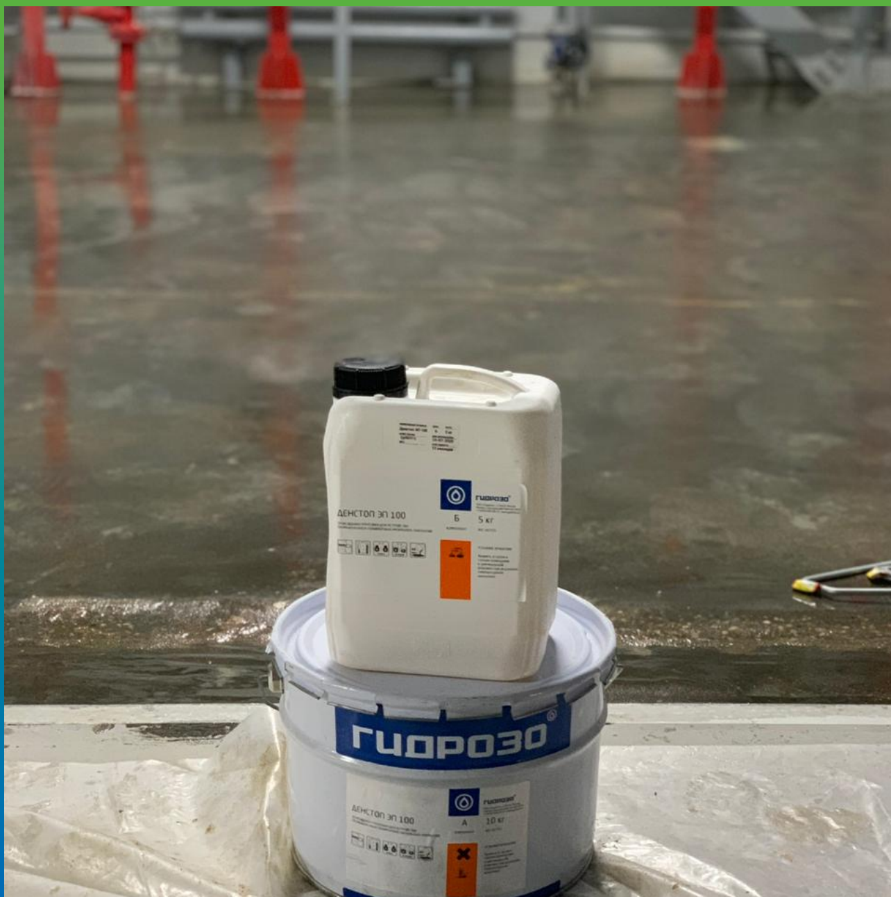
Поверхность, загрунтованная составом ДенСтoп ЭП 100
