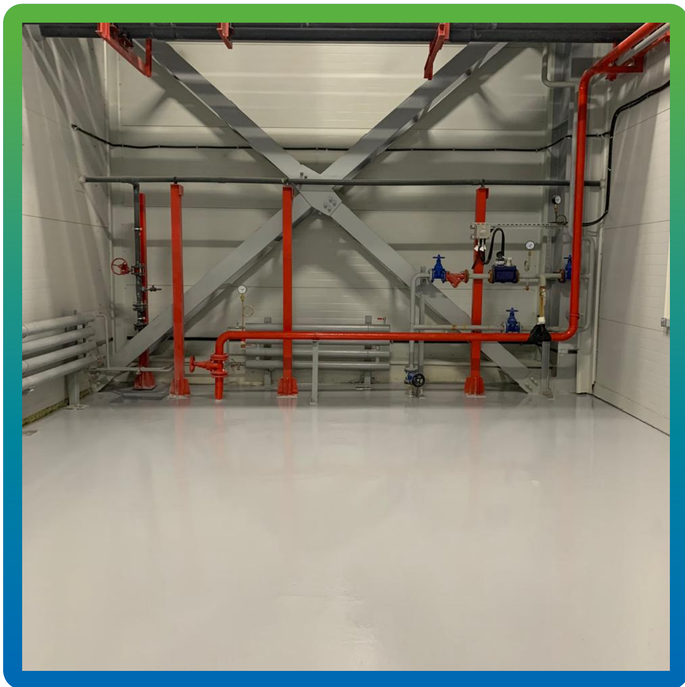
Финальный вид покрытия
