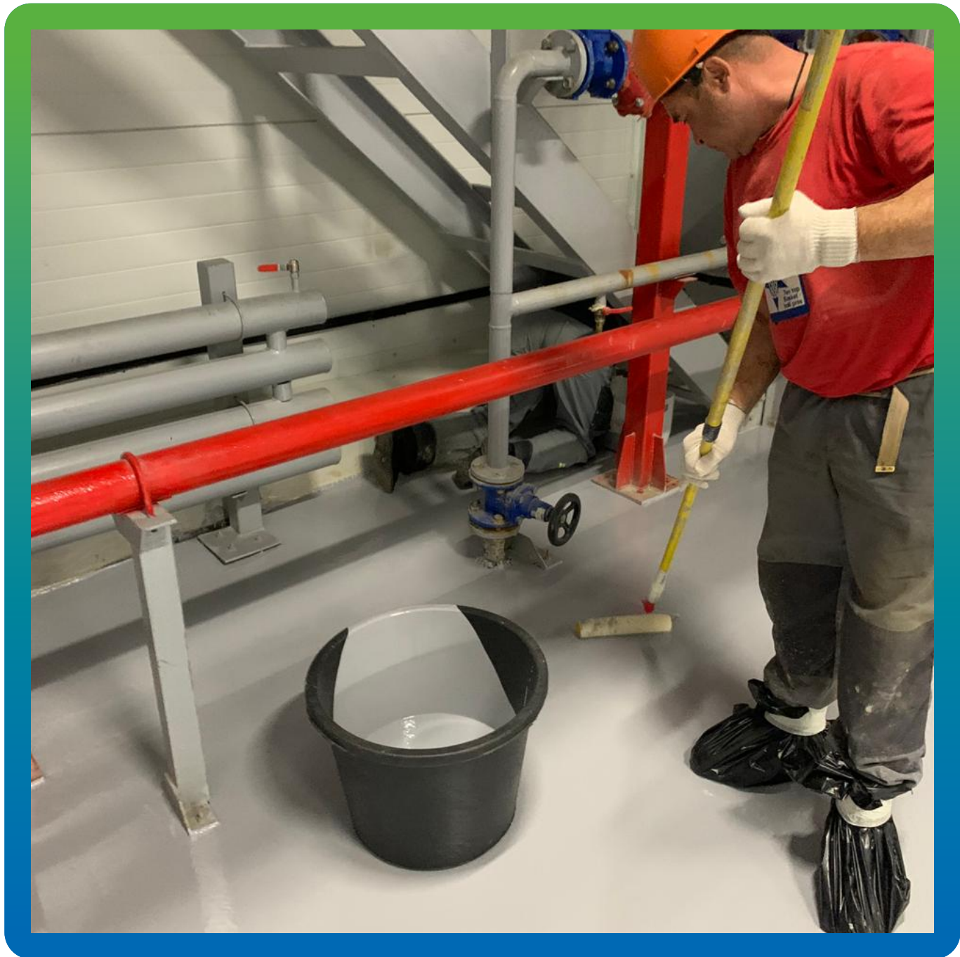
Нанесение второго слоя покрытия
