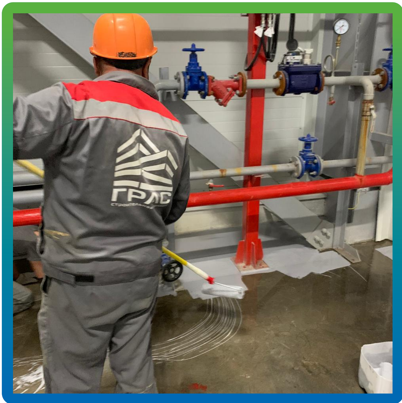
Нанесение состава ДенсТоп ЭП 201 на загрунтованную поверхность
