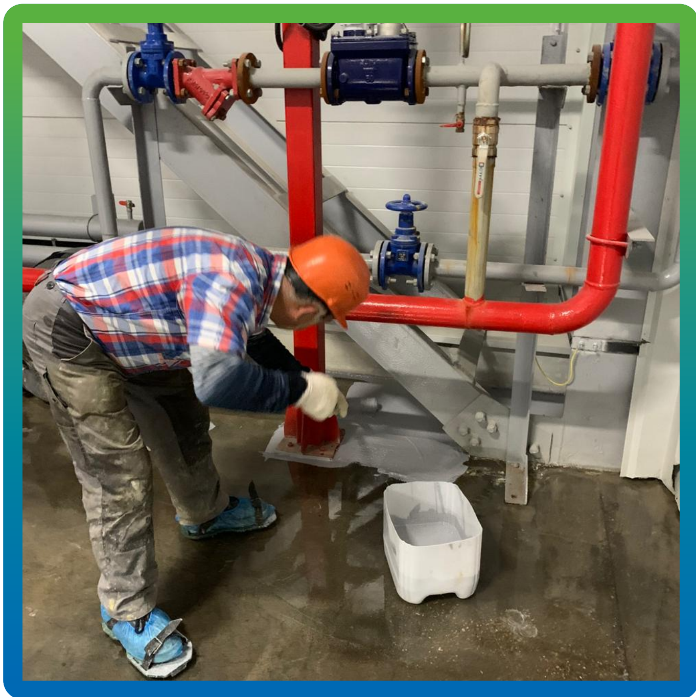
Нанесение состава ДенсТоп ЭП 201 на загрунтованную поверхность
