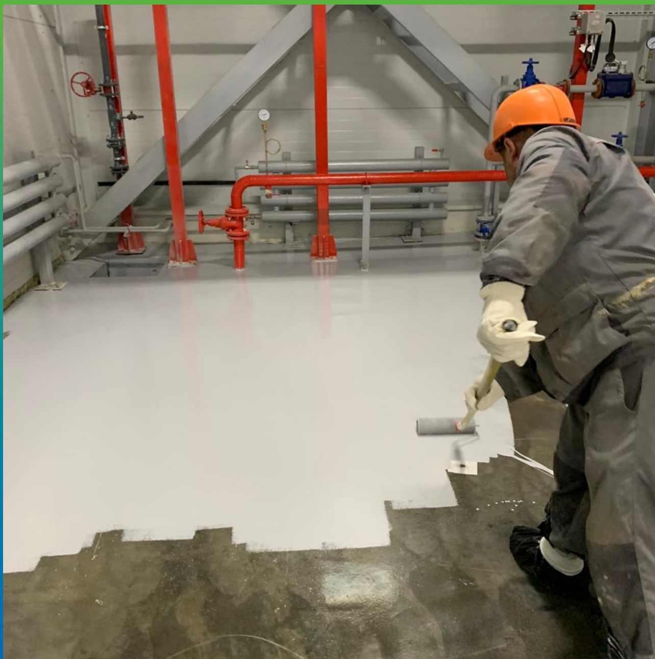
Нанесение состава ДенсТоп ЭП 201 на загрунтованную поверхность
