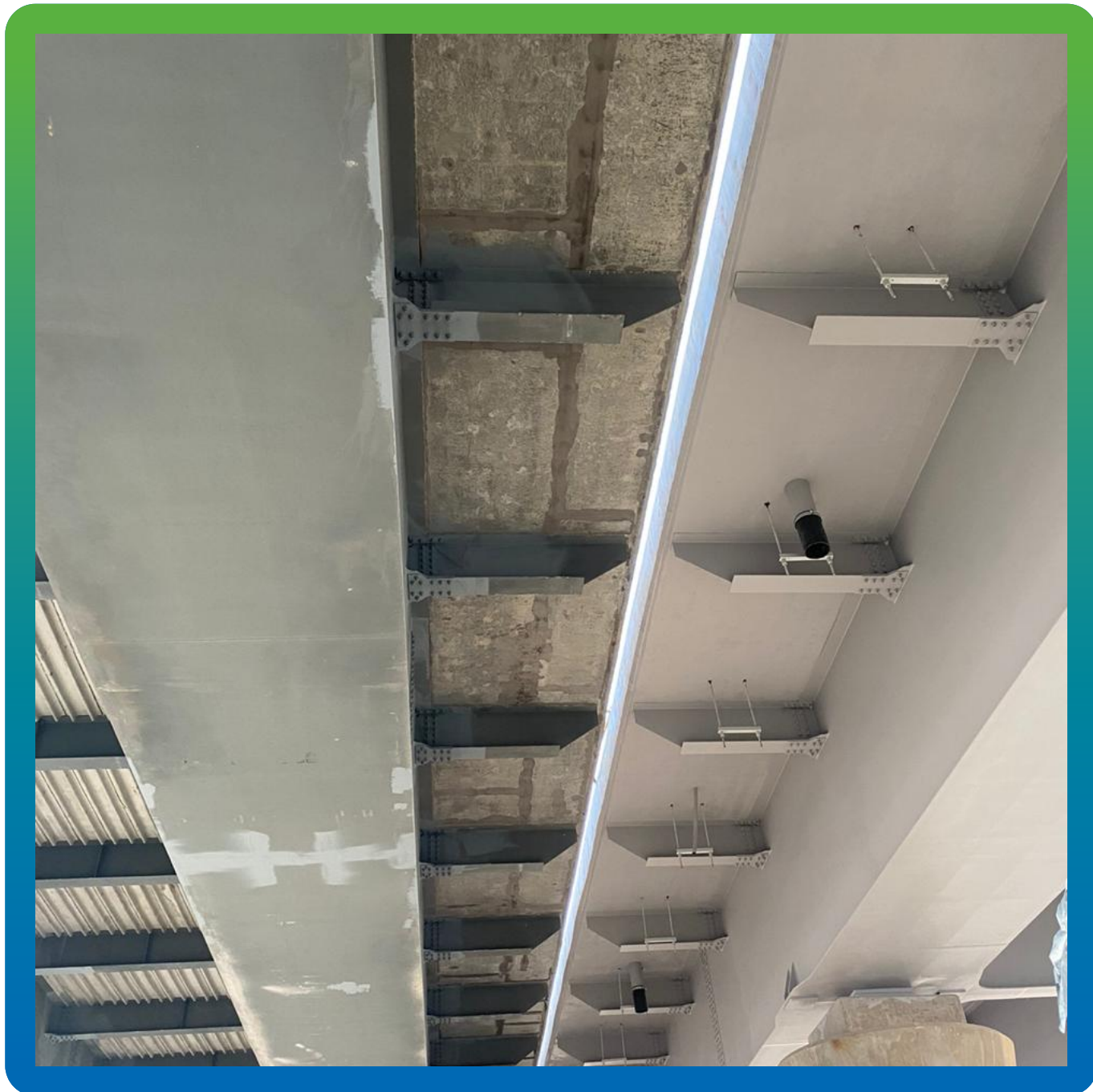
Отремонтированная жб поверхность
