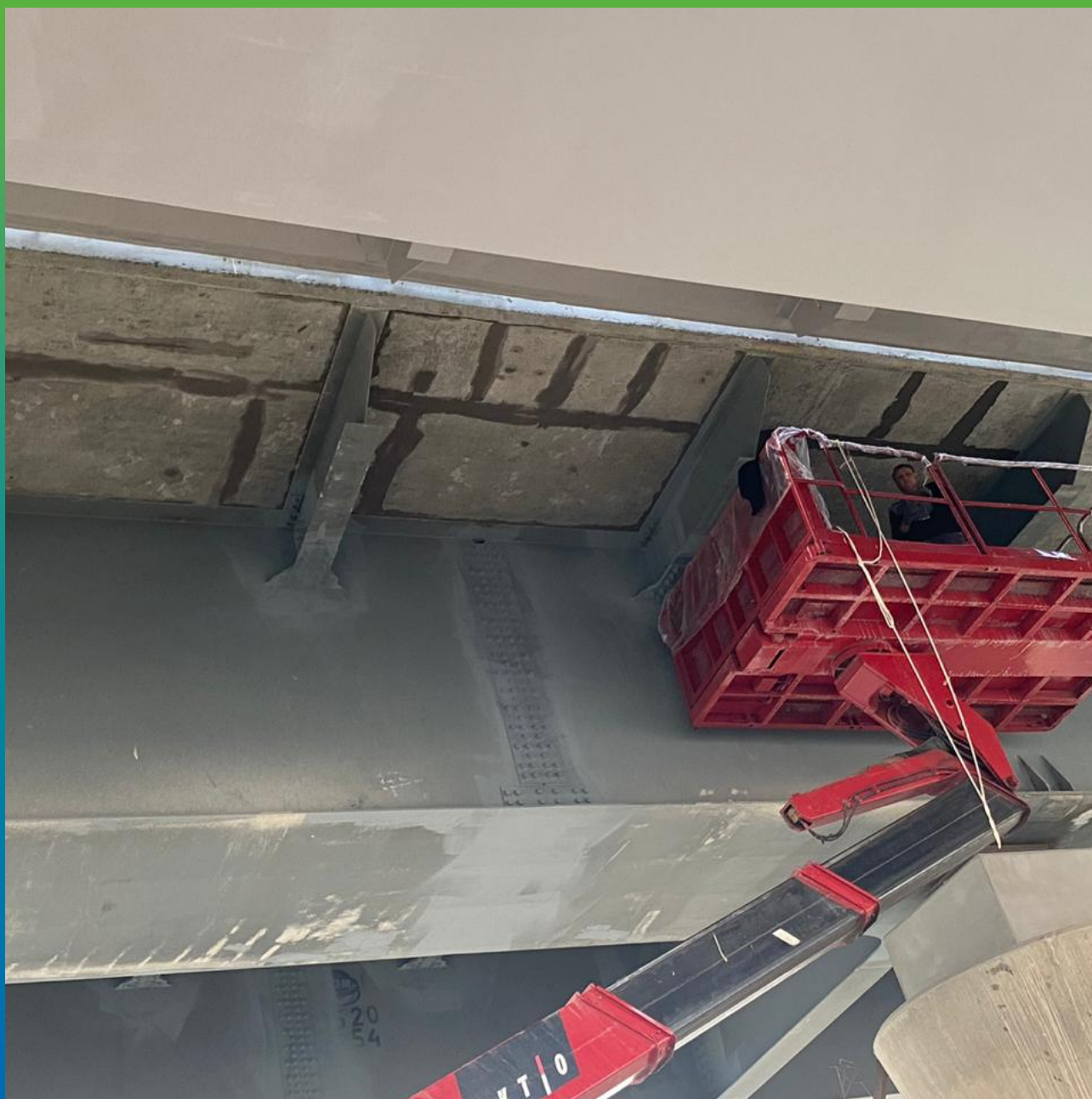
Ремонт дефектов железобетона
