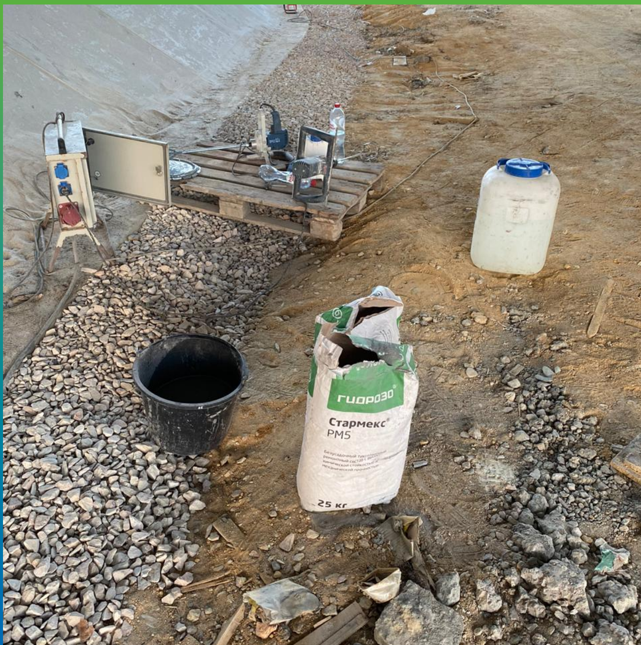
Быстротвердеющий состав Стармекс РМ5 на объекте
