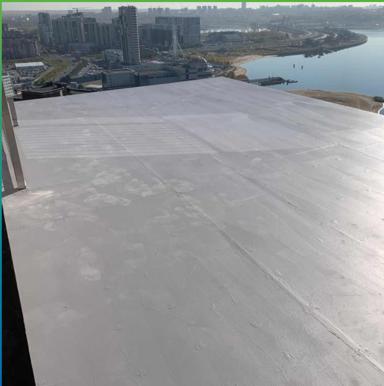
Грунтование основания составом ДенсТоп ЭП 105
