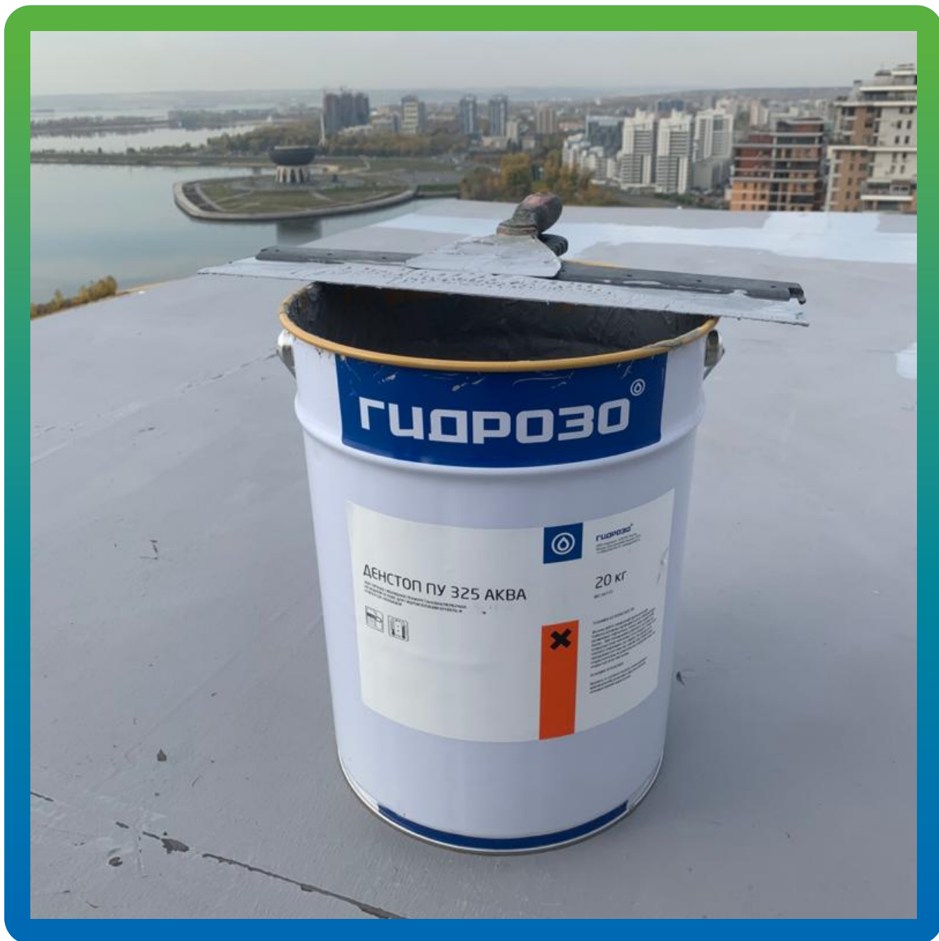
Нанесение гидроизоляционного состава ДенТоп ПУ 325 Аква
