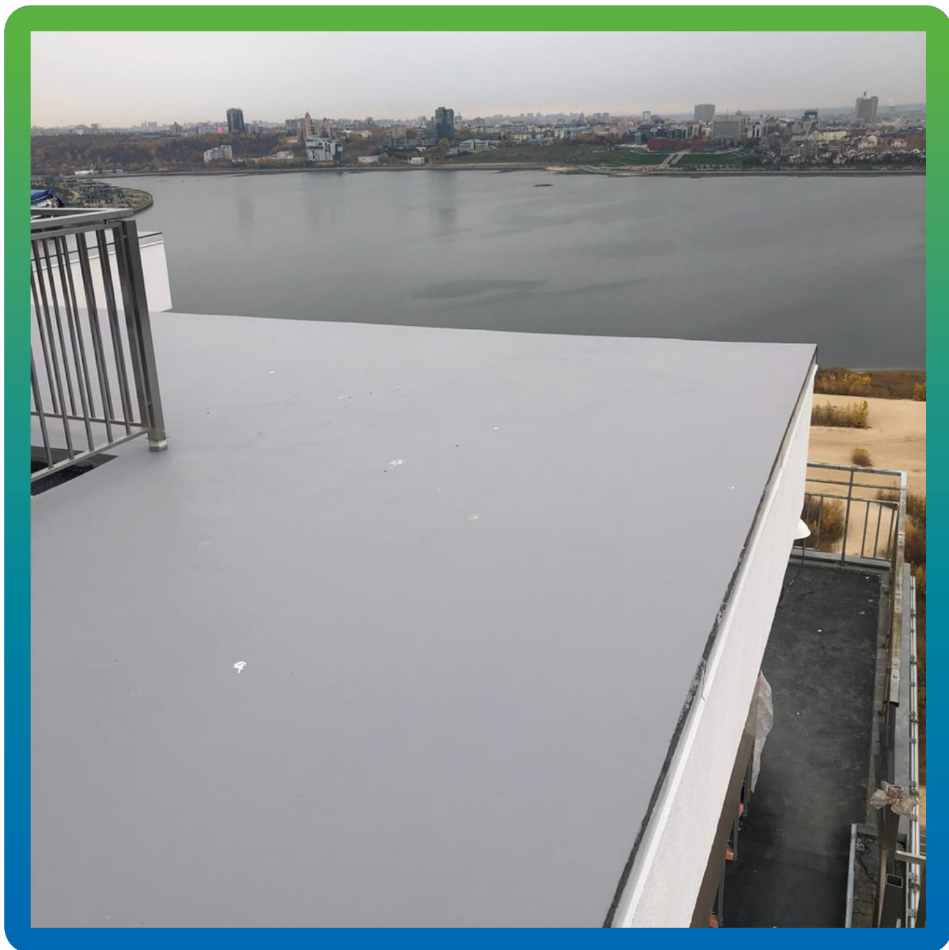
Нанесение гидроизоляционного состава ДенТоп ПУ 325 Аква
