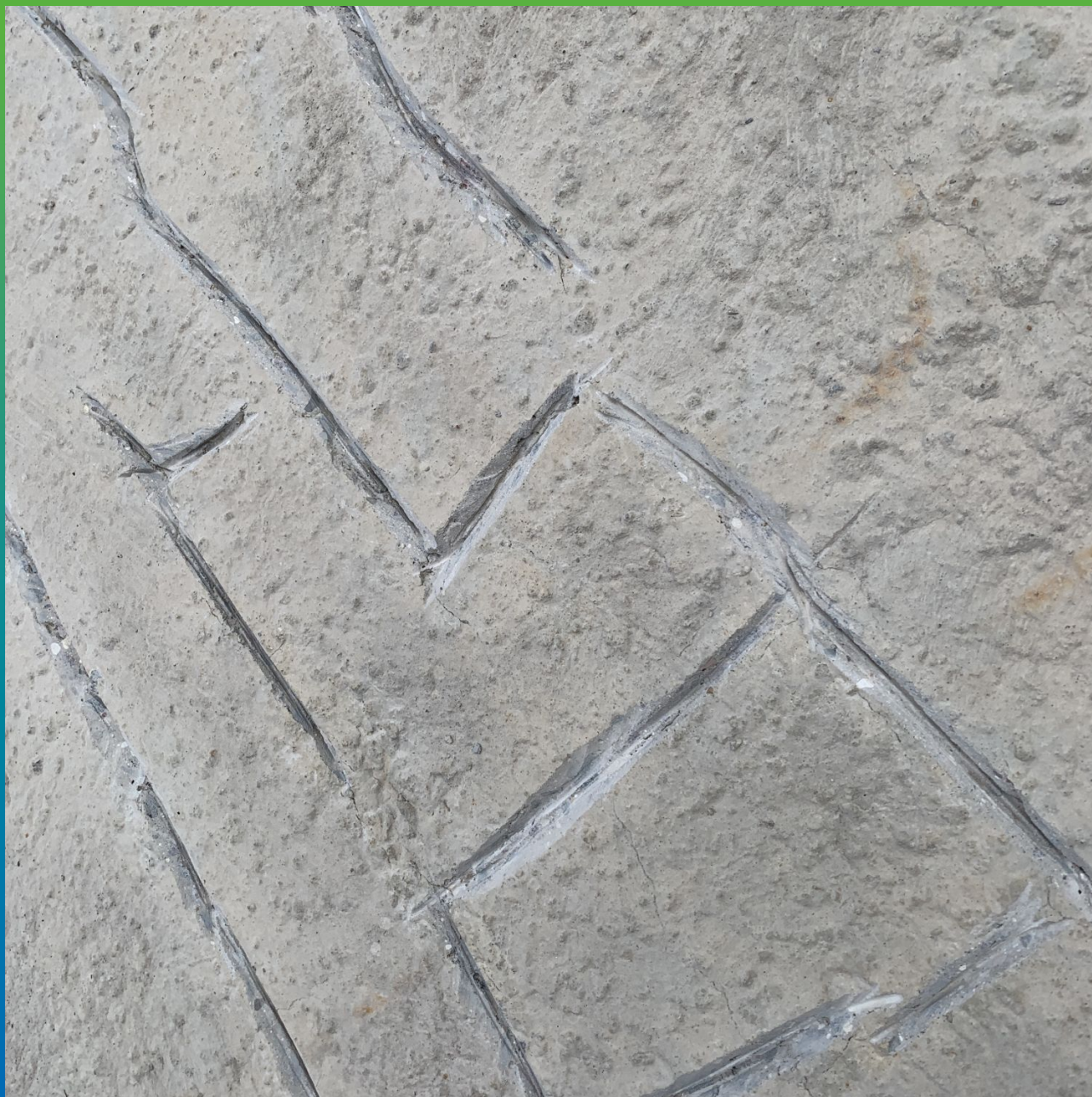
Расшивка трещин
