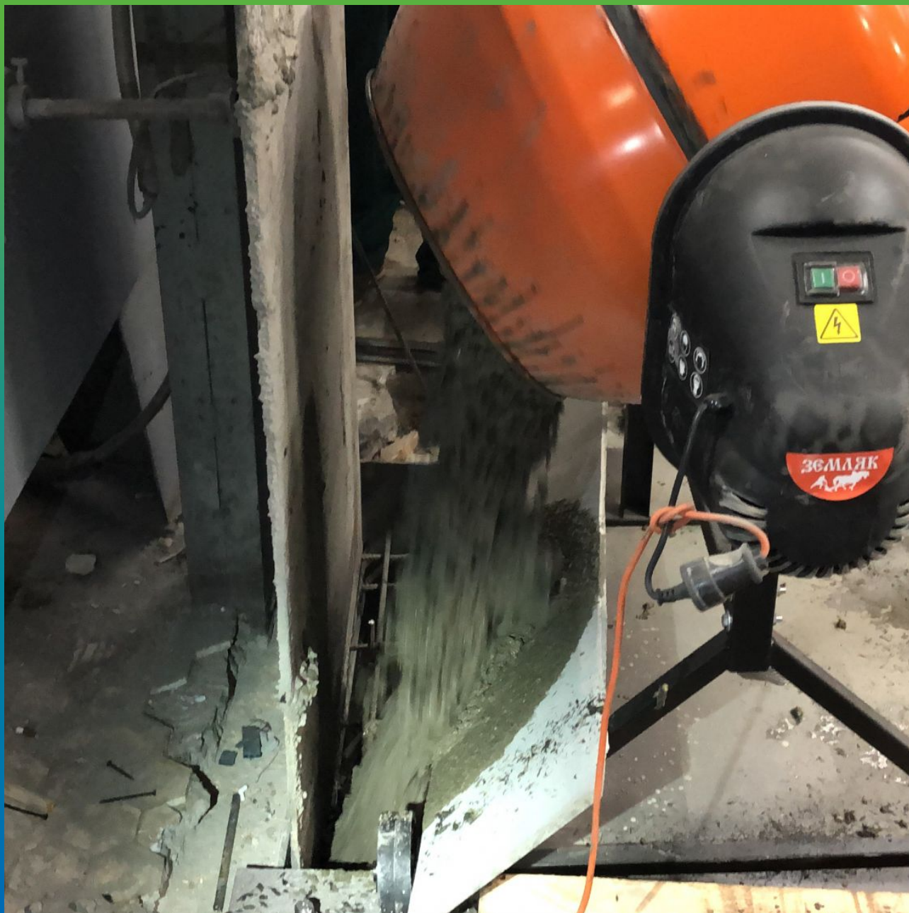
Заливка Стармекс ФМ7 в опалубку
