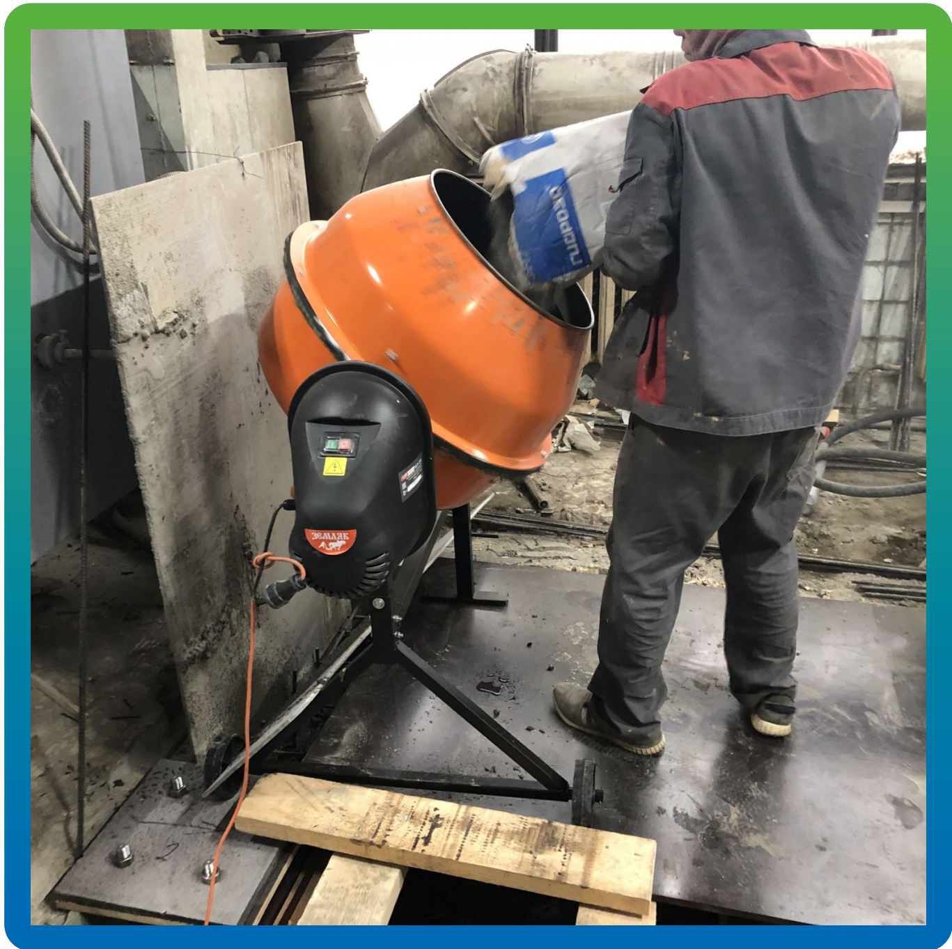
Подготовка смеси Стармекс ФМ7
