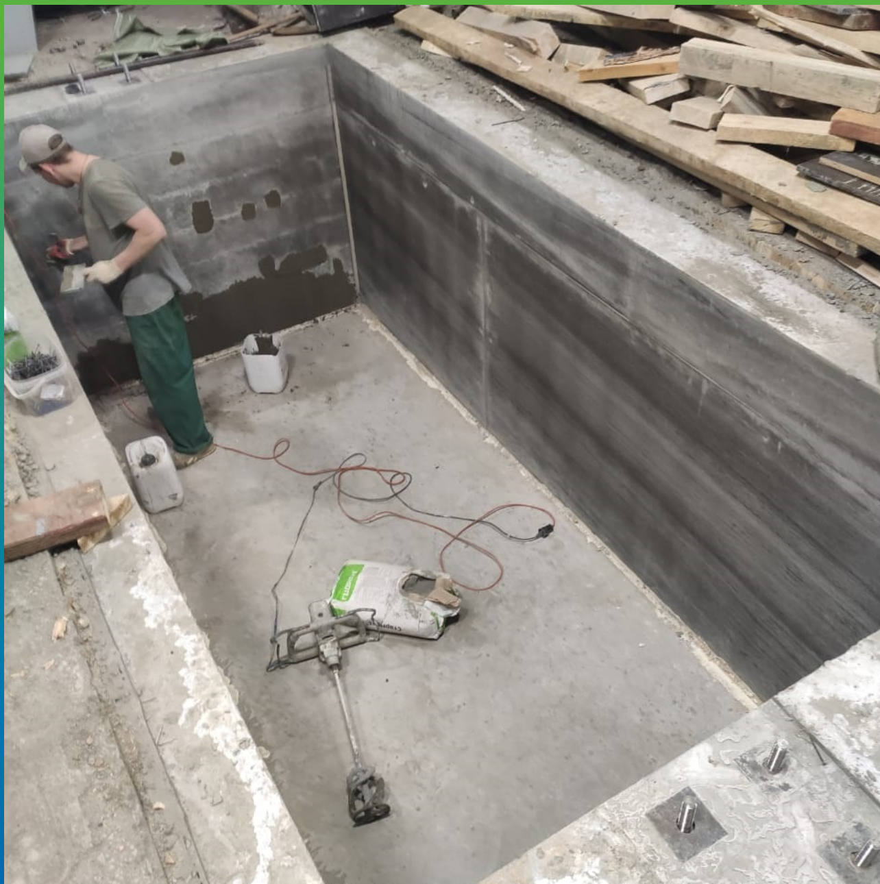
Вид фундамента после снятия оплубки
