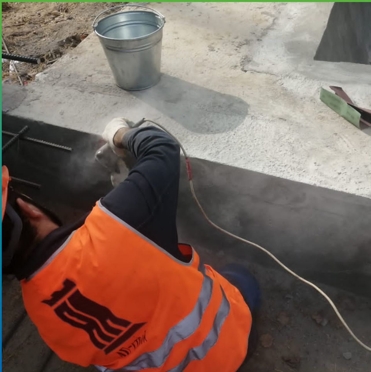
Подготовка поверхности под дальнейшую гидроизоляцию
