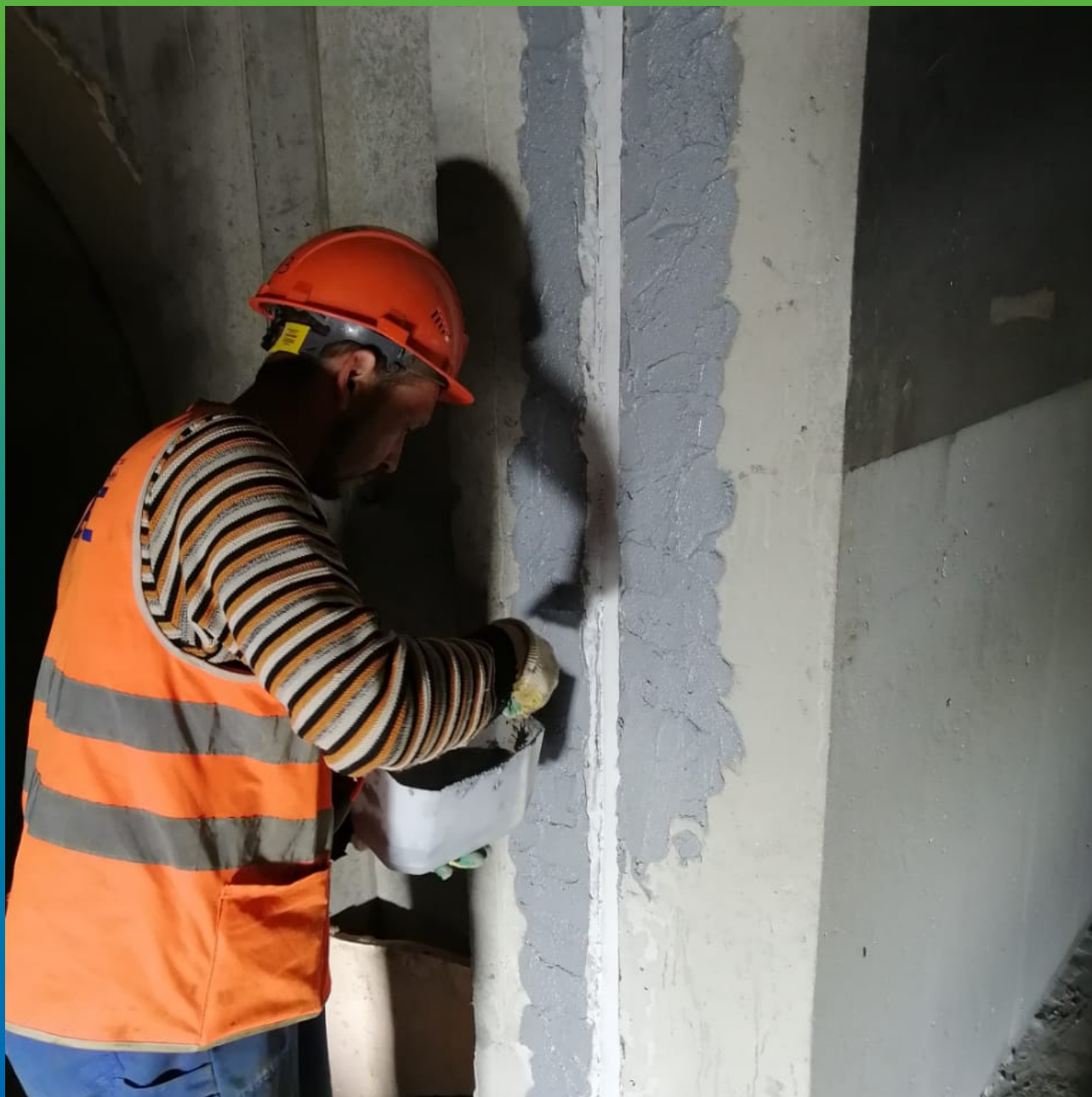
Нанесение клея на поверхность перед приклеиванием ленты
