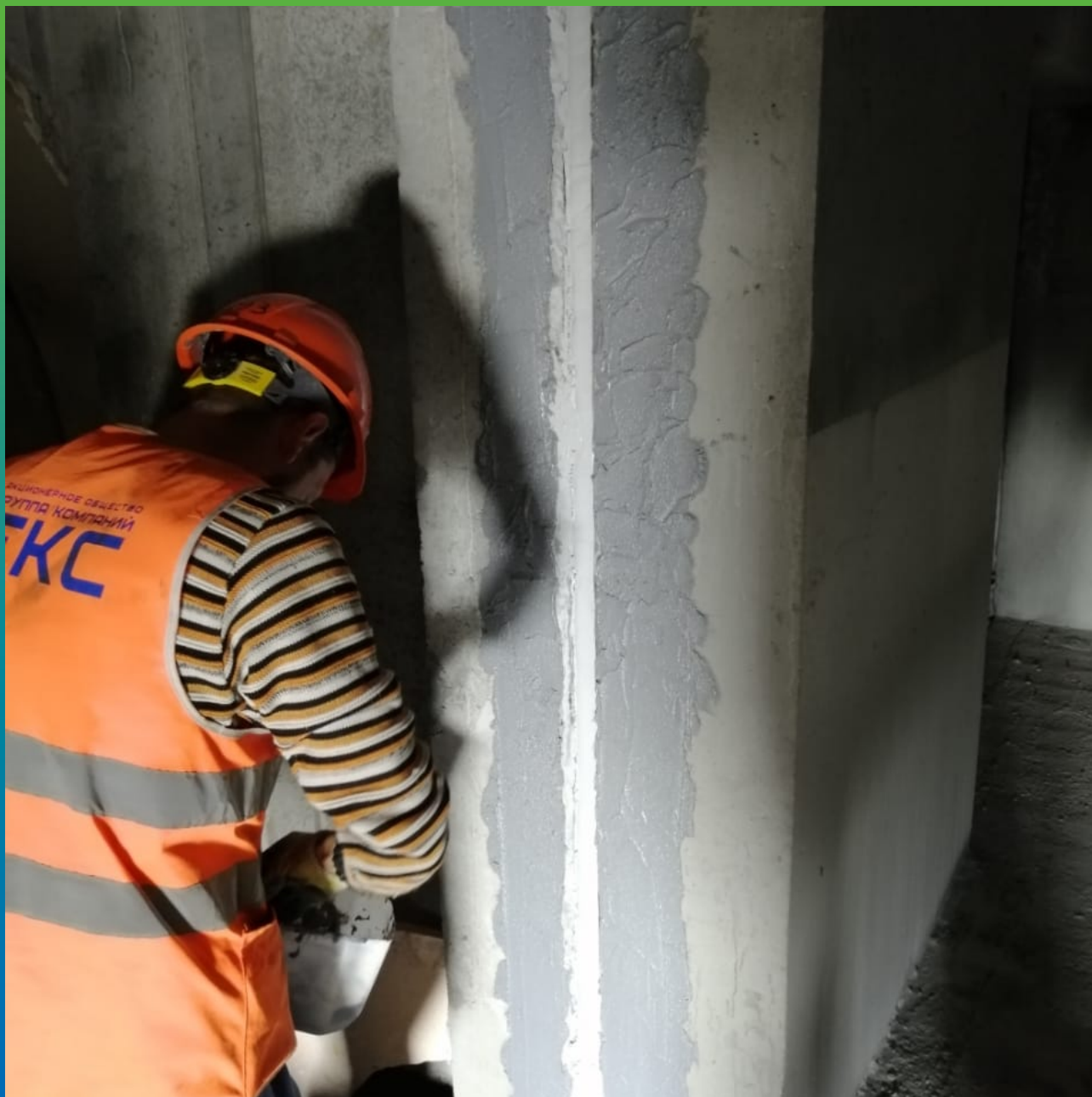
Нанесение Манопокс 331 на подготовленную поверхность
