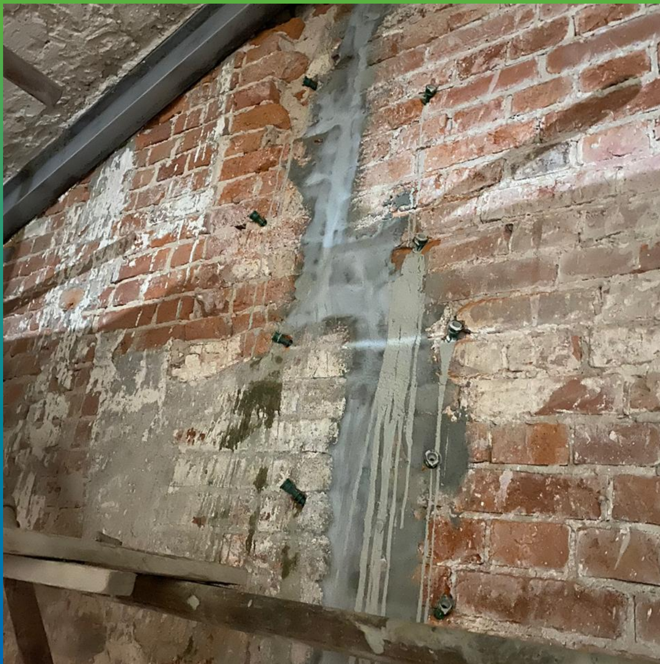
Внешний вид стены после проочки
