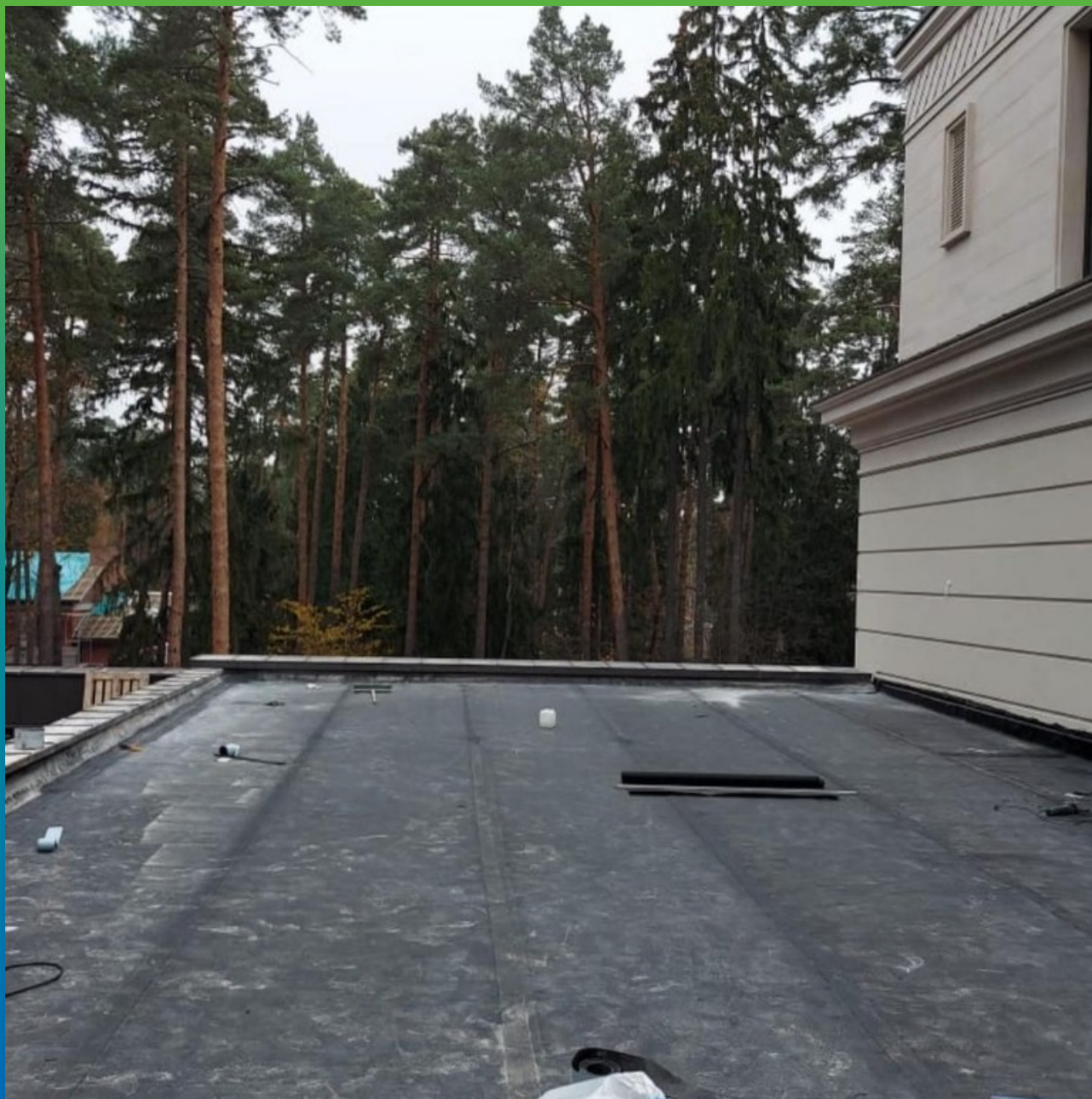
Итог по устройству гидроизоляции материалом Суперсил 2.1
