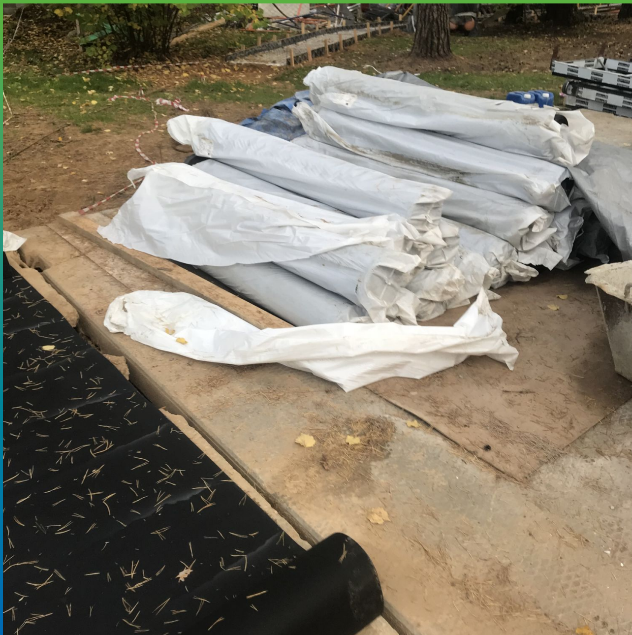
Материал на стройплощадке
