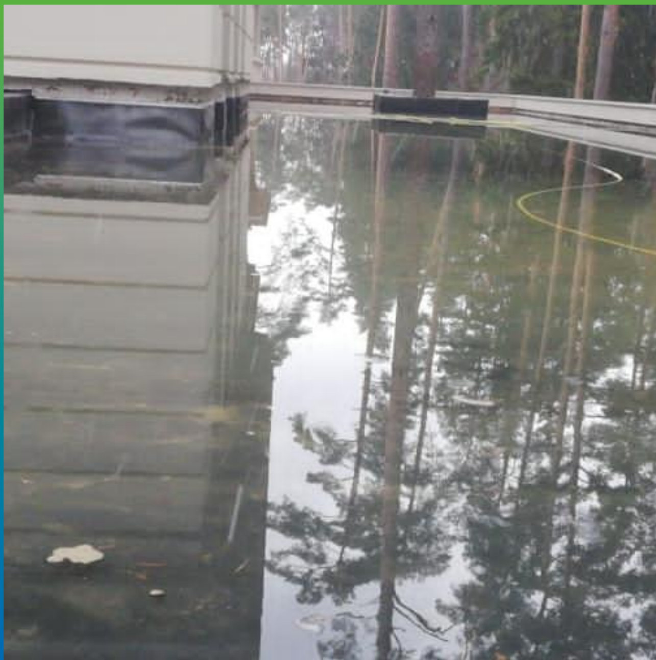
Испытания на герметичность путем пролива воды на кровлю
