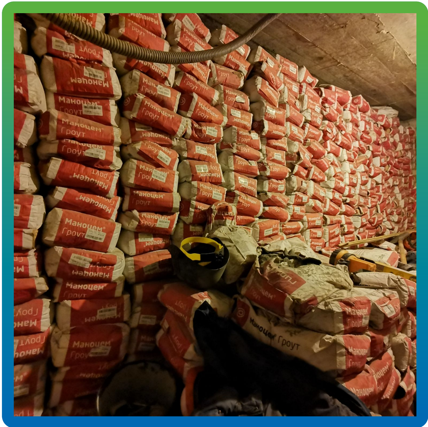
Материалы Гидрозо на объекте
