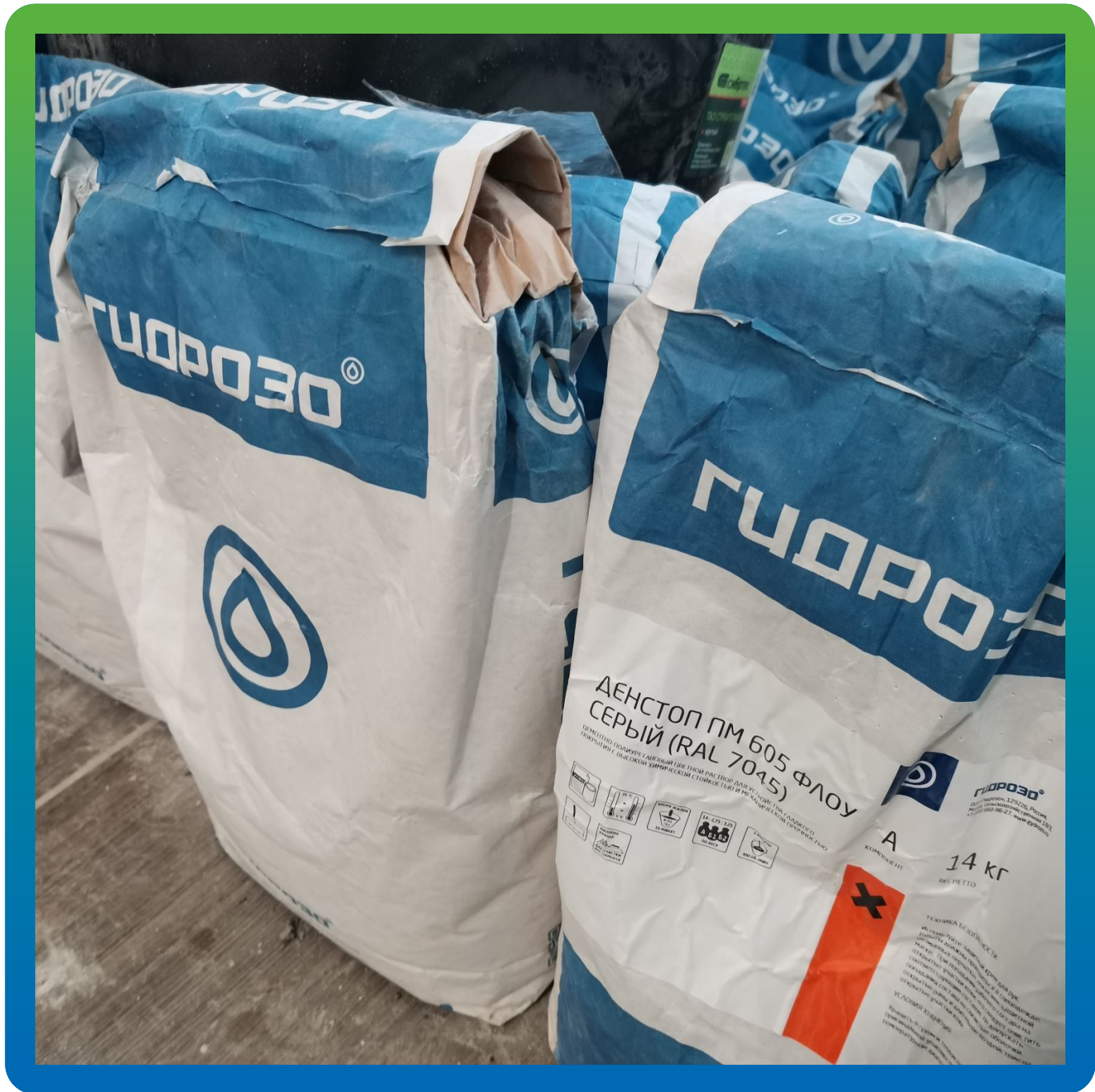
Материалы Гидрозо на объекте
