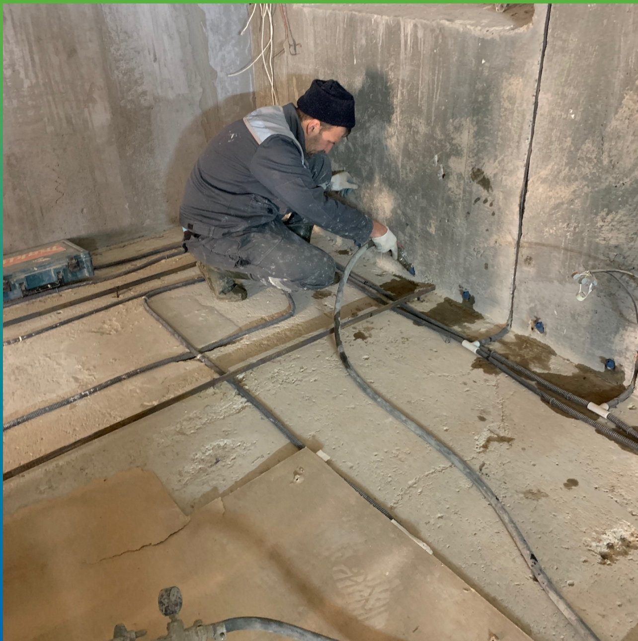
Процесс инъектирования
