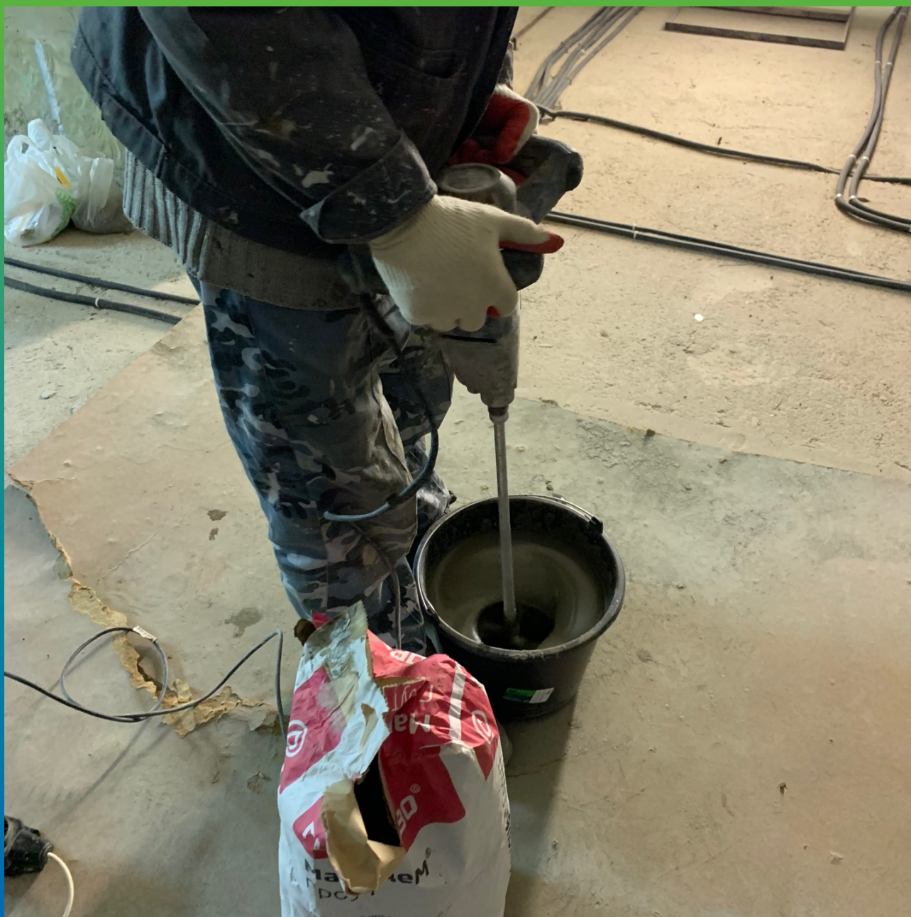
Приготовление инъекционного состава
