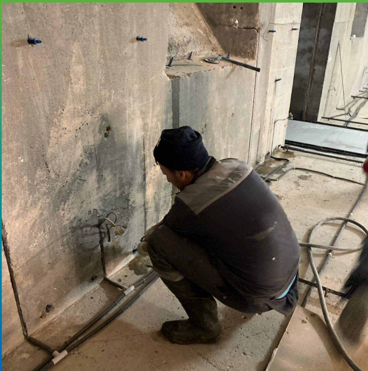
Процесс инъектирования
