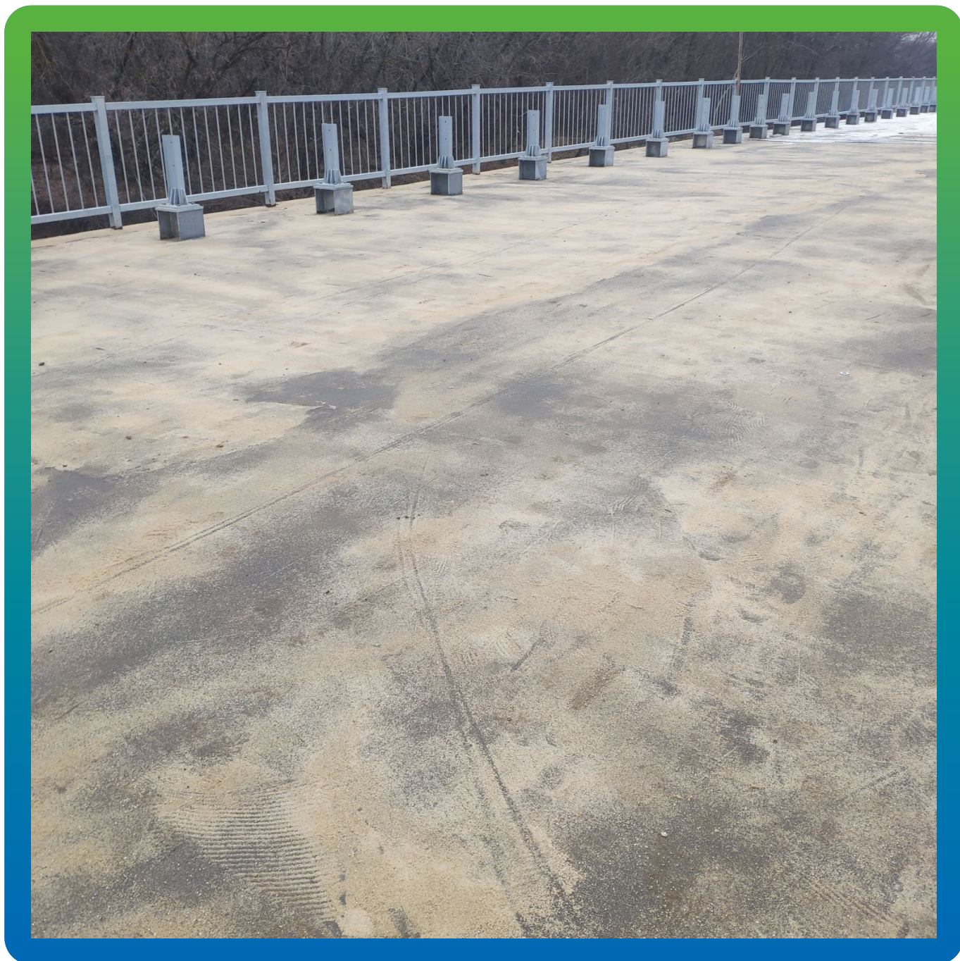
Окончательный вид гидроизолированного мостового полотна
