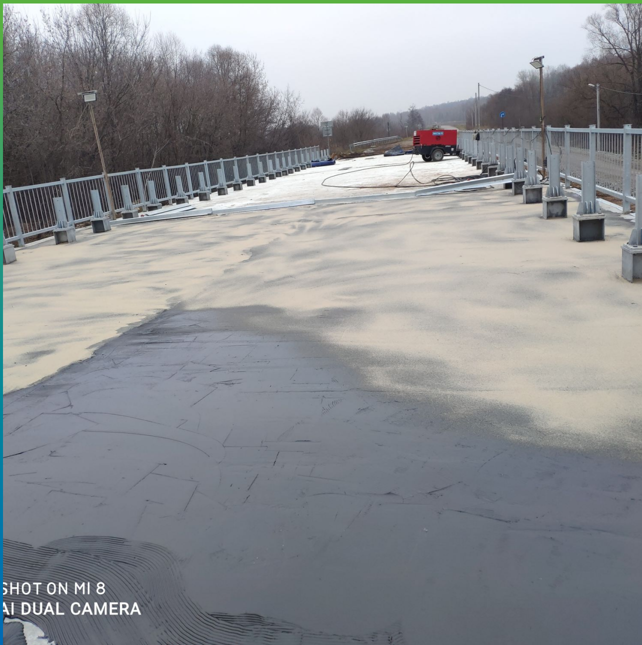
Процесс нанесения материала с просыпкой по всей площади мостового полотна
