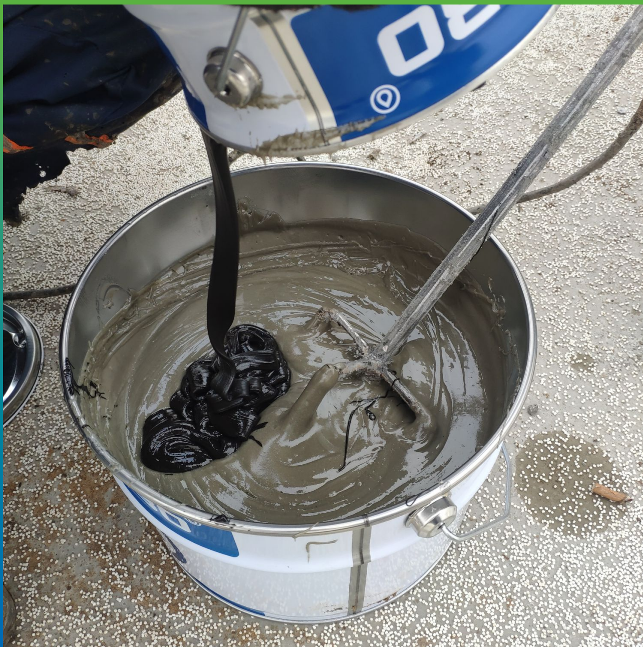
Смешивание состава ДенсТоп Пс 391 перед нанесением
