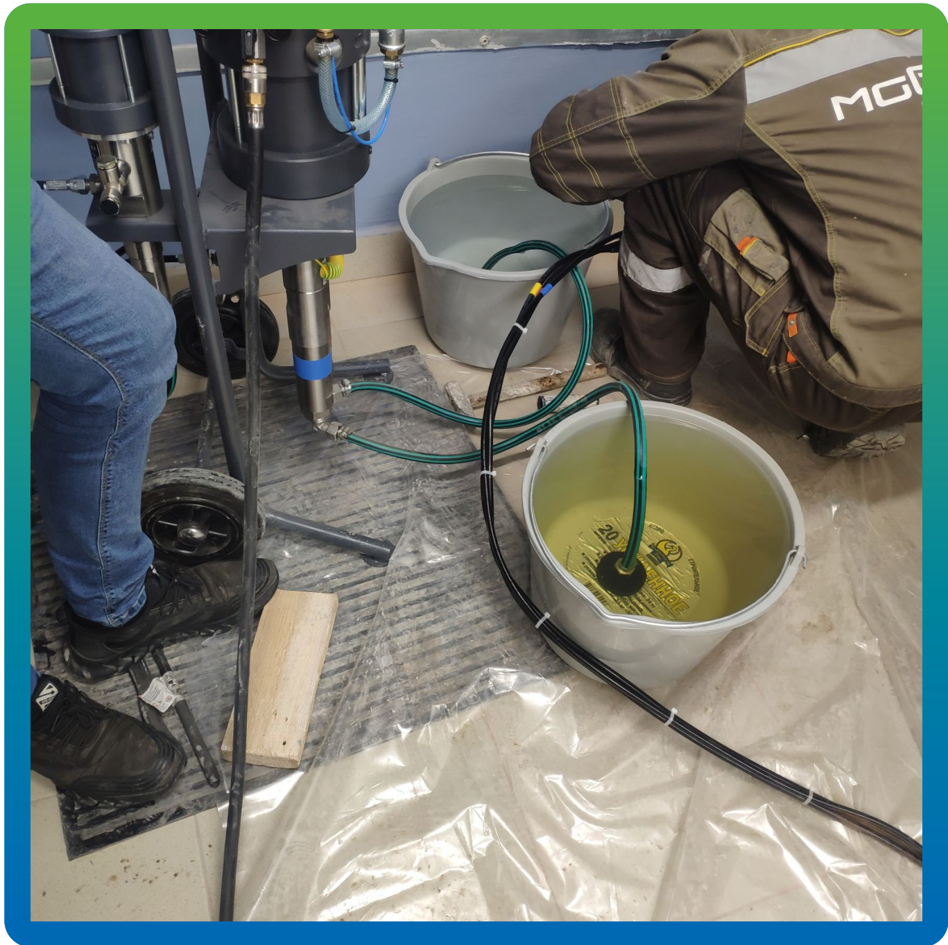
Запуск насоса для акрилатных гелей БМ 1425 с Манокрил Гель Р
