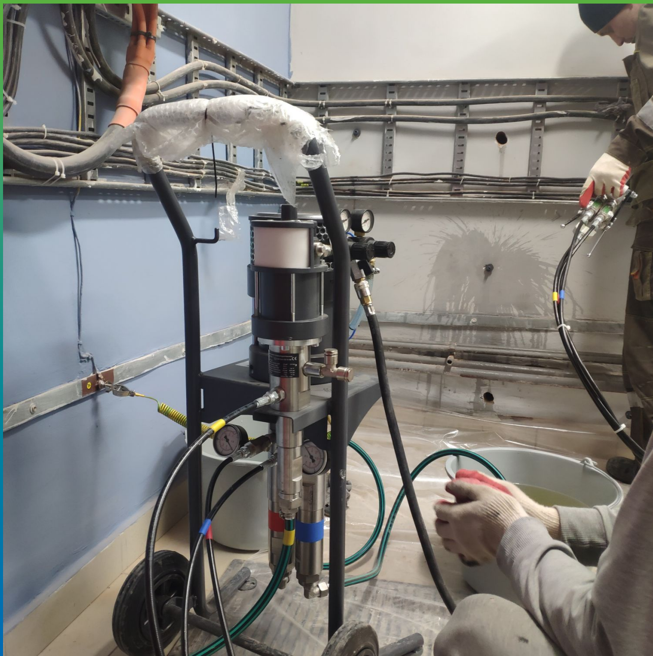
Инъектирование кирпичной кладки Манокрил Гель Р
