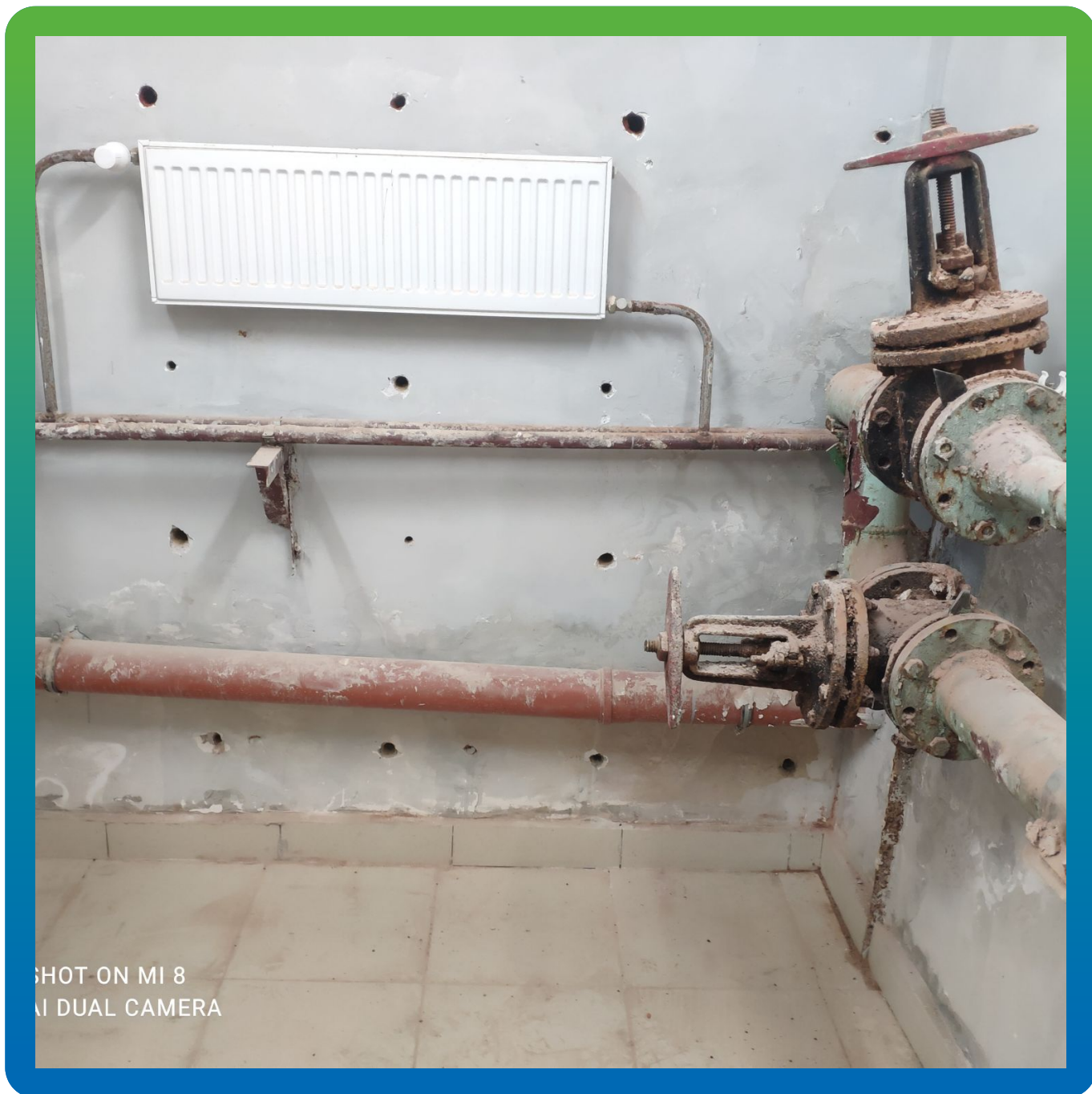
Сверление шпуров для последующей установки пакеров для инъектирования
