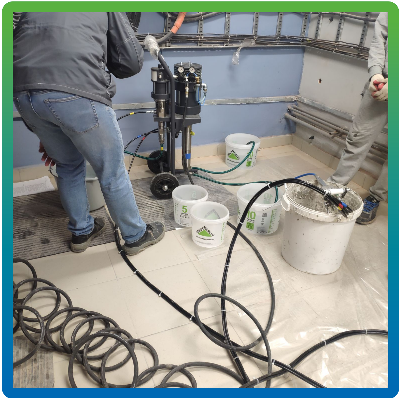
Подготовка насоса к работе
