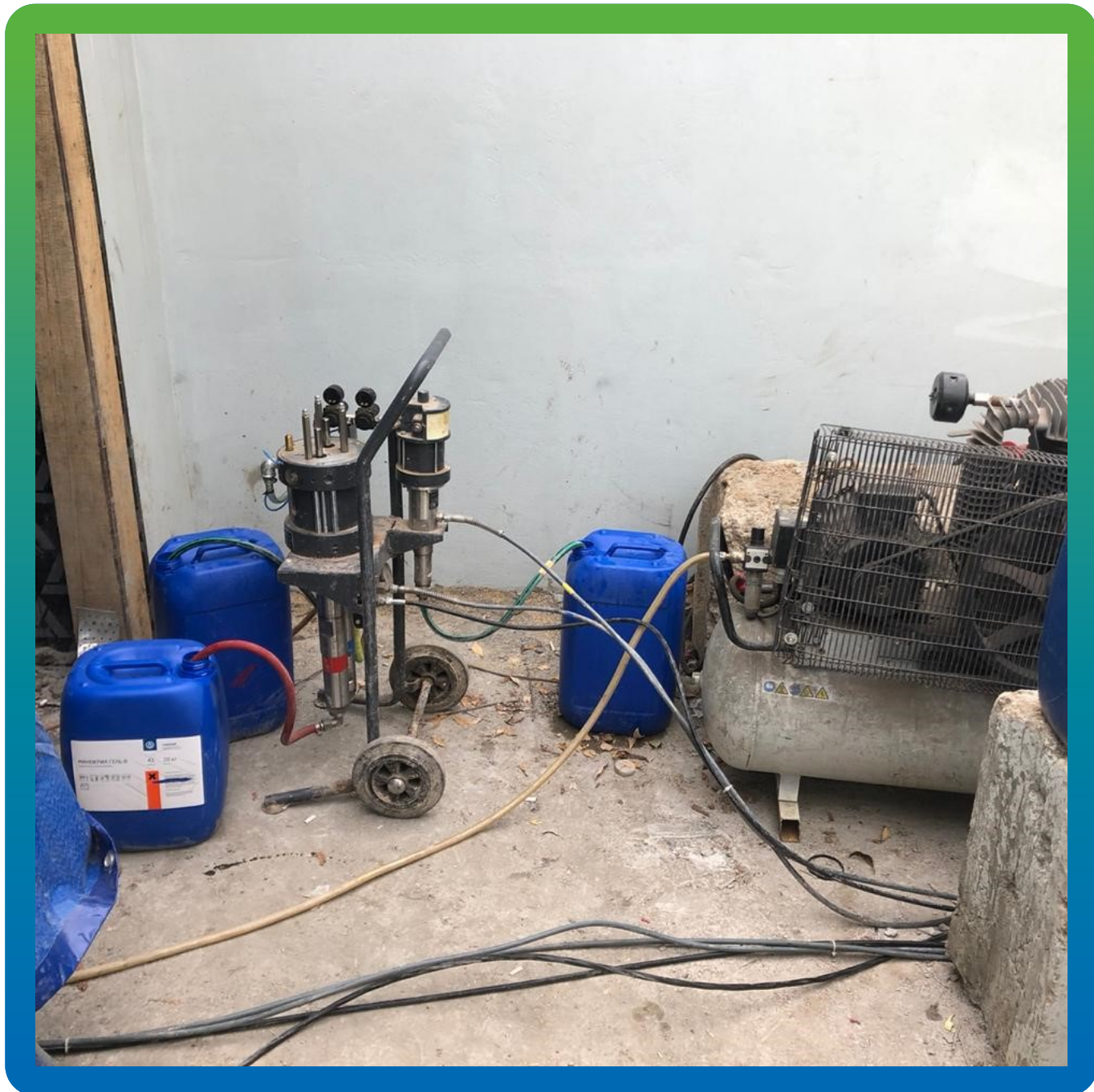
Общий вид работ насос БМ 1425 и Манокрил Гель В
