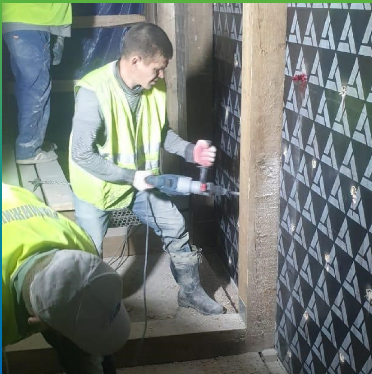
Бурение отверстия под пластиковые пакер БМ 2839 18/105
