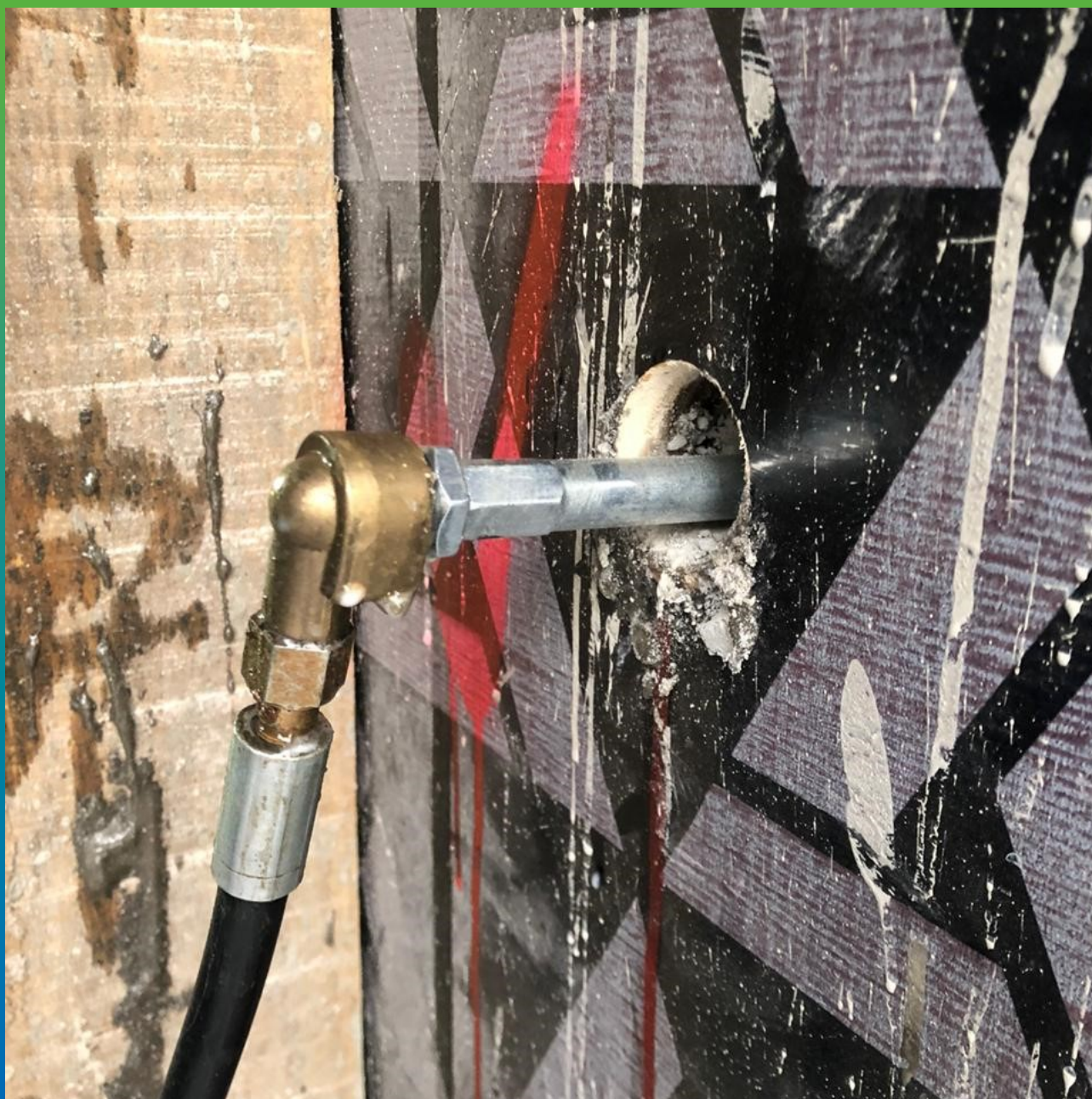
Прокачка Манокрил Гель В в подготовленные отверстия
