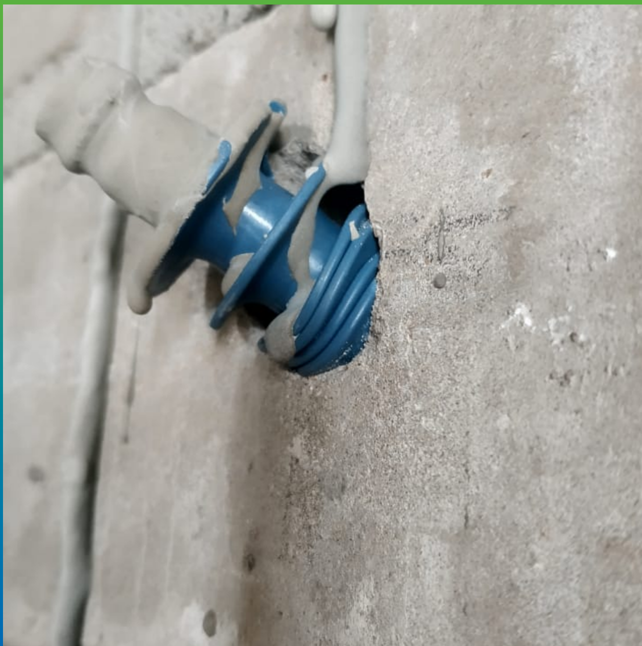
Установка пакеров БМ 2839
