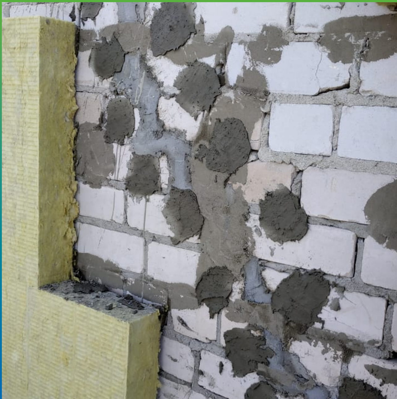
Заполнение отверстий ремонтным составом Стармекс РМЗ
