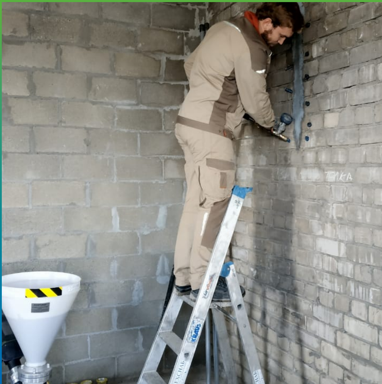
Инъектирование при помощи шнекового насоса БМП6
