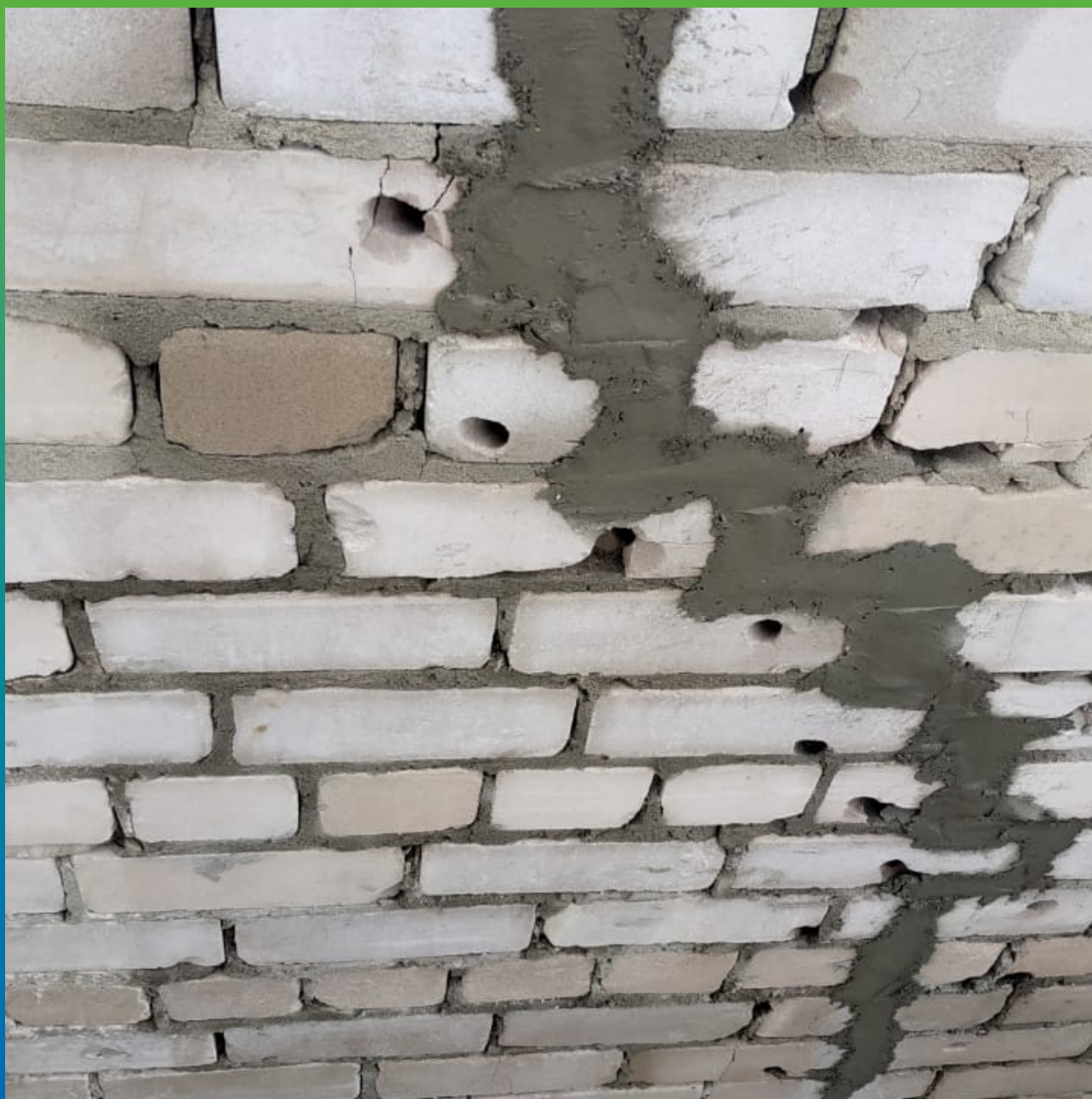
Зачеканка трещин при помощи Стармекс РМЗ
