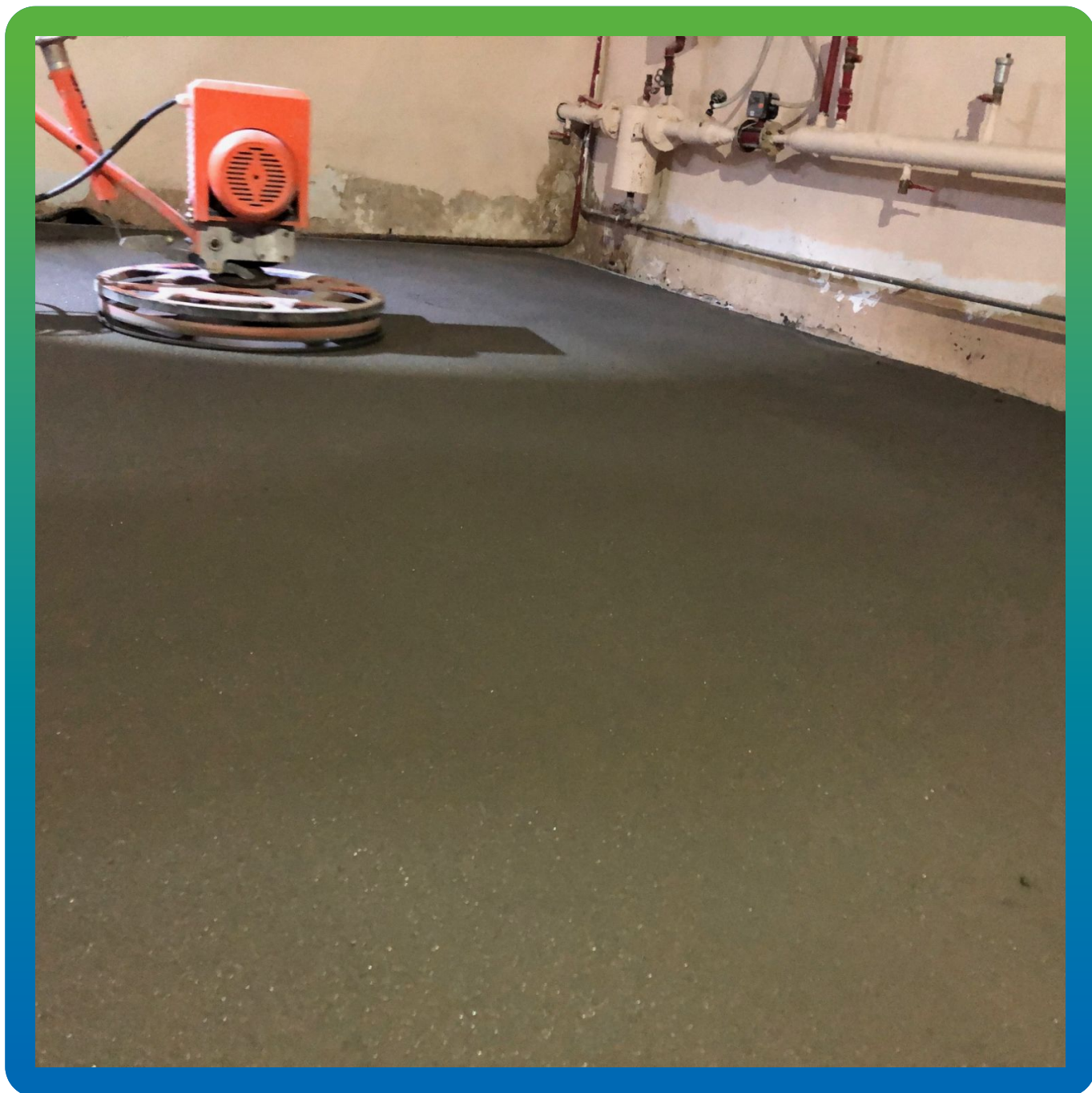
Затирка поверхности после внесения Стармекс Топ
