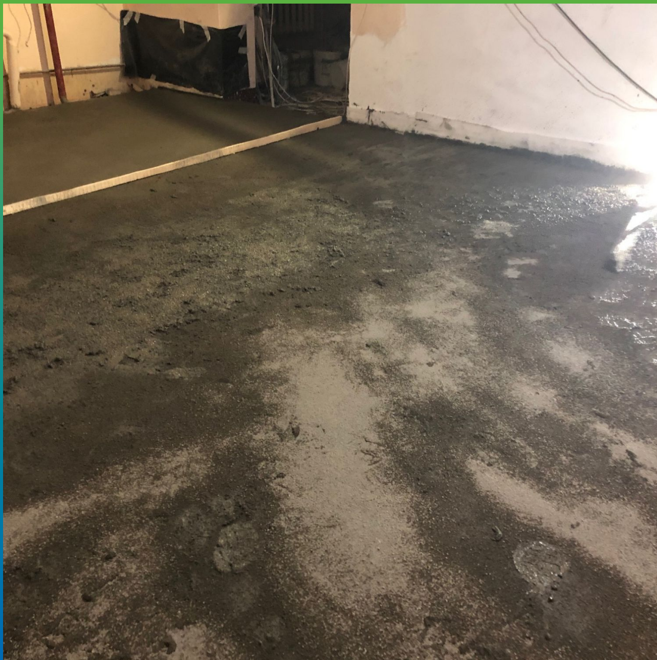
Внесение упрочнителя Стармекс Топ
