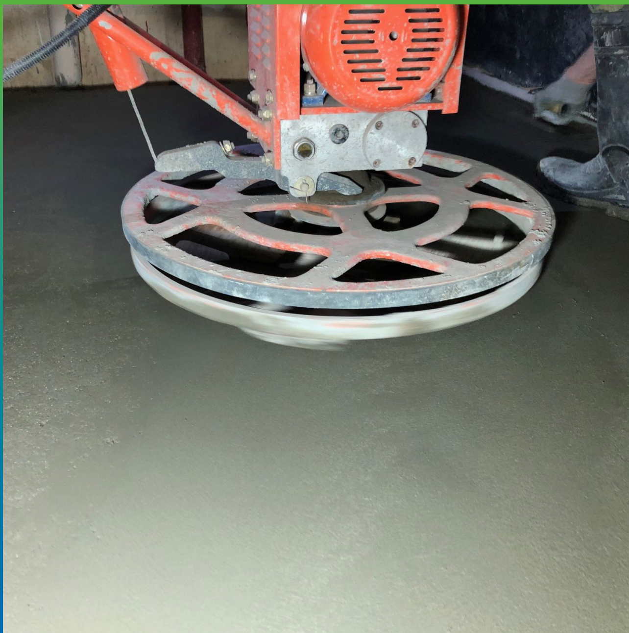
Заглаживание поверхности при помощи металлических лопастей
