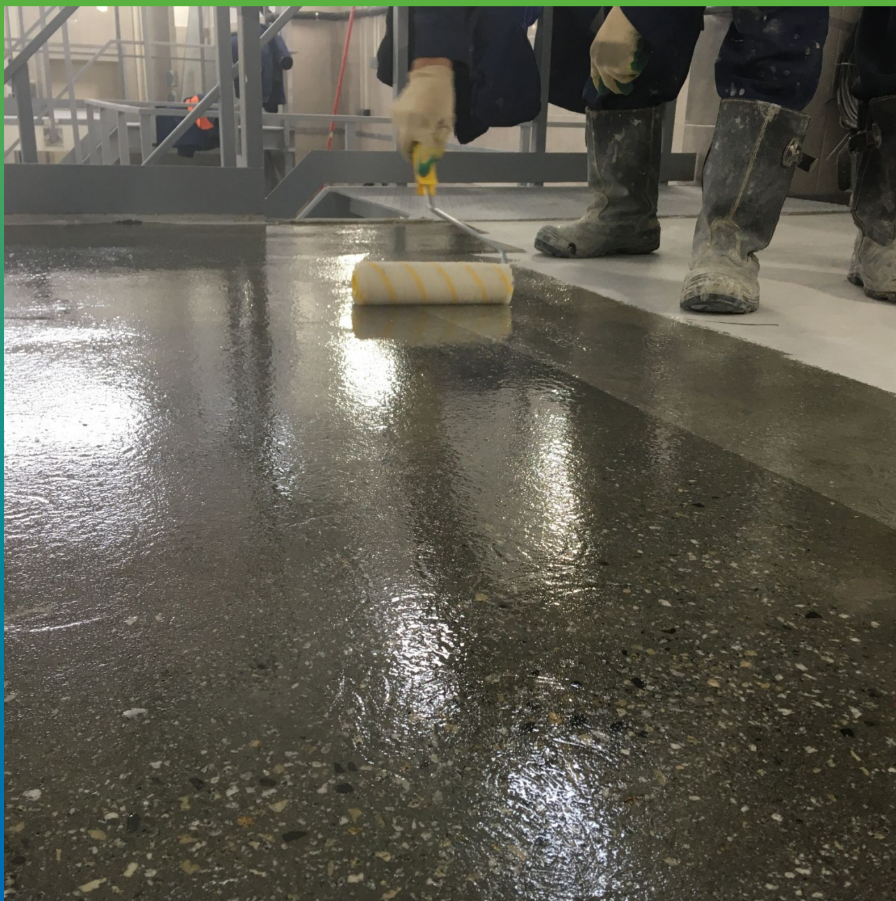
Грунтование поверхности с помощью ДенсТоп ЭП100
