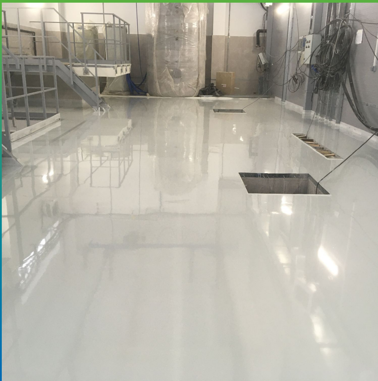
Итоговый вид цеха после устройства эпоксидного покрытия ДенсТоп ЭП500
