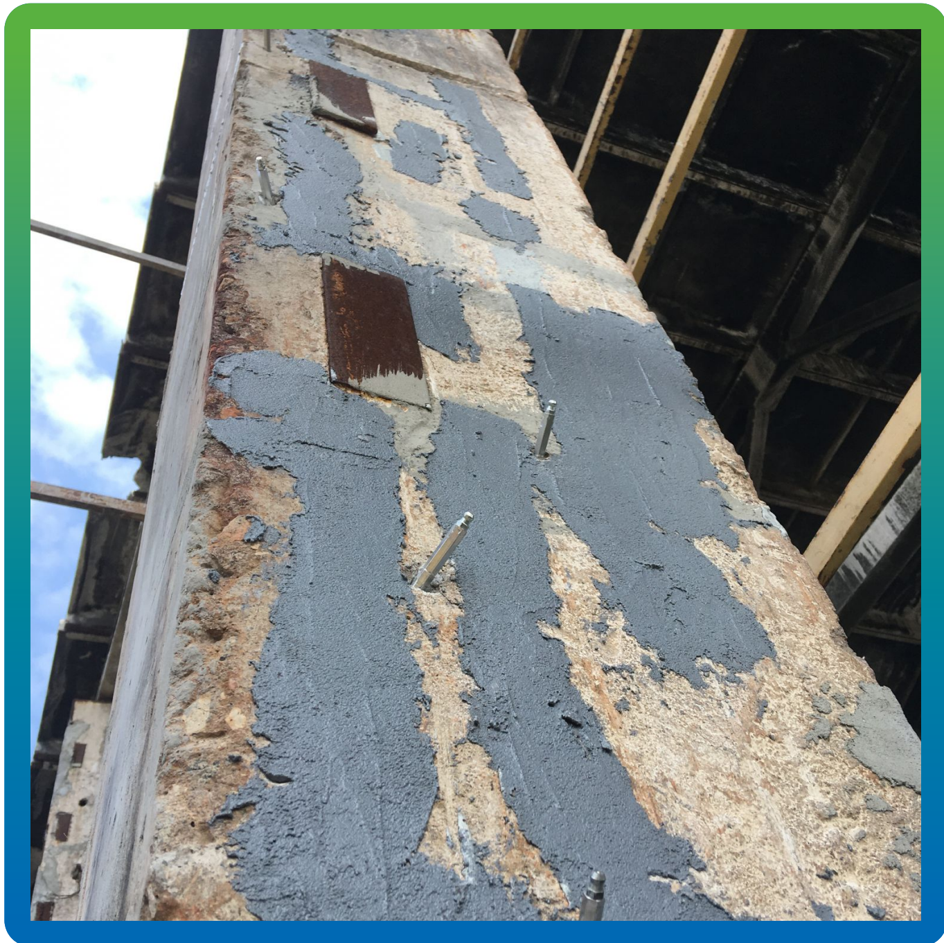
Вид подготовленного участка перед инъектированием Манопокс 352
