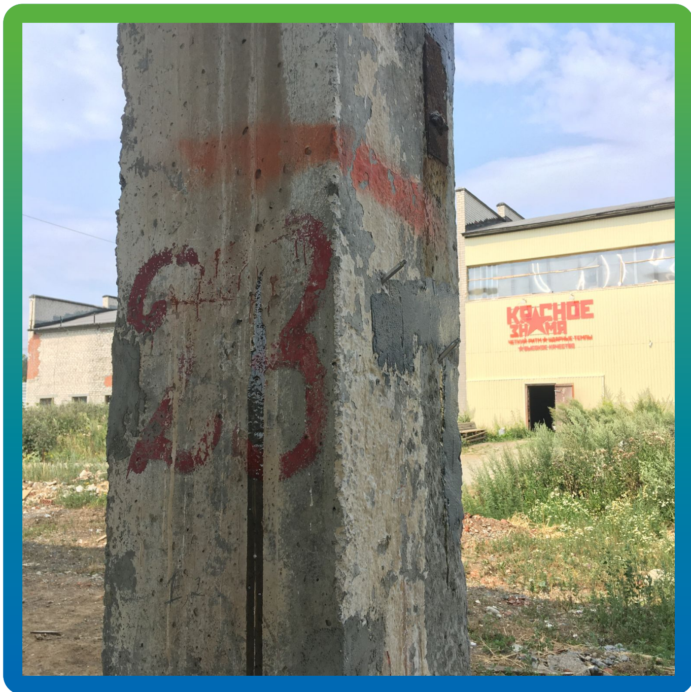
Вид проинъектированного участка с помощью Манопкс 352
