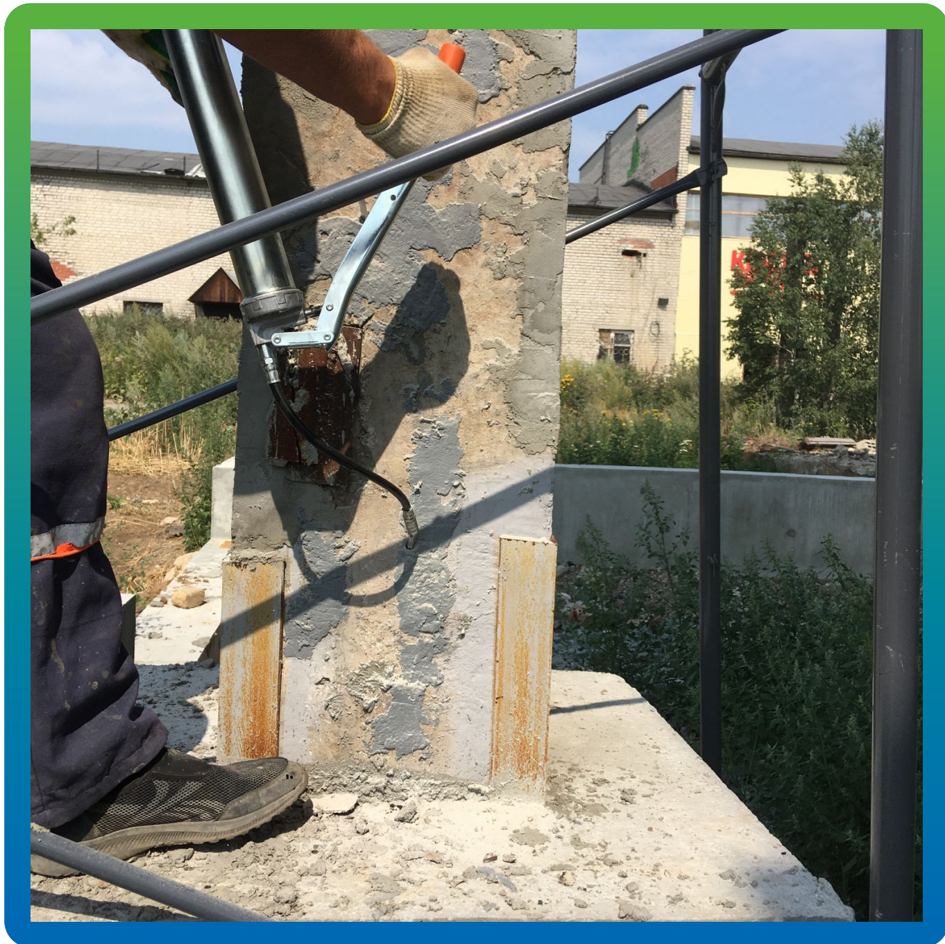
Инъектирование Манопакс 352 через ручной насос БМ 0203
