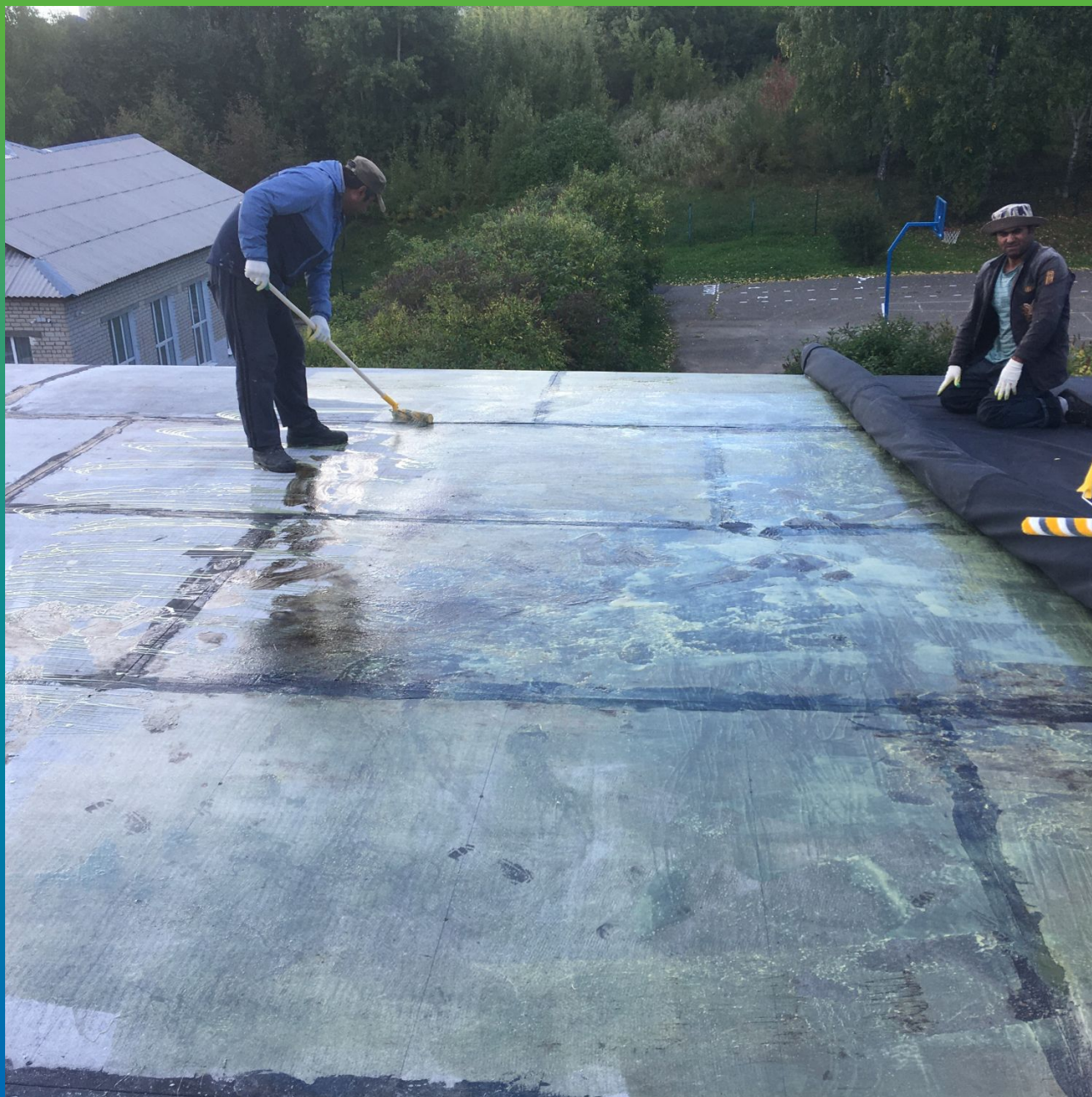
Приклейка ЭПДМ мембраны Преласта СТ к основанию с помощью Адгезива П400
