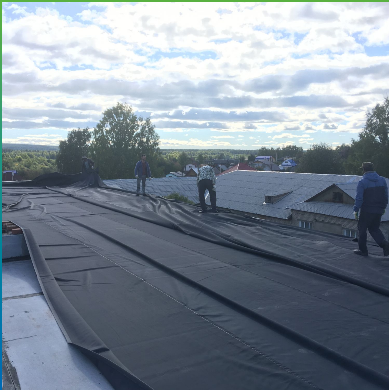
Укладка ЭПДМ мембраны Прелести СТ 1.2 мм
