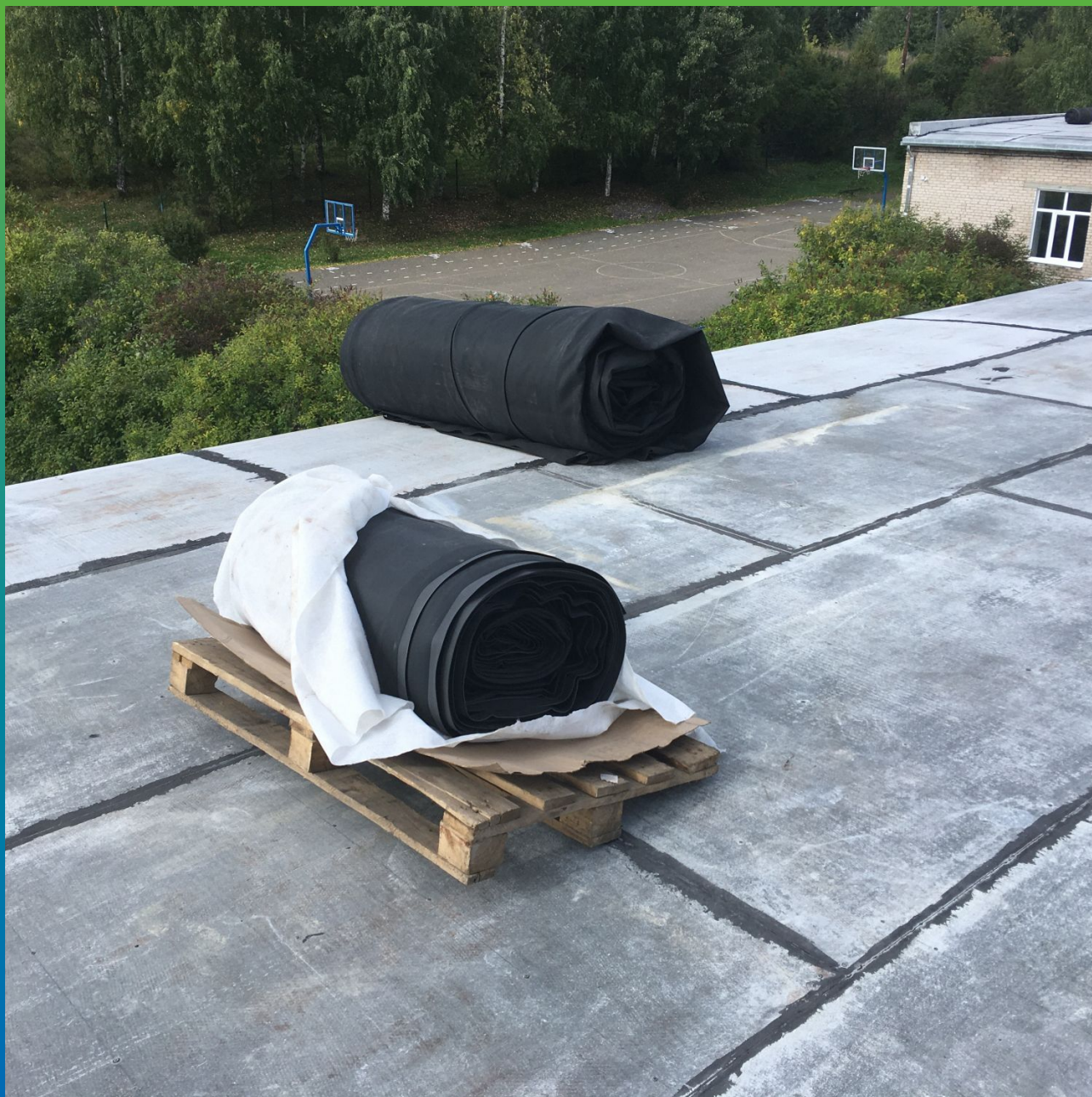
ЭПДМ мембрана Преласта СТ 1.2 мм на объекте
