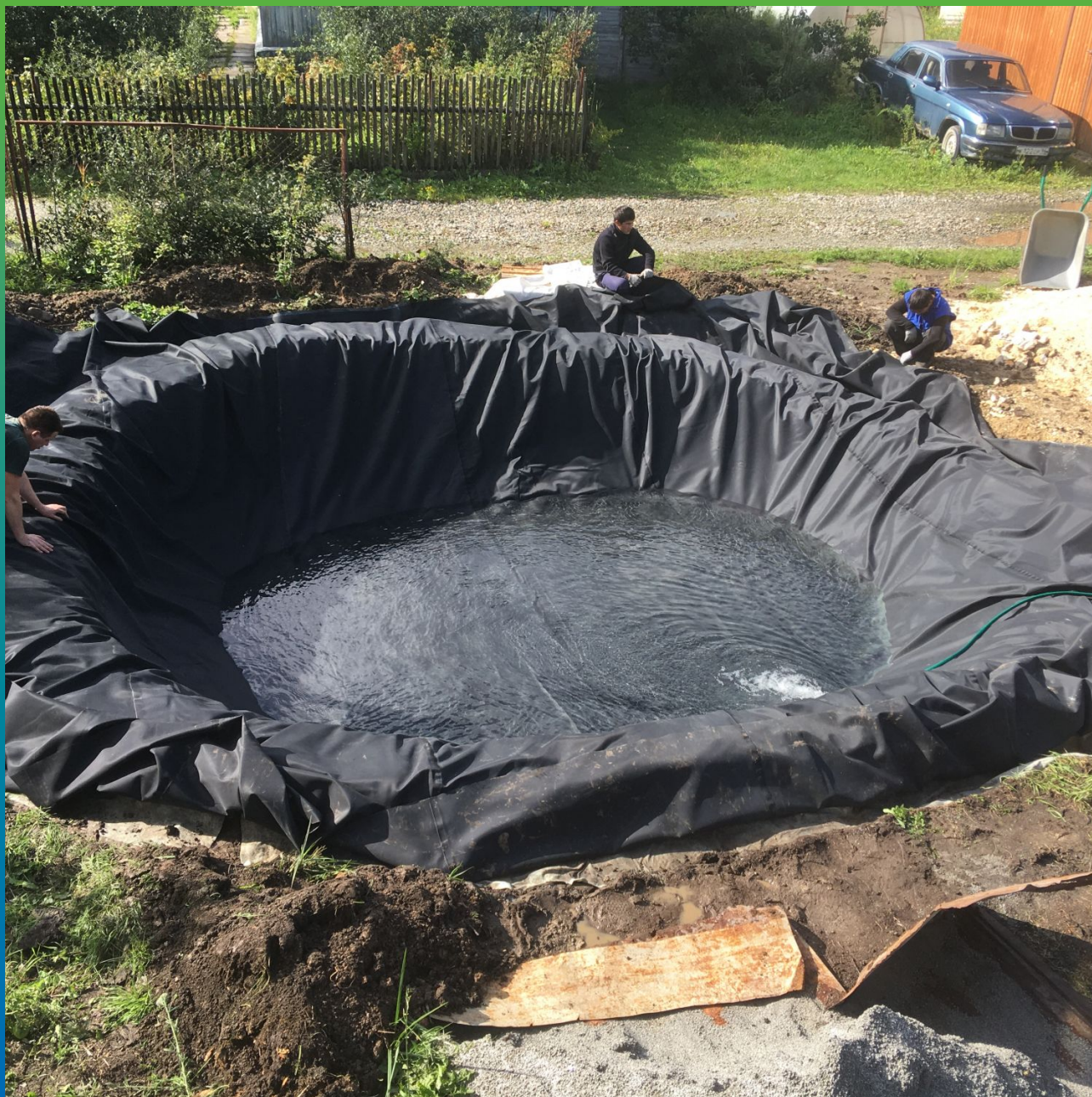
Укладка ЭПДМ мембраны Прелести СТ 1.2 мм
