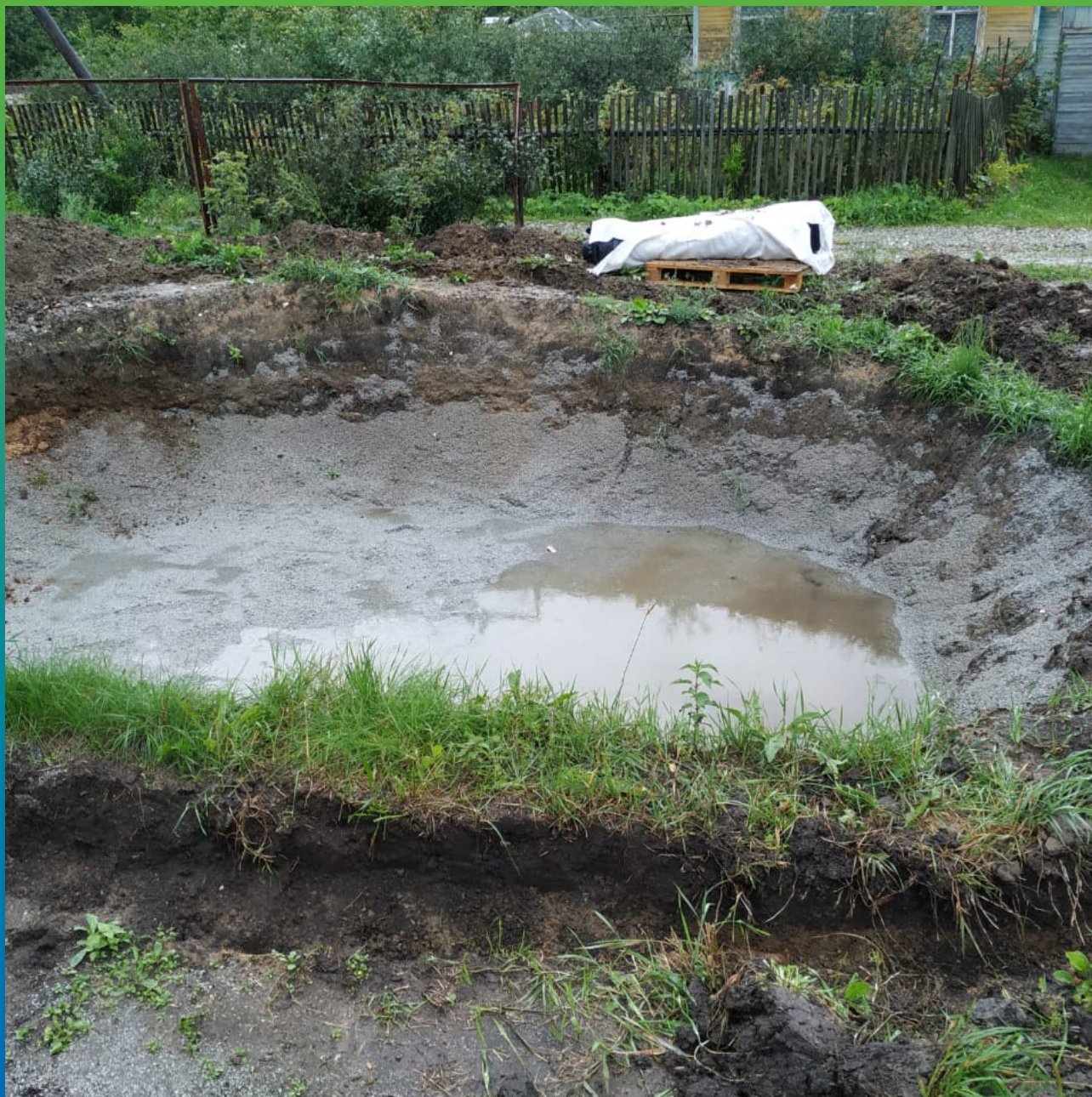
Вид материала на объекте - ЭПДМ мембрана Прелести СТ 1.2 мм
