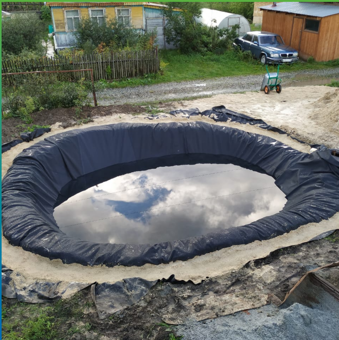
Финальный вид водоема с уложенной и закрепленной ЭПДМ мембраны Прелести СТ 1.2 мм
