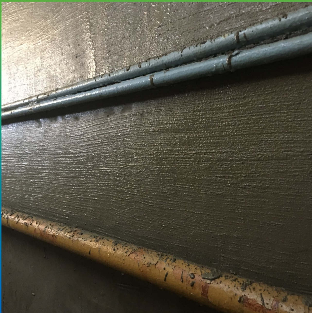
Вид нанесенного гидроизоляционного покрытия Стармекс Кристалл
