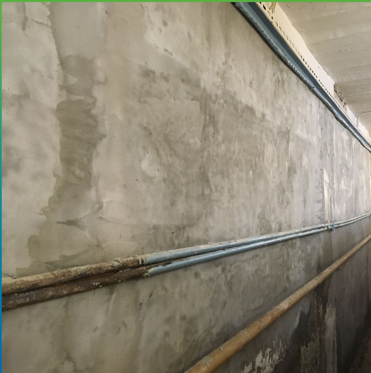
Вид подготовленной поверхности с помощью Стармекс РМЗ
