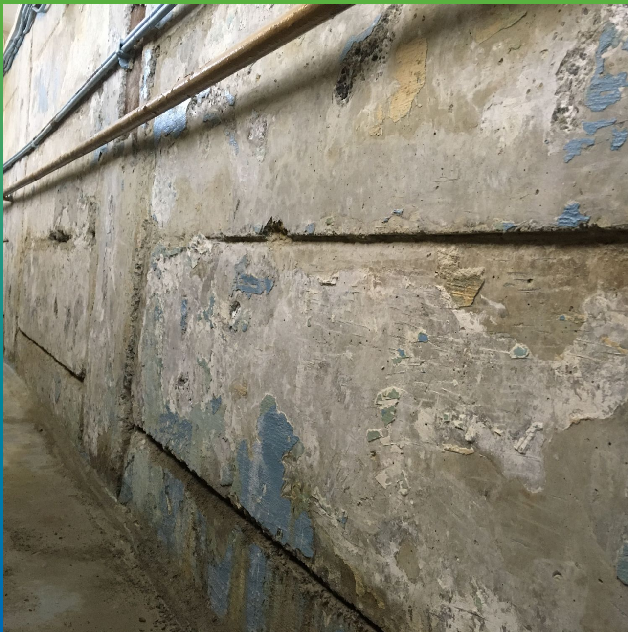
Вид расшитых швов ФБС
