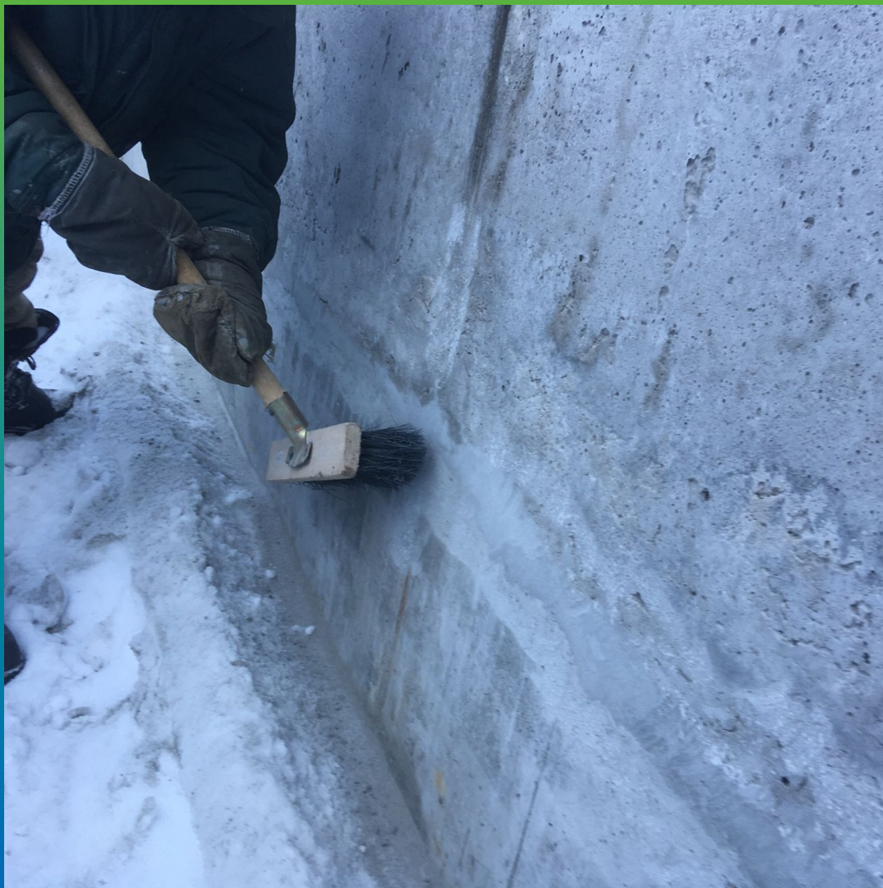
Обеспыливание подготовленного участка
