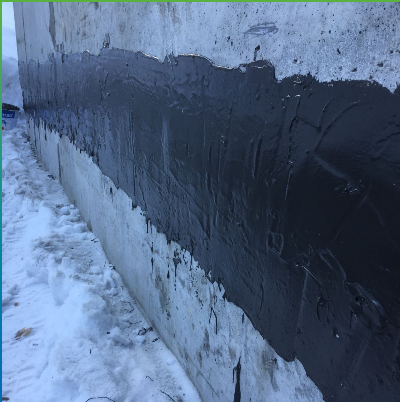
Итоговый вид нанесённого полисульфидного покрытия ДенТоп ПС 391
