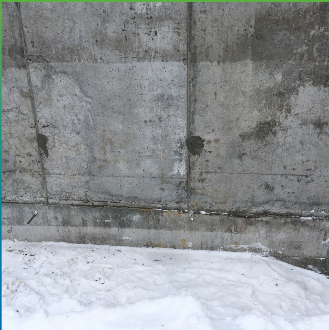
Первоначальный вид примыкания/рабочего шва
