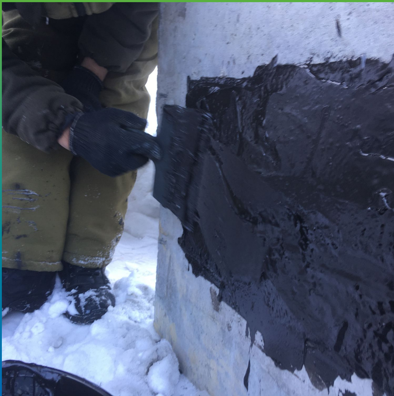
Нанесение полисульфидного гидроизоляционного покрытия ДенТоп ПС 391
