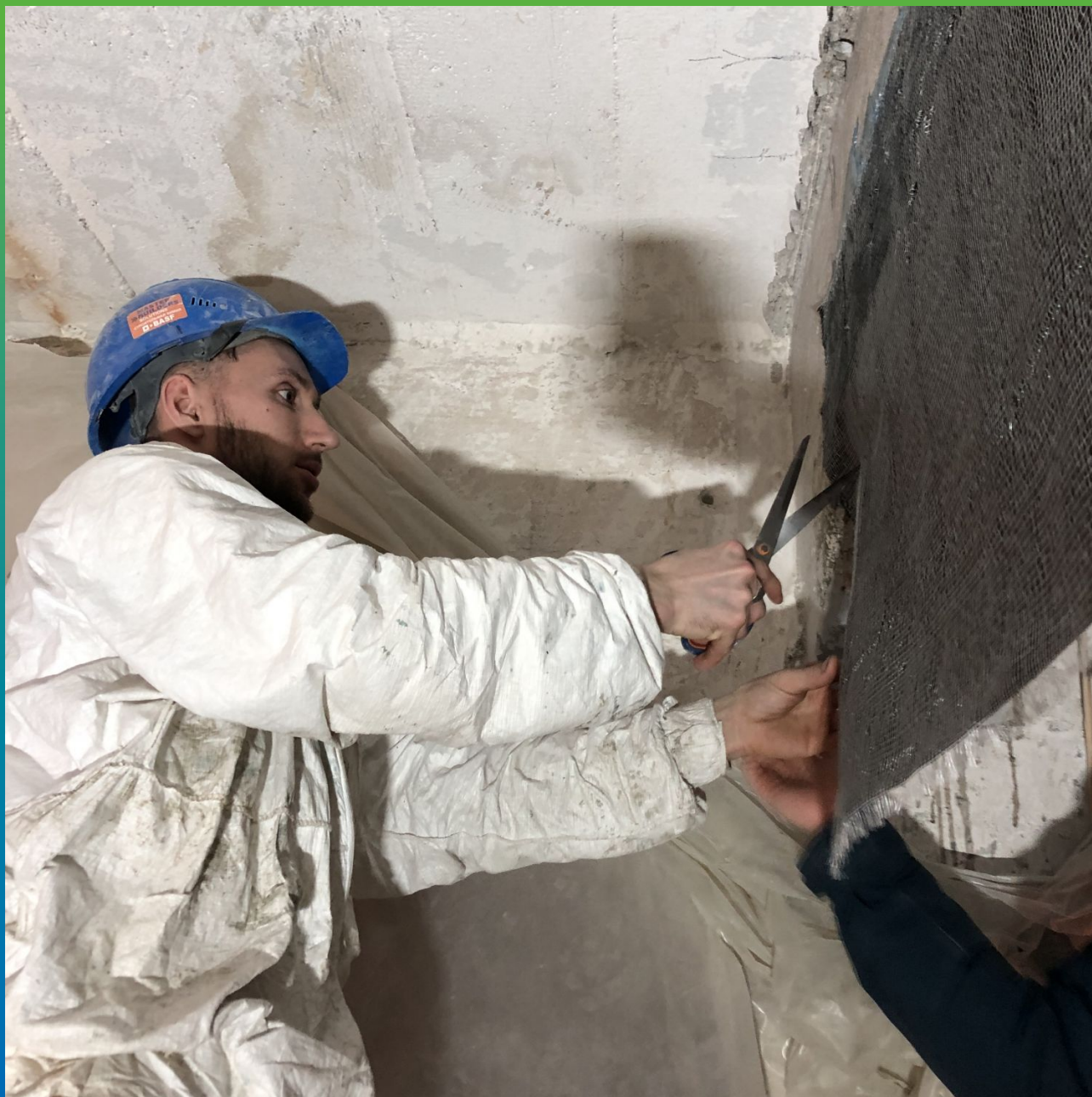
Подгонка Армошел KB 200 по месту. Отсечение излишков.
