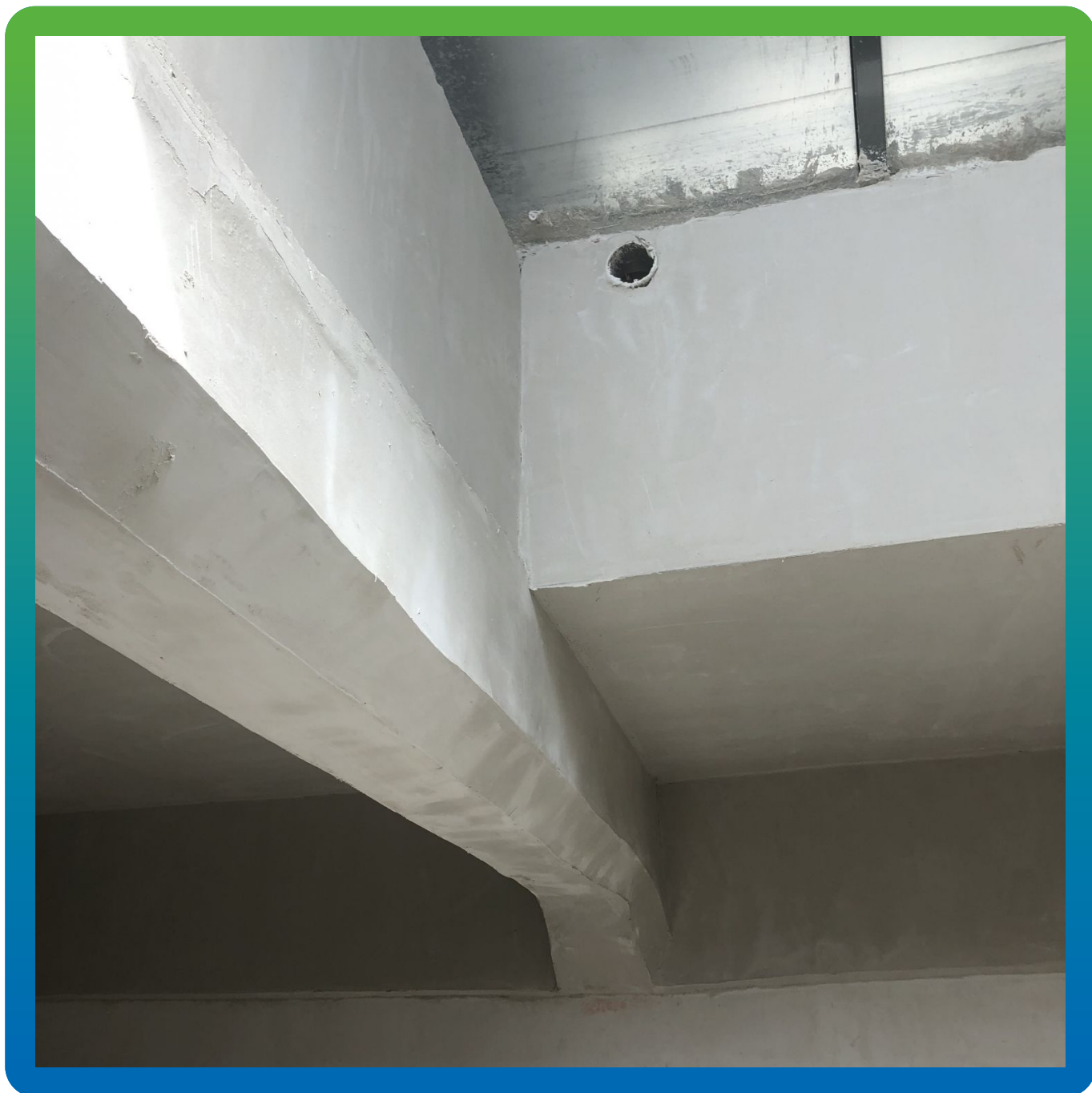
Финишный вид усиленной Армошел и защищенной от огня Пирошел балки.
