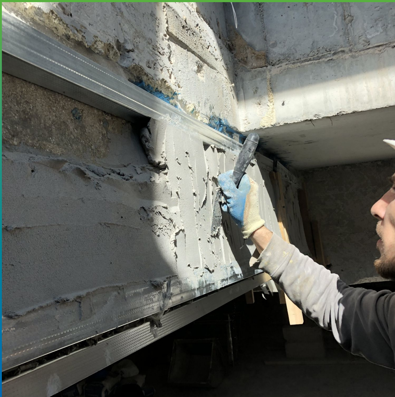
Нанесение и заглаживание финишного слоя Пирошел Цем.
