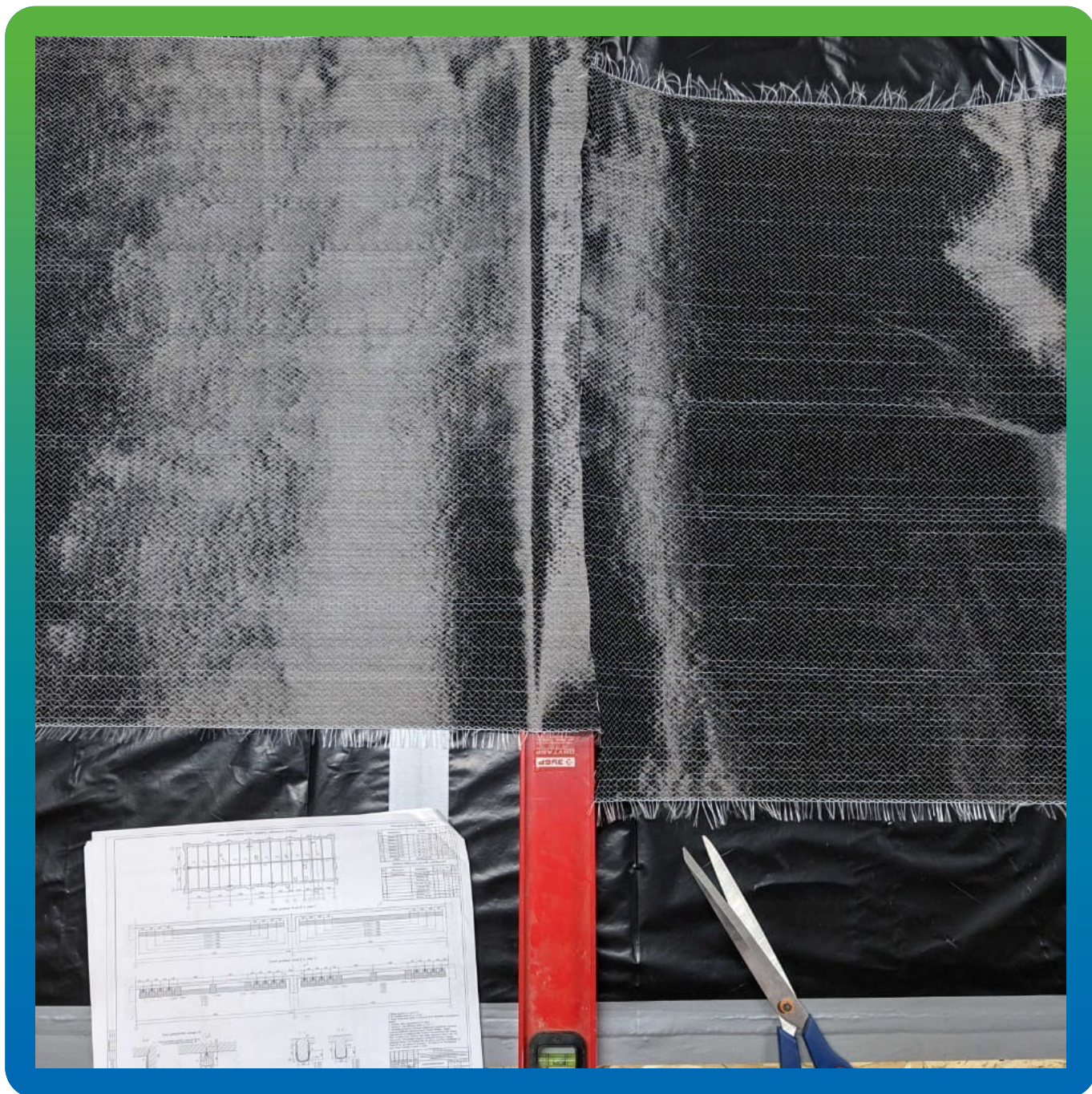
Раскрой углеродного волокна Армошел КВ 200.
