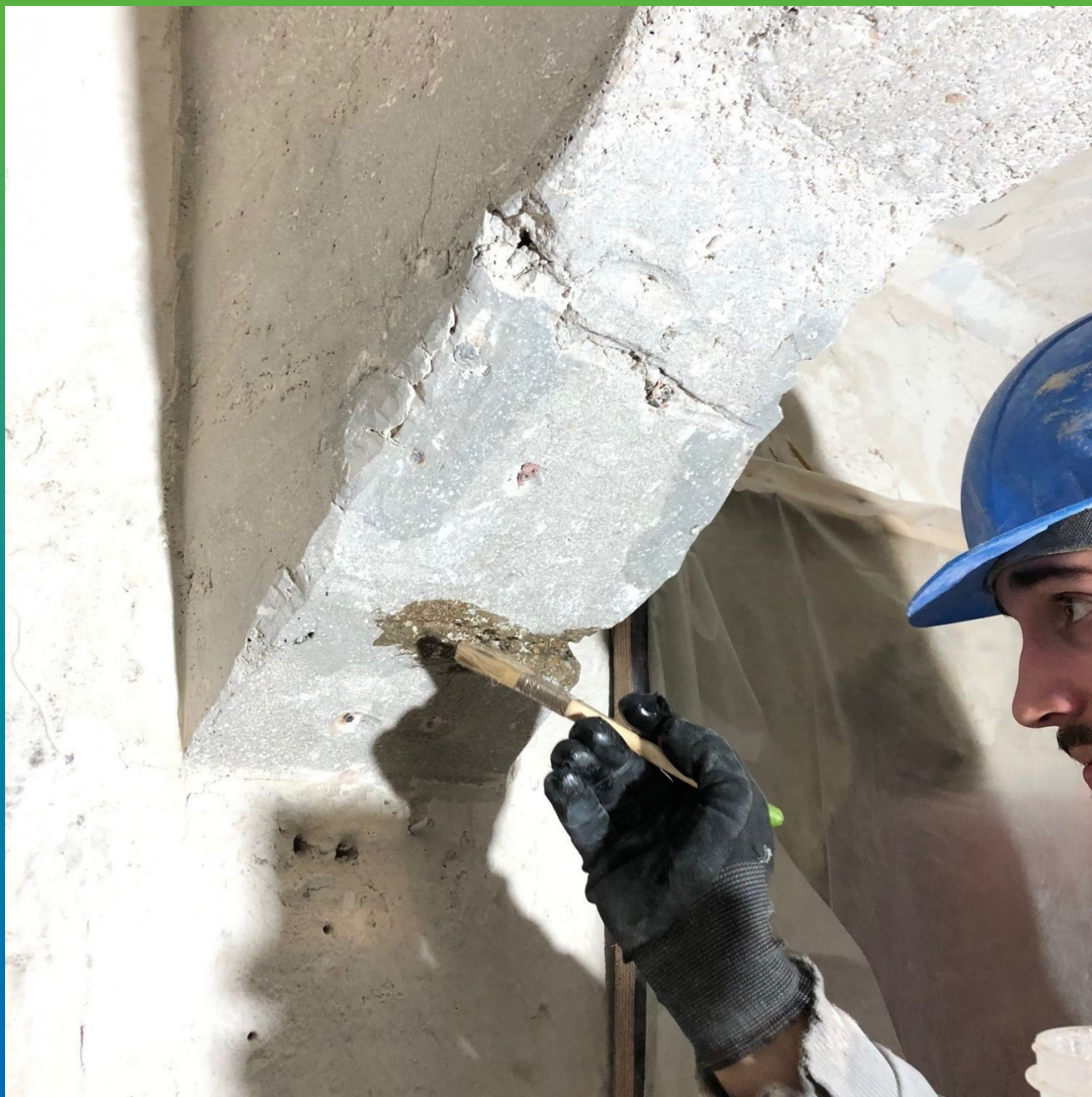
Грунтование дефектов грунтовкой ДенсТоп ЭП 100
