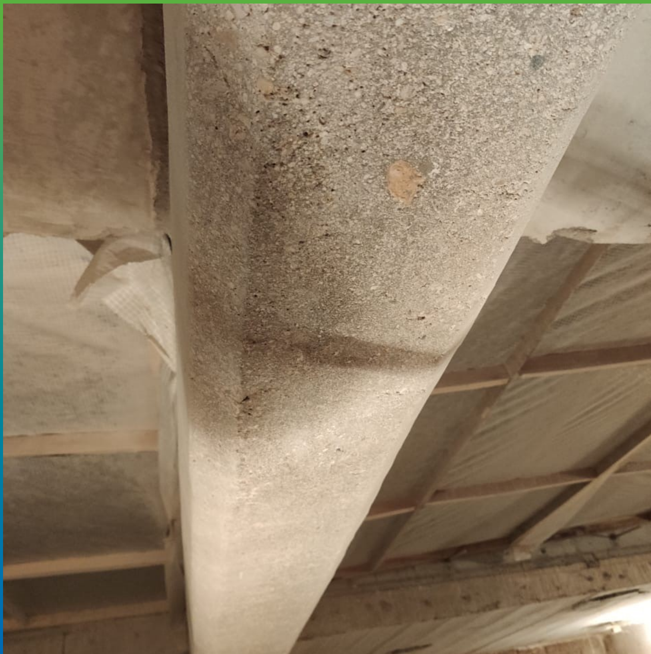
Подготовленная поверхность балки.
