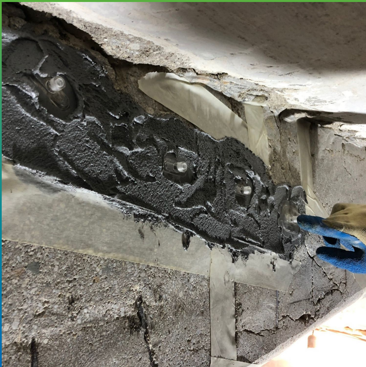
Установка пакеров БМ 0187.
