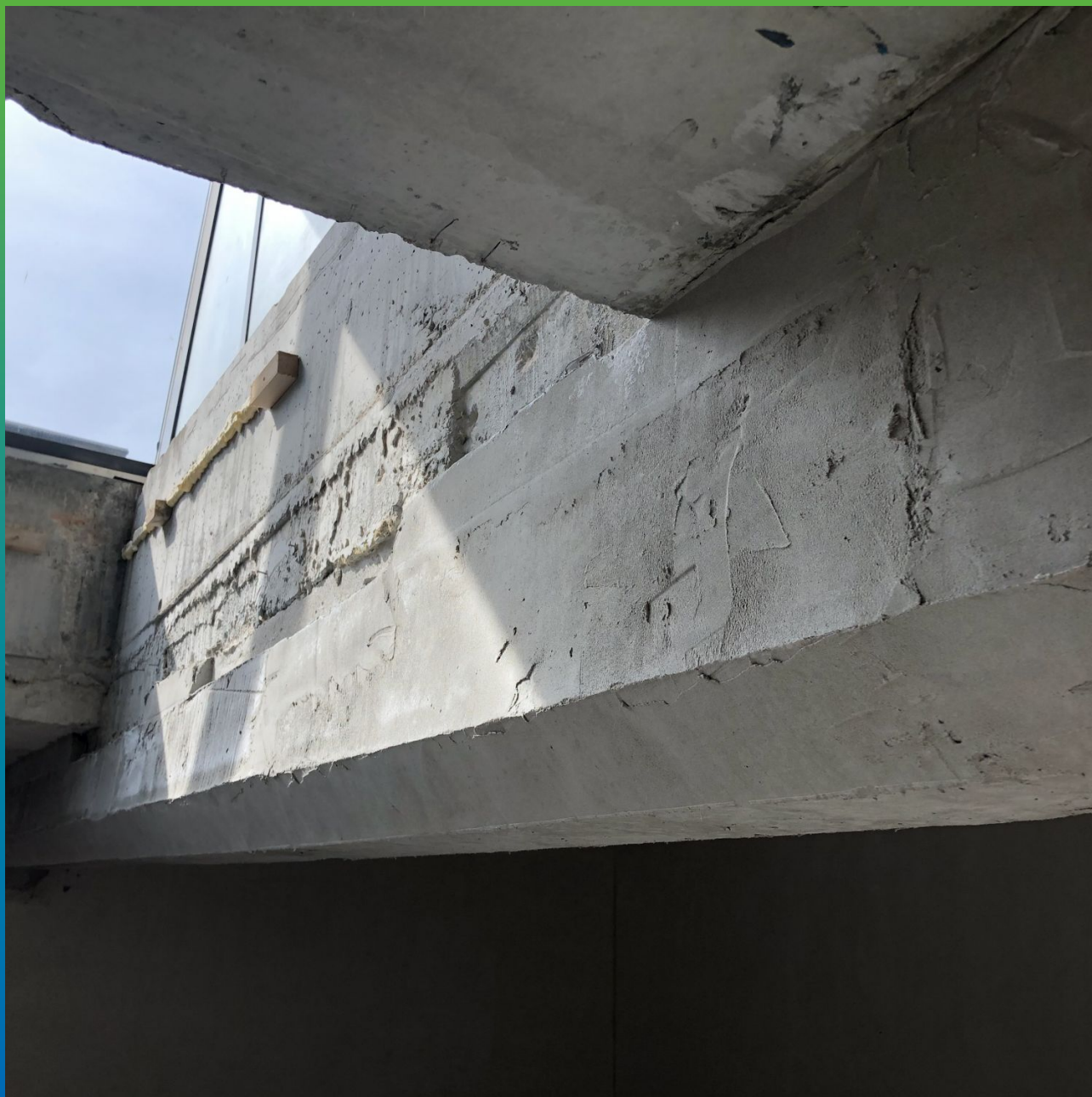
Вид смонтированной огнезащитной штукатурки Пирошел Цем.
