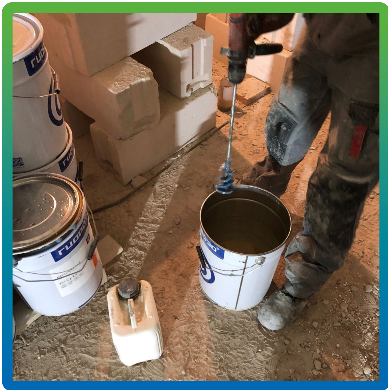
Подготовка и процесс смешивания компонентов Манопкс 352 ЛВ.
