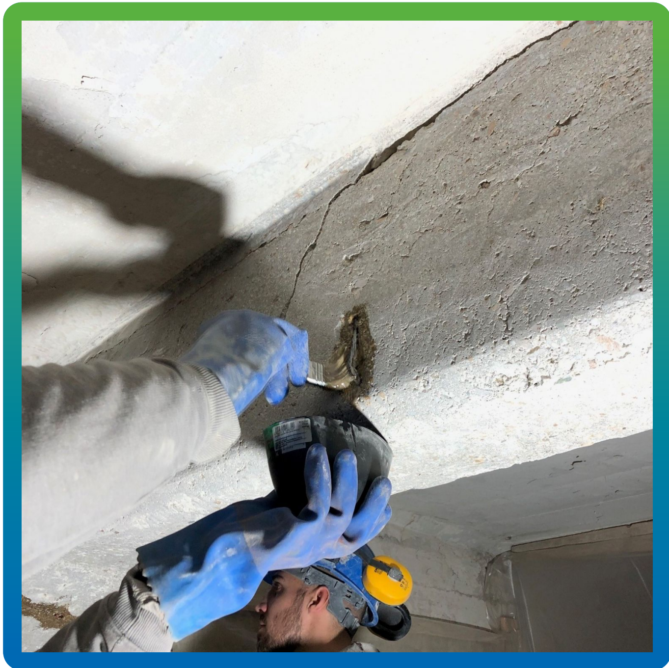
Грунтование дефектов грунтовкой ДенсТоп ЭП 100.
