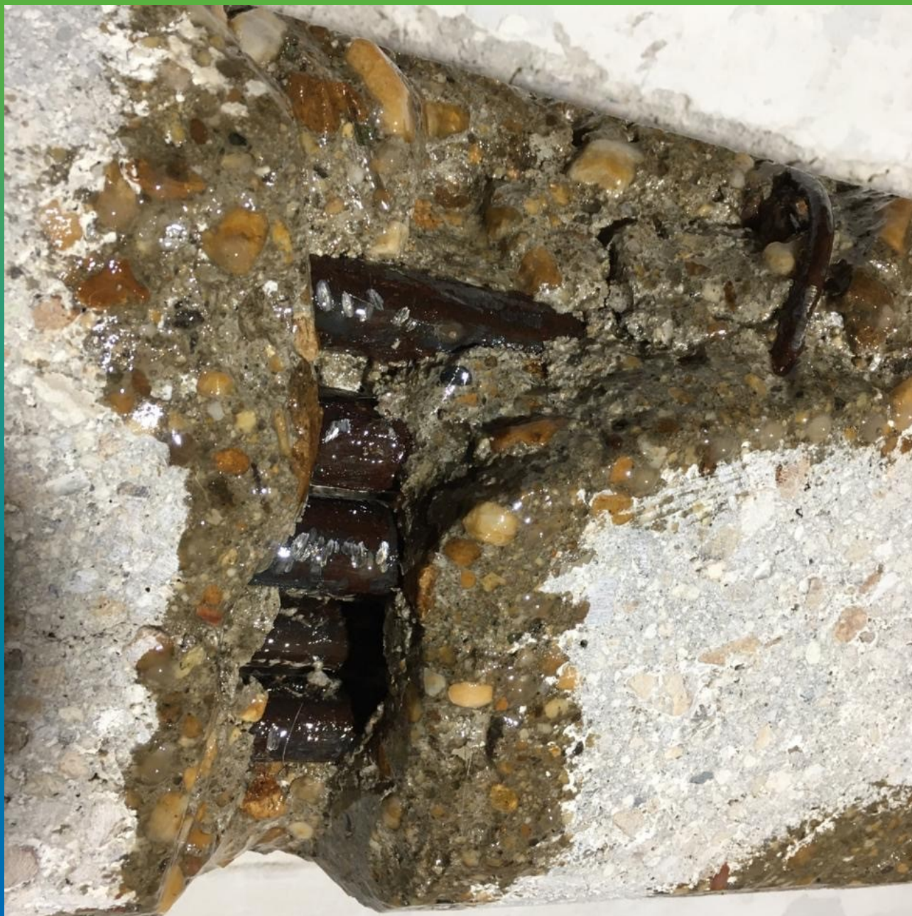
Вид загрунтованного участка.
