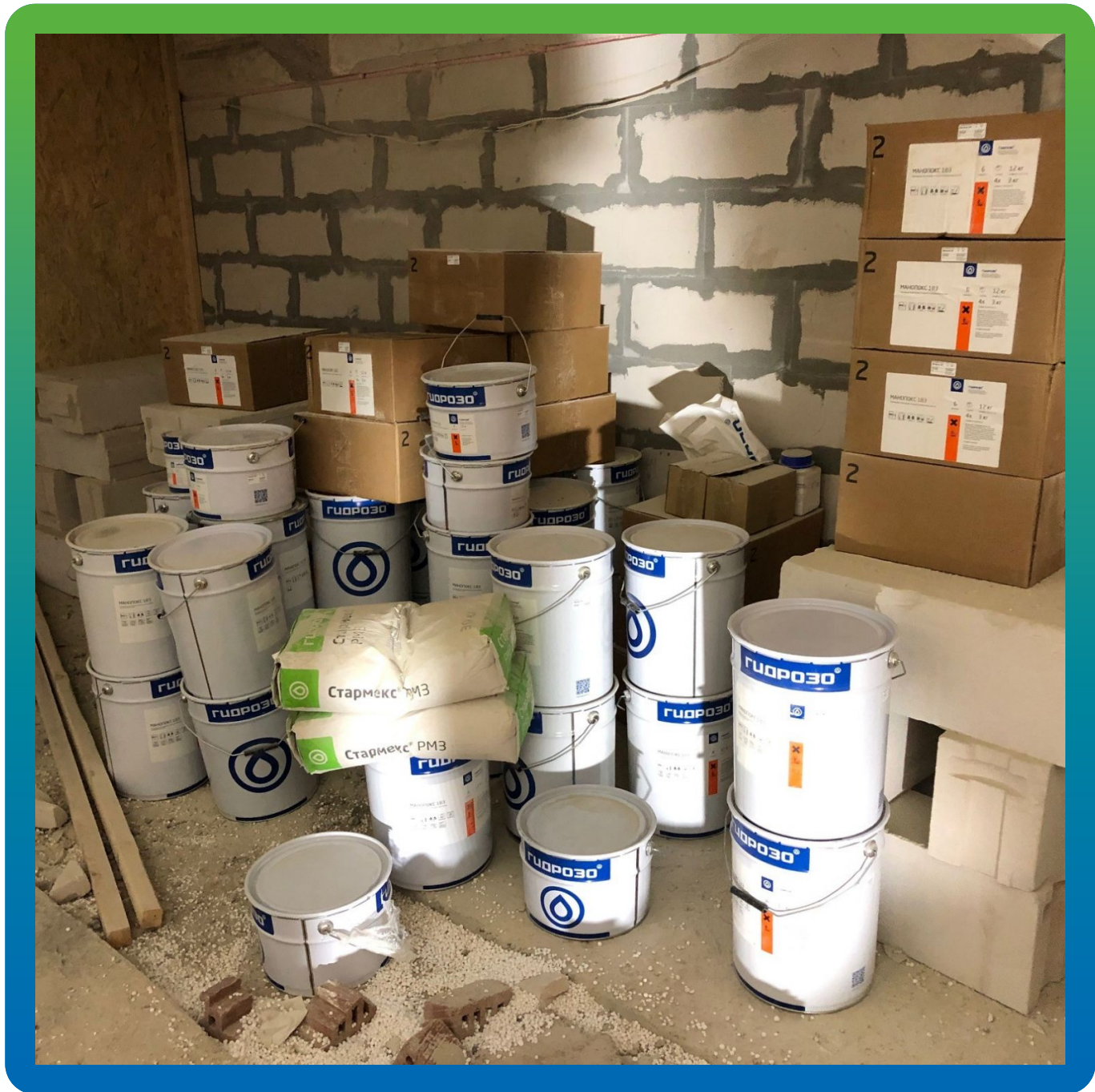
Материалы Гидрозо на объекте.
