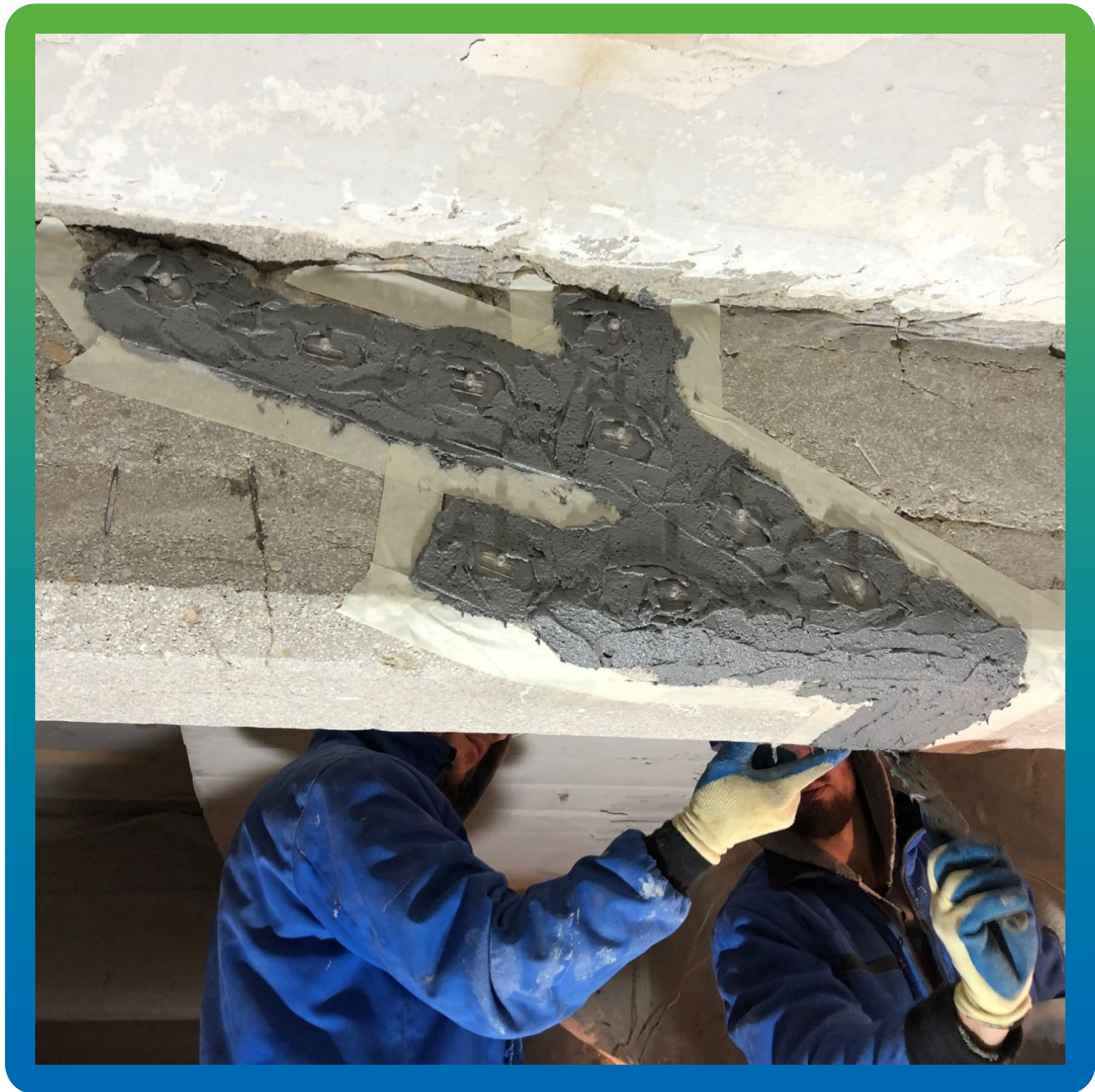
Общий вид подготовленного для инъектирования участка.
