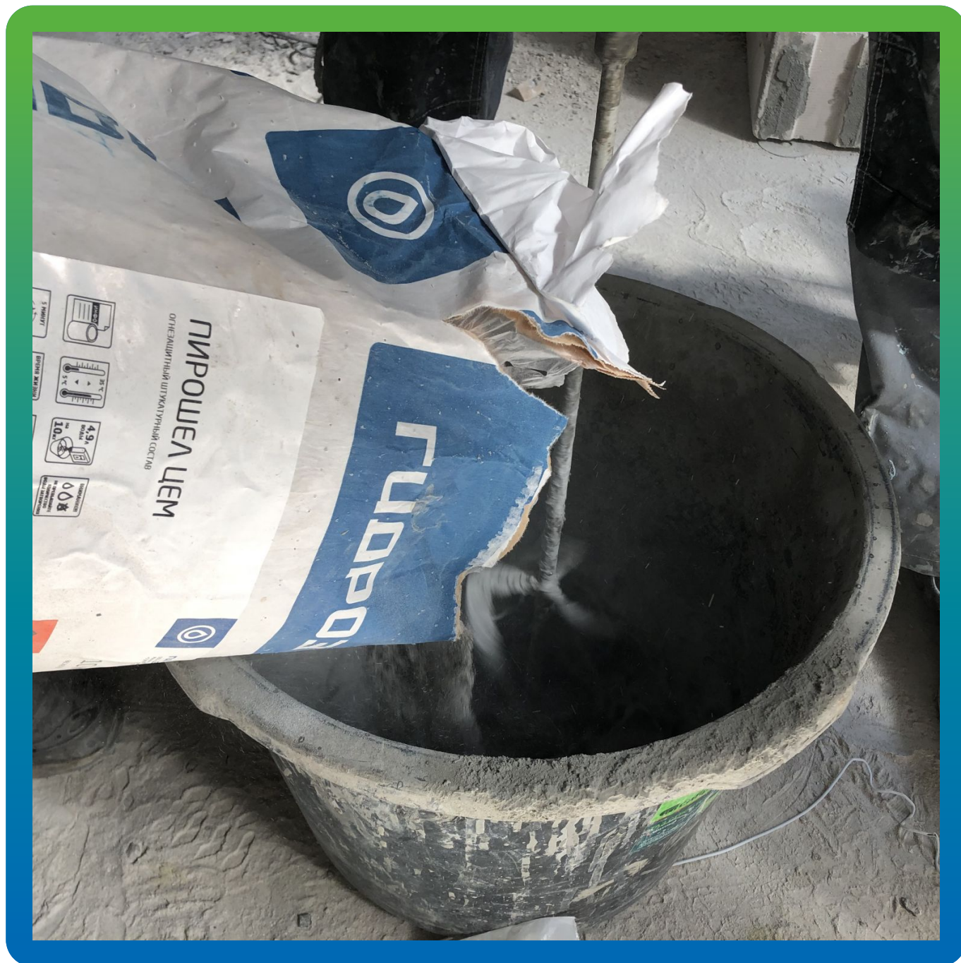
Замешивание огнезащитной штукатурки Пирошел Цем.
