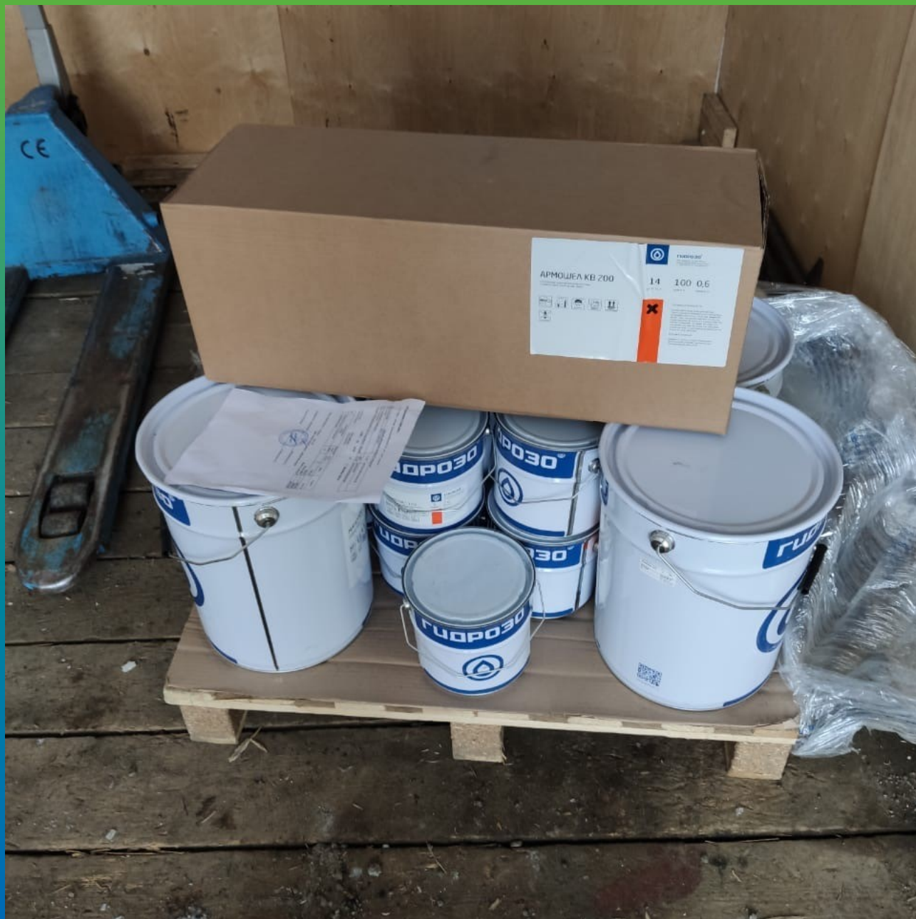
Материалы для этапа усиления композитной системой на объекте.
