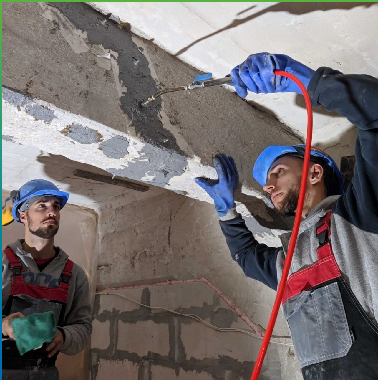
Процесс инъектирования Манопокс 352 ЛВ.
