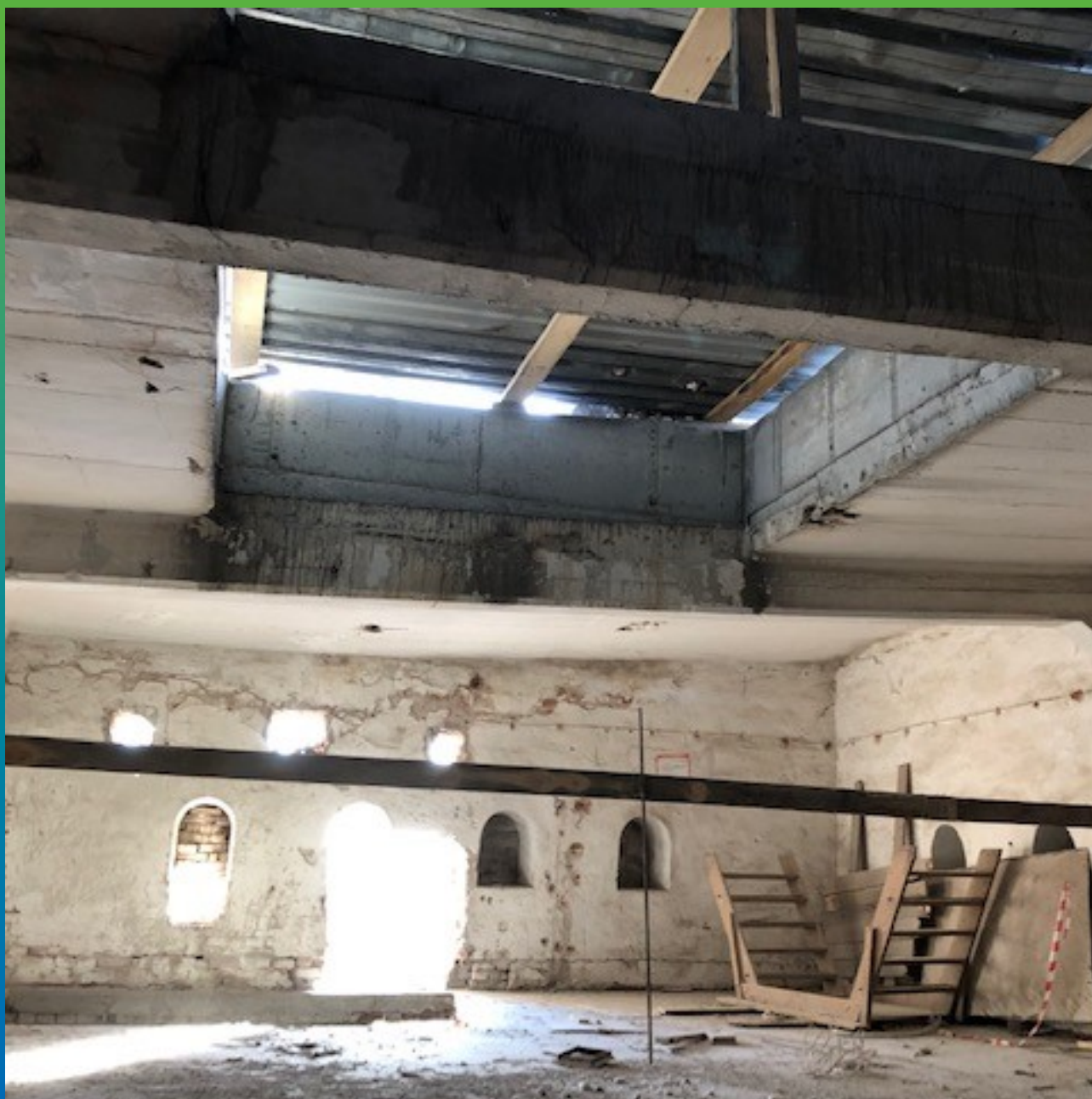
Общий вид второстепенных балок под усиление.
