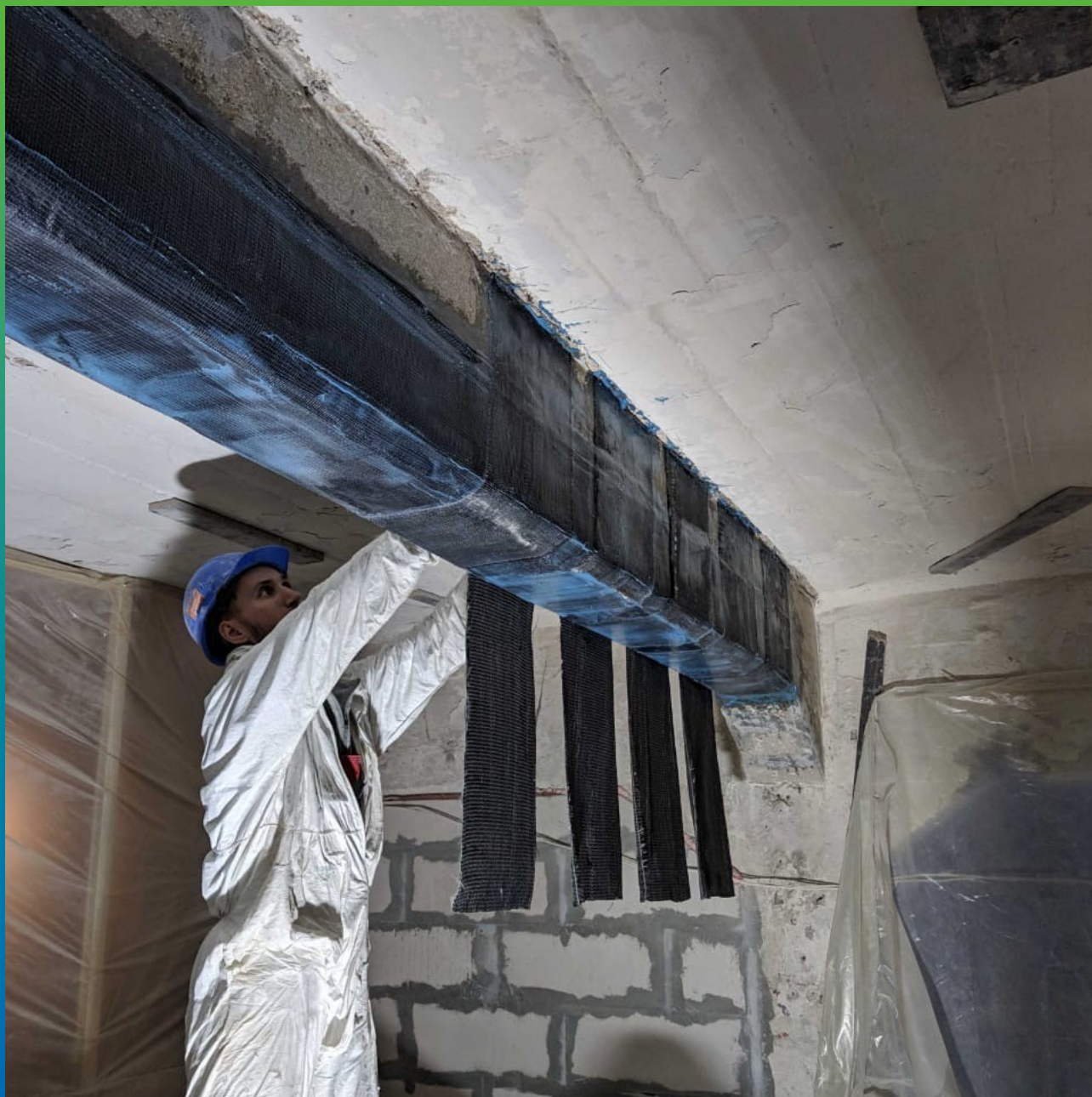
Монтаж U-образных углеродных хомутов.
