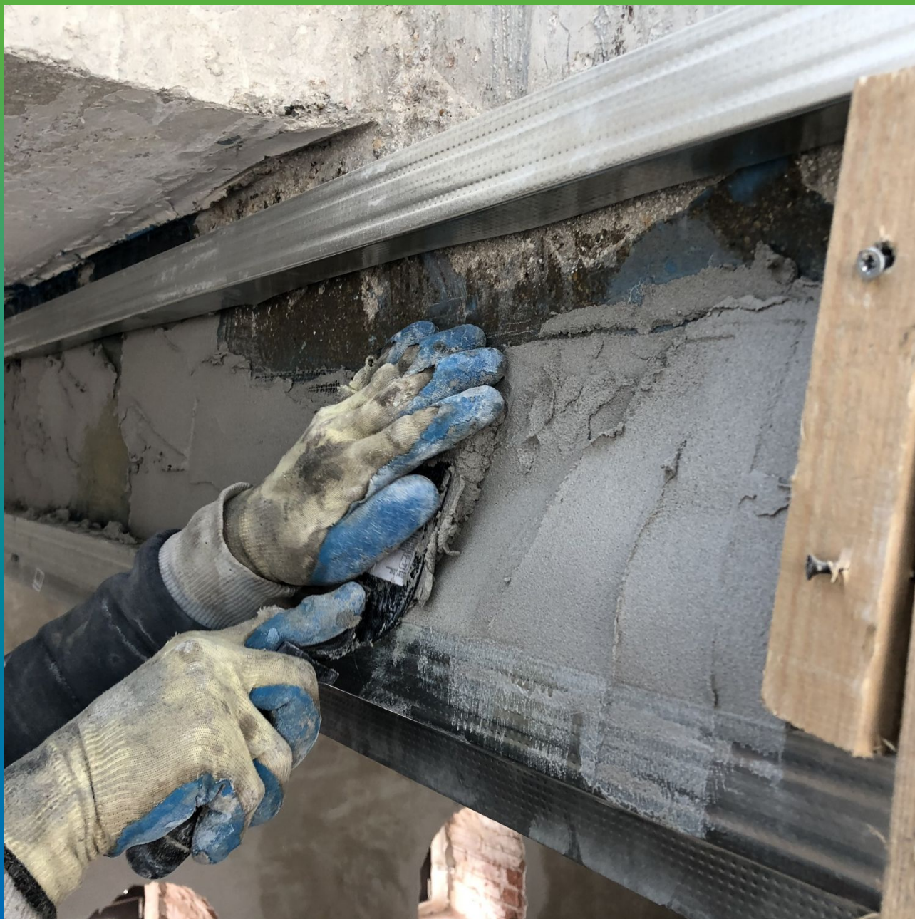
Нанесение адгезионного слоя Пирошел Цем.
