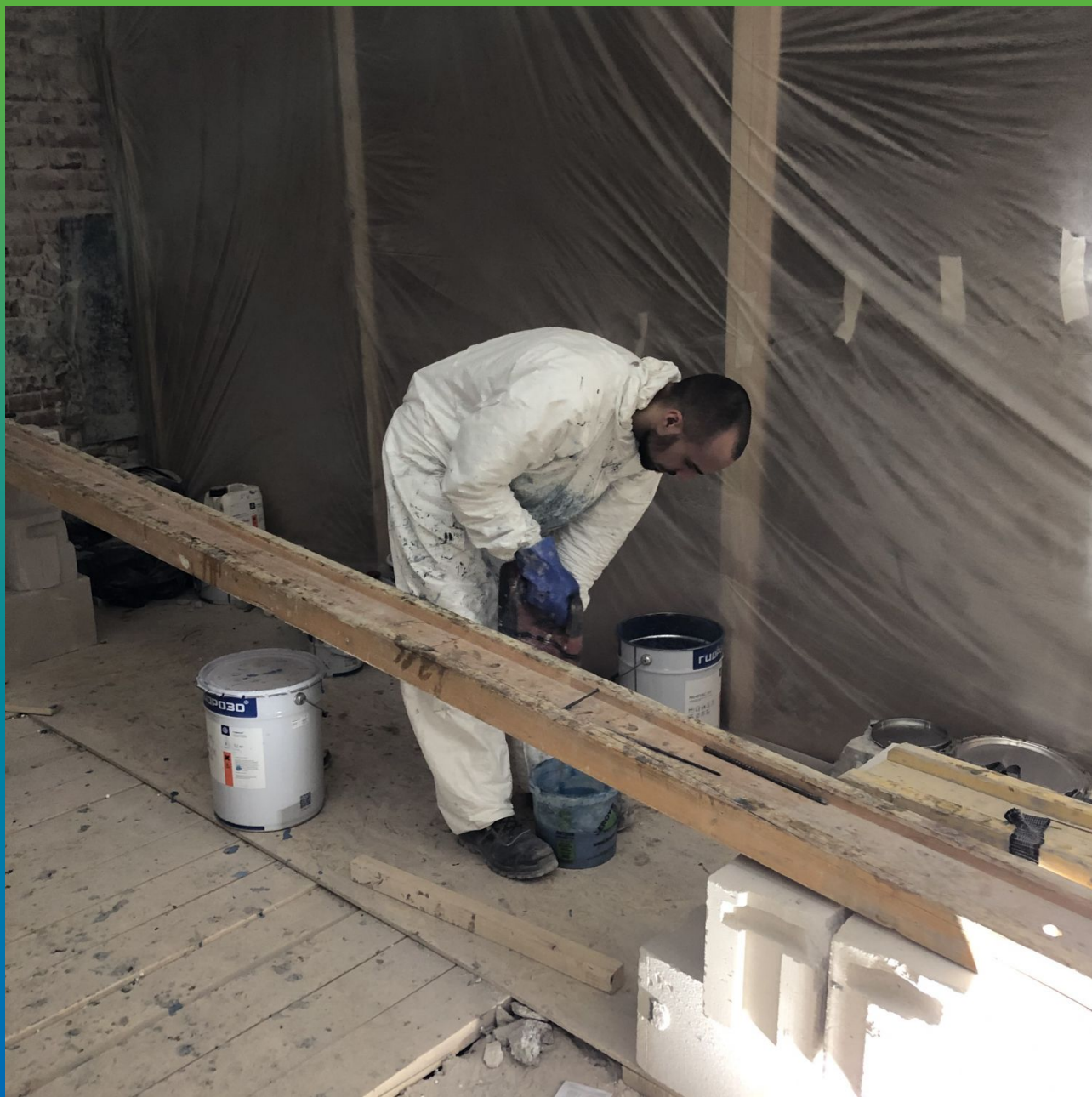
Замешивание эпоксидной матрицы Манопокс 183.
