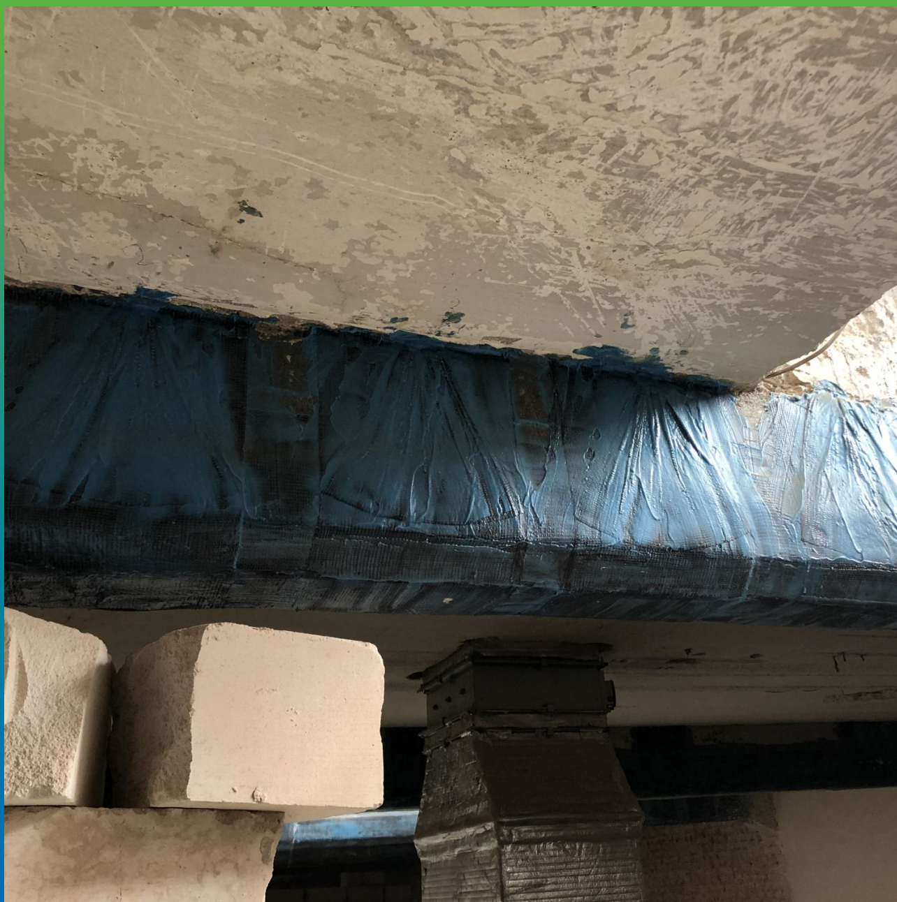
Общий вид смонтированных углеродных анкеров.
