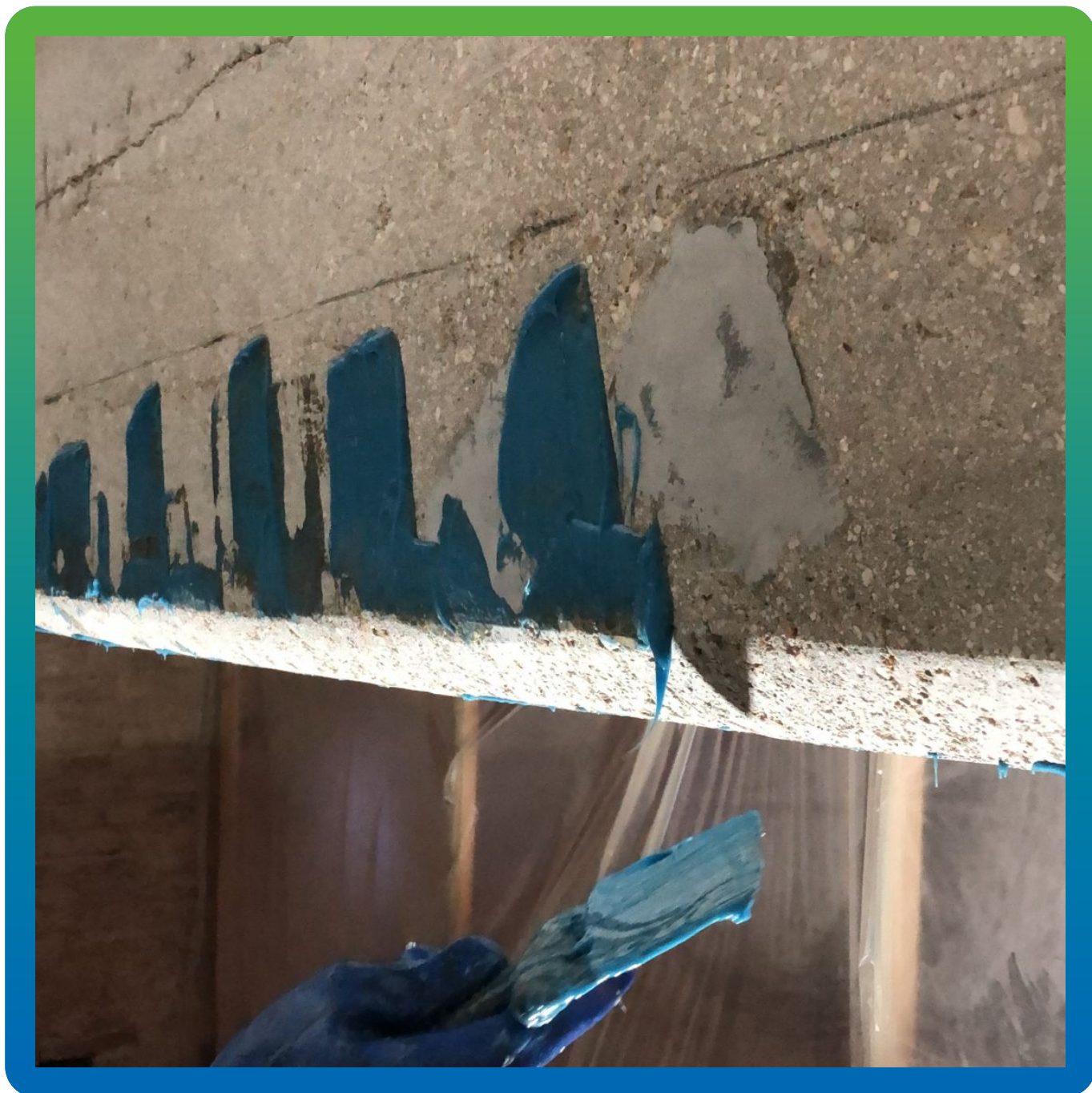
Нанесение матрицы Манопокс 183 на основание.
