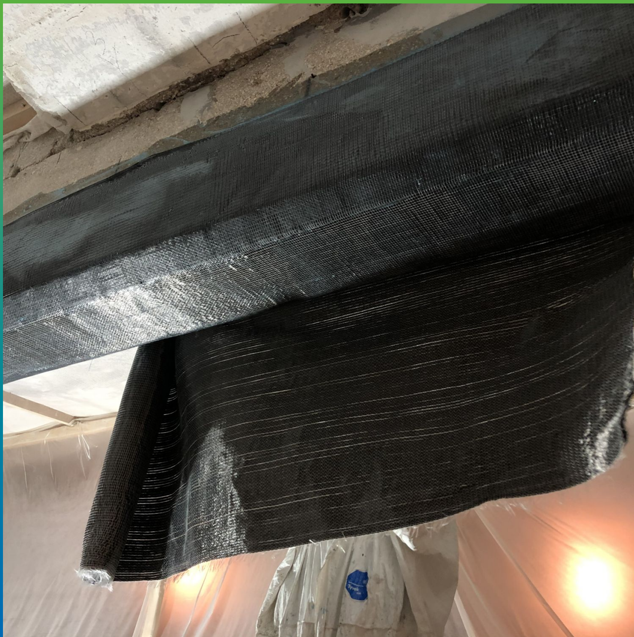
Монтаж последнего слоя нижнего армирования Армошел KB 200.
