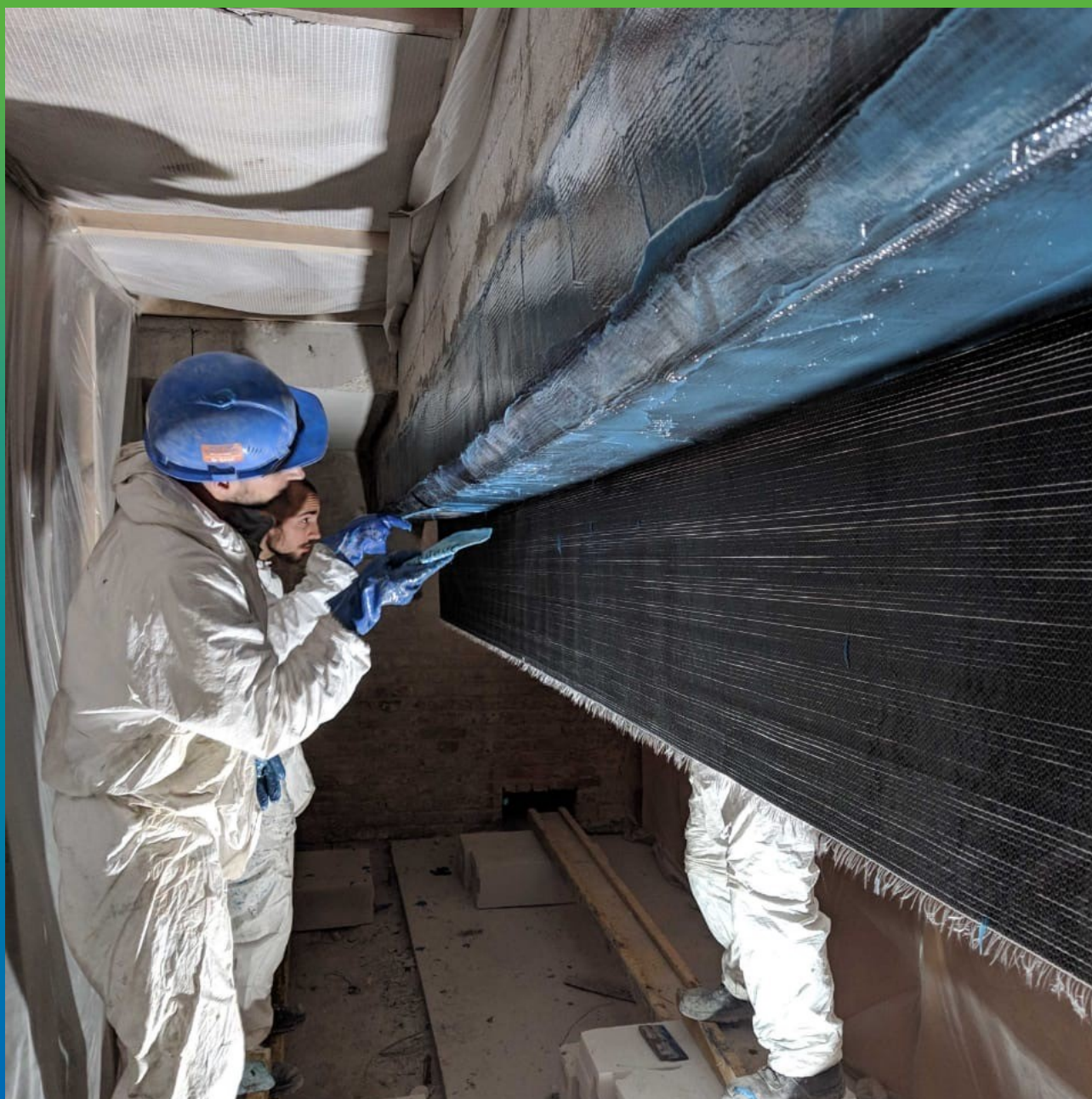
Нанесение следующего слоя Армошел KB 200 на матрицу Манопокс 183.
