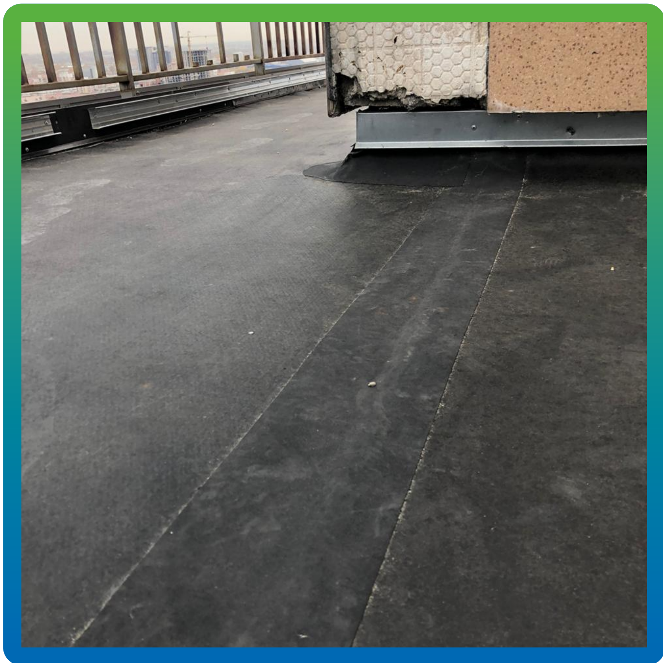
Сварные швы, выполненные с помощью Термобонд
