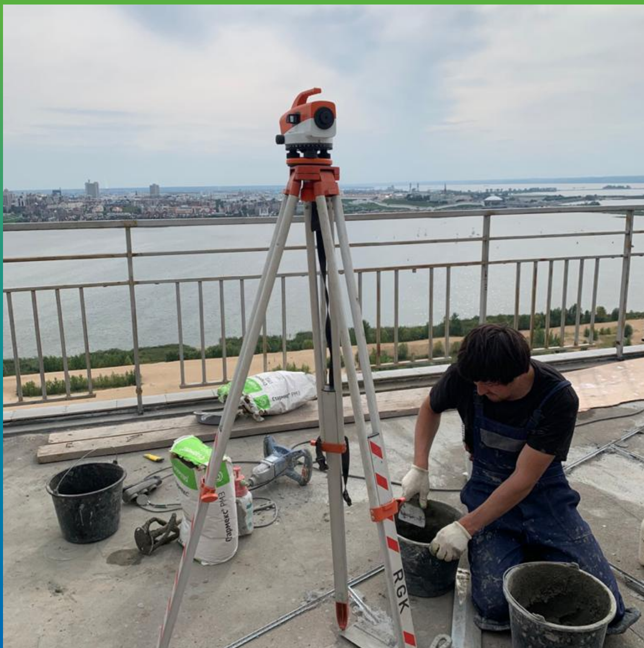
Создание меток уклона с помощью нивелира
