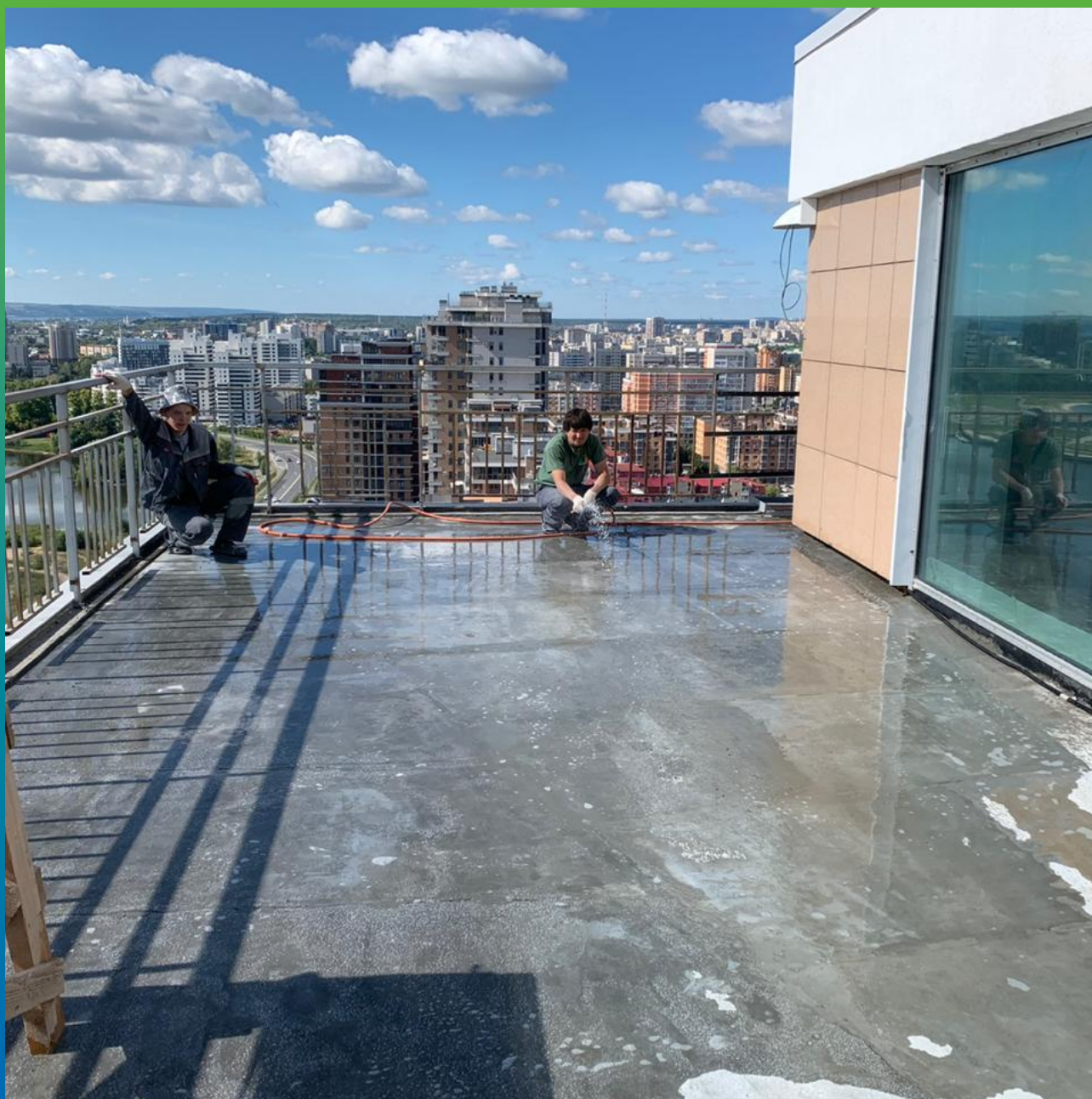
Проверка уклона проливкой воды. На всей площади - Стармекс РМЗ
