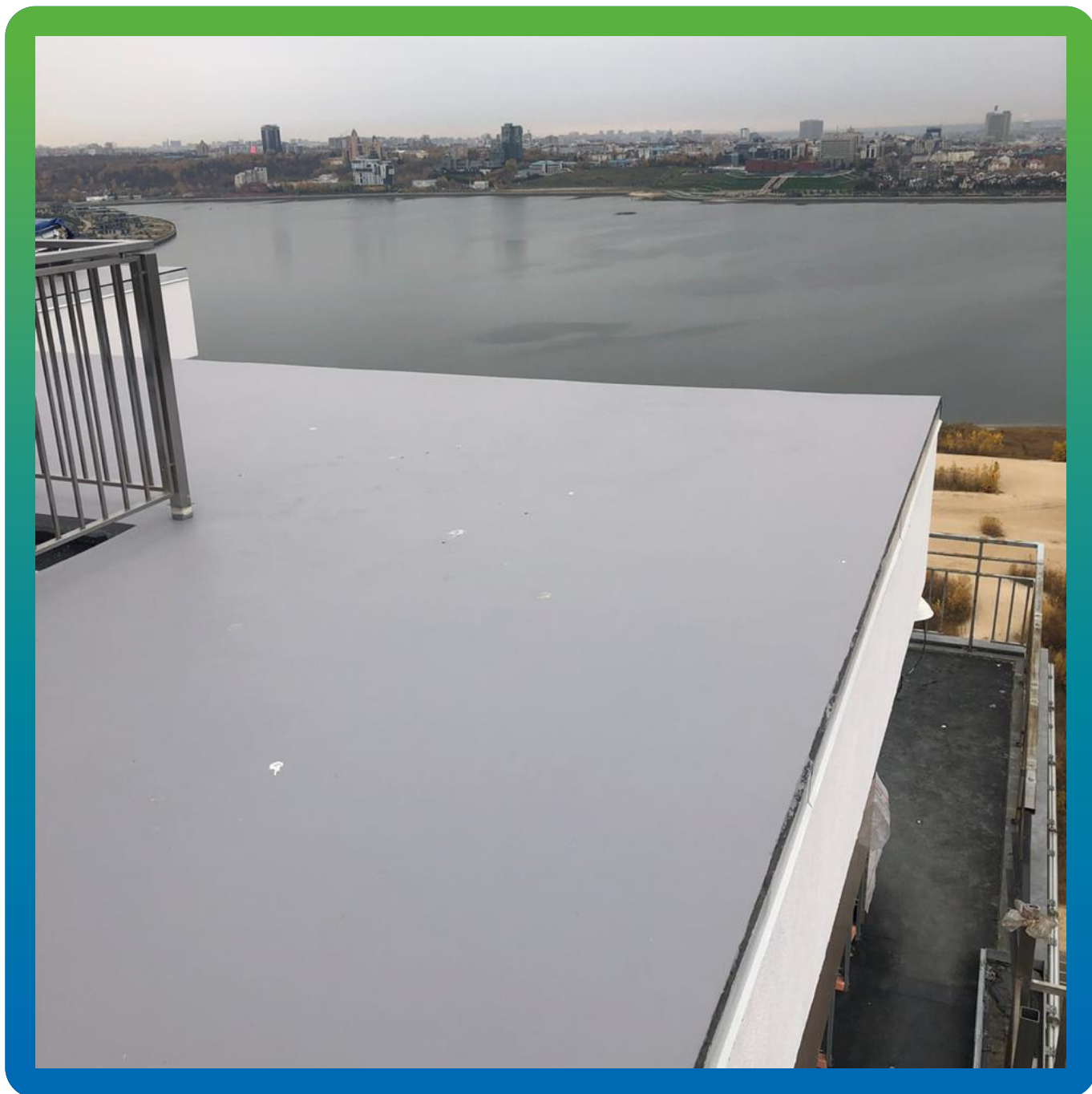
ДенсТоп ПУ 325 Аква, нанесенный на плиты ЦСП
