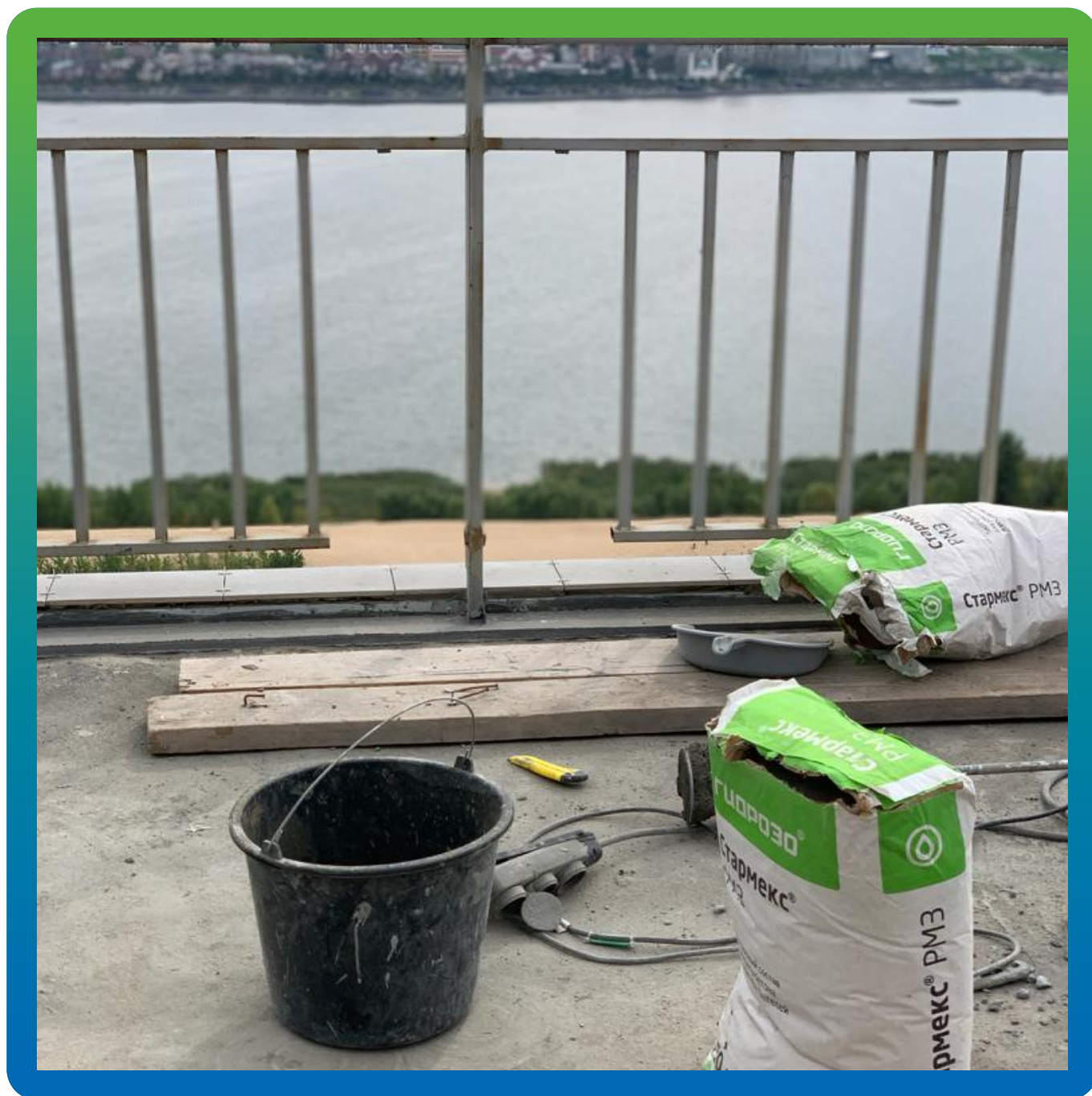
Стармекс РМЗ на объекте
