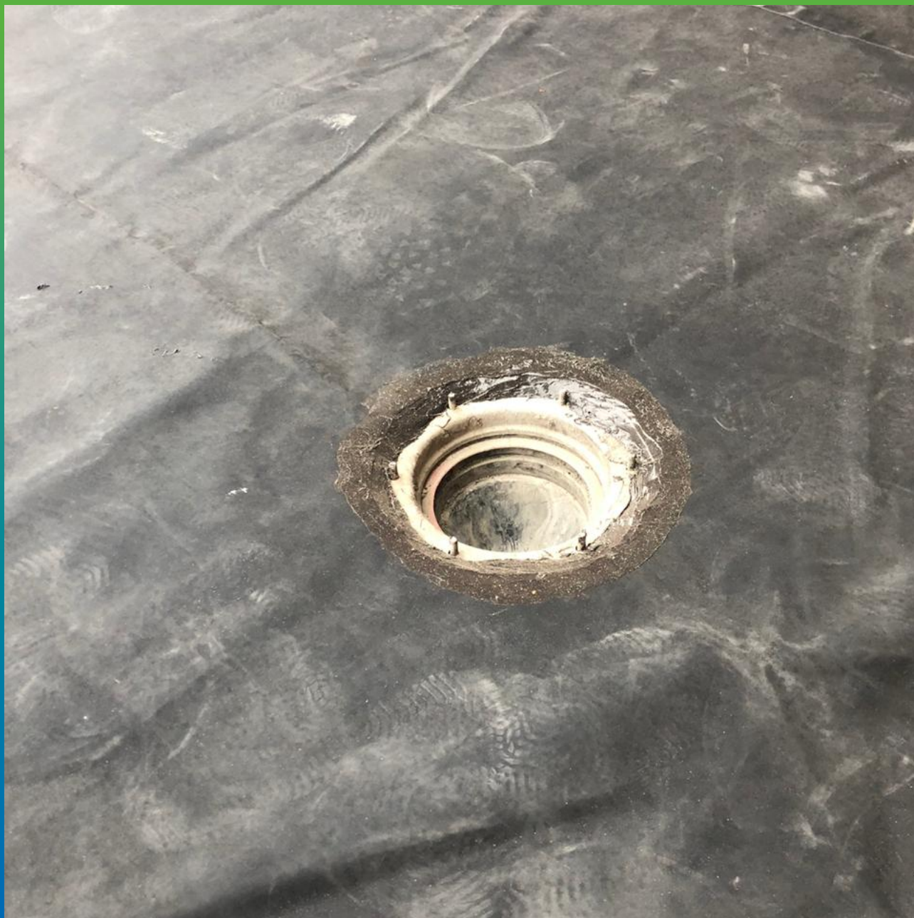
Гидроизолированная сливная воронка, обработанная составом Манодил Бонд Ф
