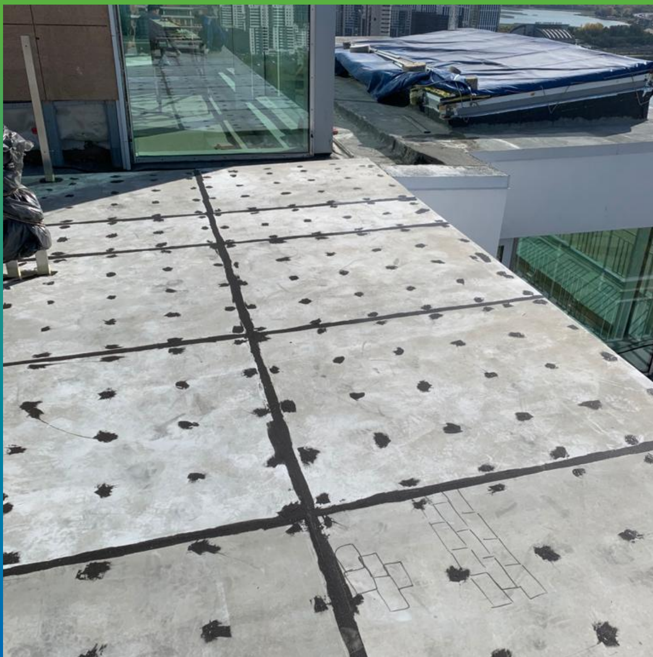
Стыки на плитах ЦСП, гидроизолированные составом Манодил Бонд Ф
