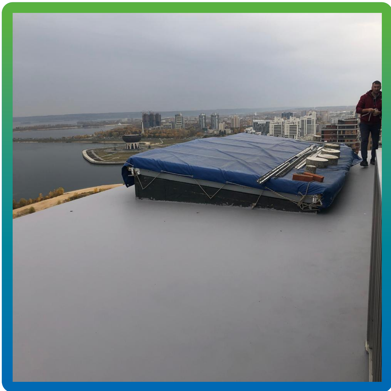
ДенсТоп ПУ 325 Аква, нанесенный на плиты ЦСП
