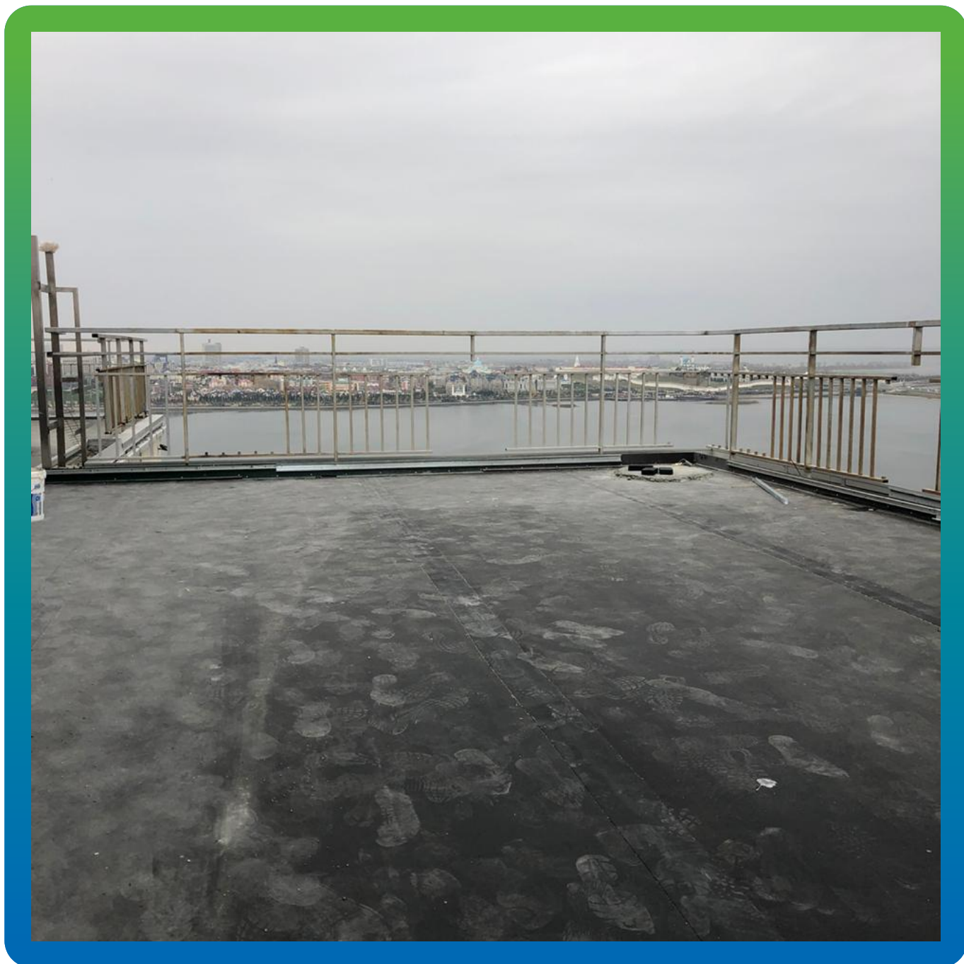
Финишный вид кровли
