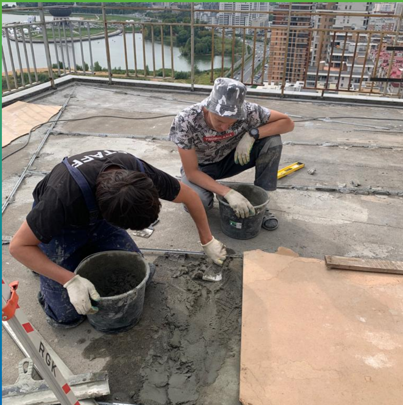
Укладка Стармекс РМЗ по направляющим
