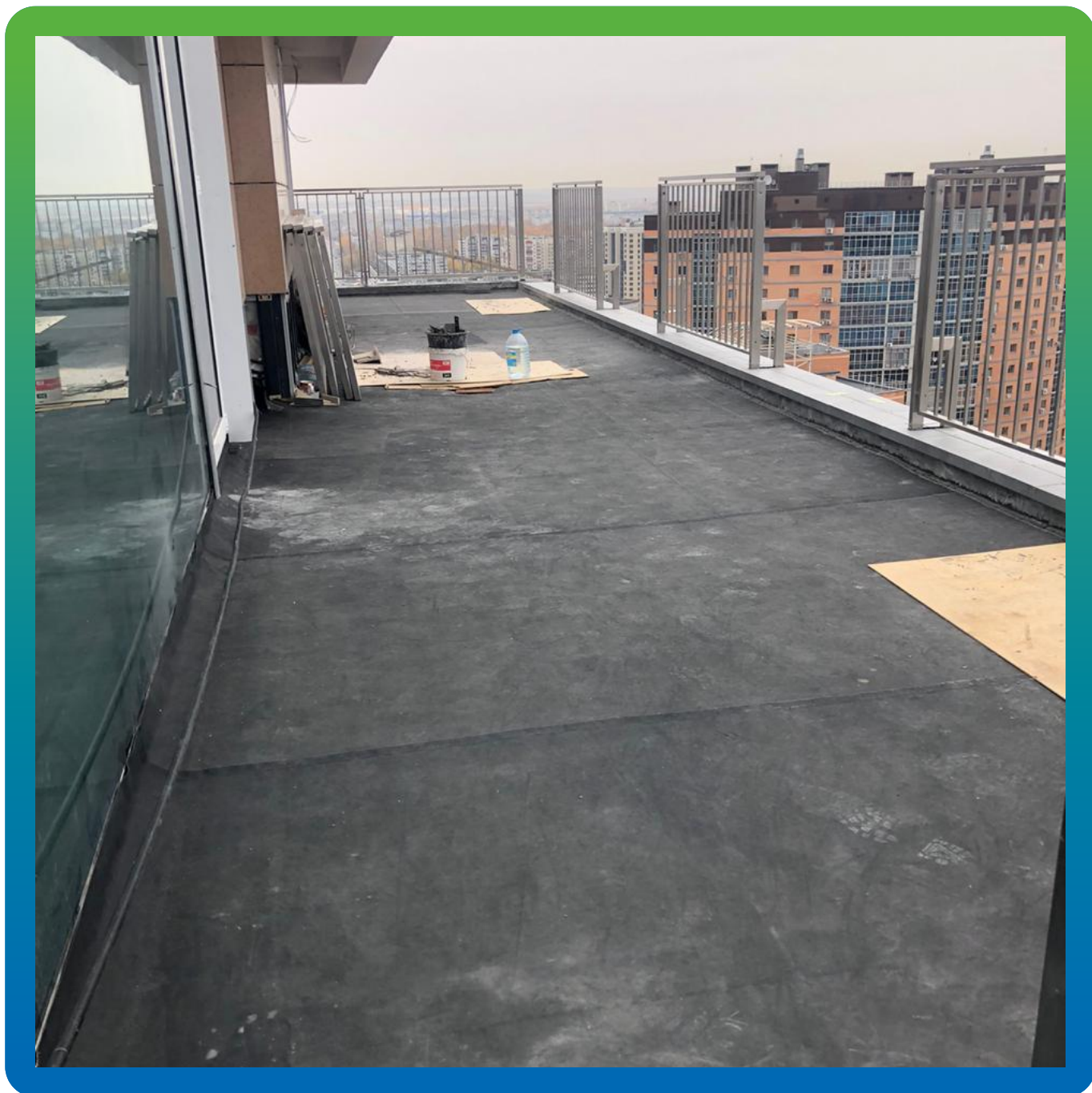
ЭПДМ мембрана Преласты СТ, уложенная на основную часть террасы
