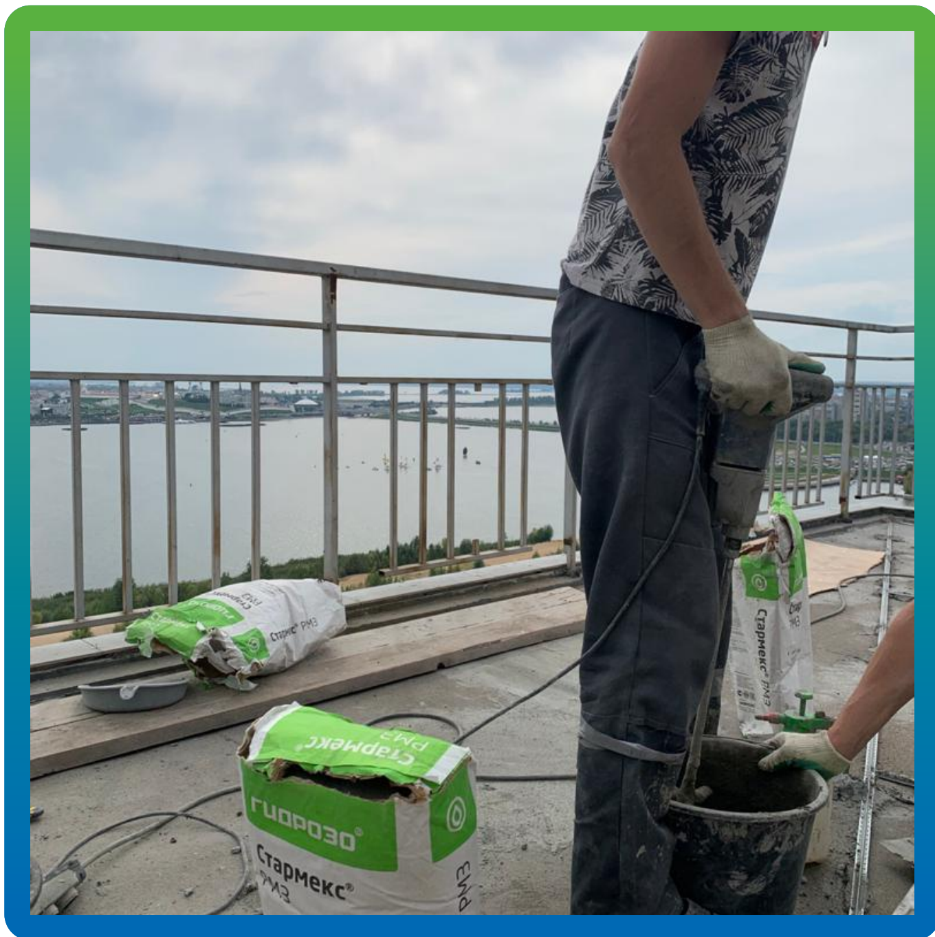
Приготовление состава Стармекс РМЗ
