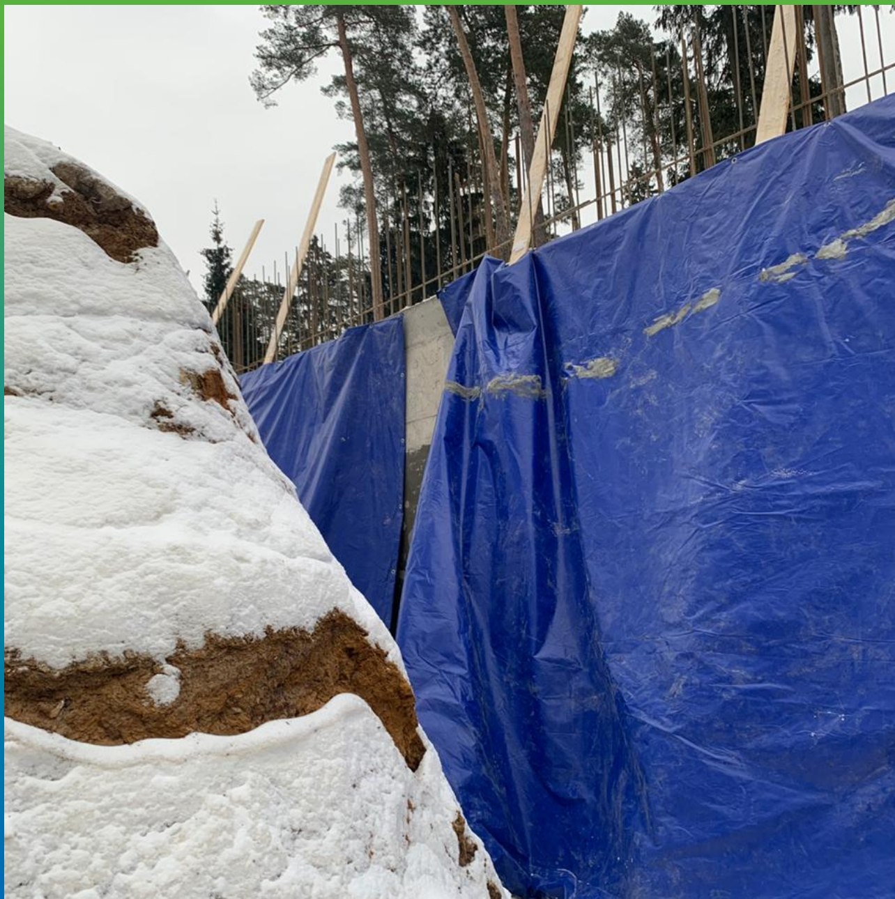
Устройство теплового контура
