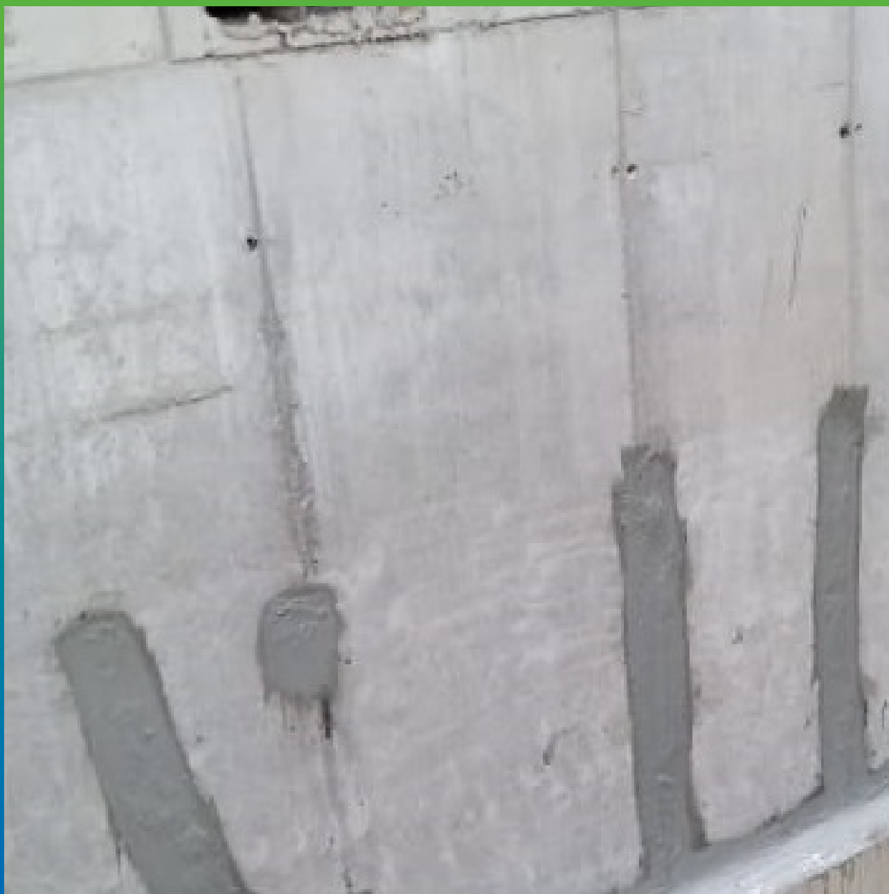
Ремонт дефектов при помощи Стармекс РМ5
