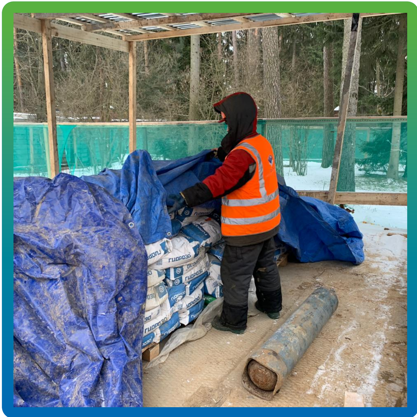
Стармекс Эласт и Стармекс РМ5 на объекте
