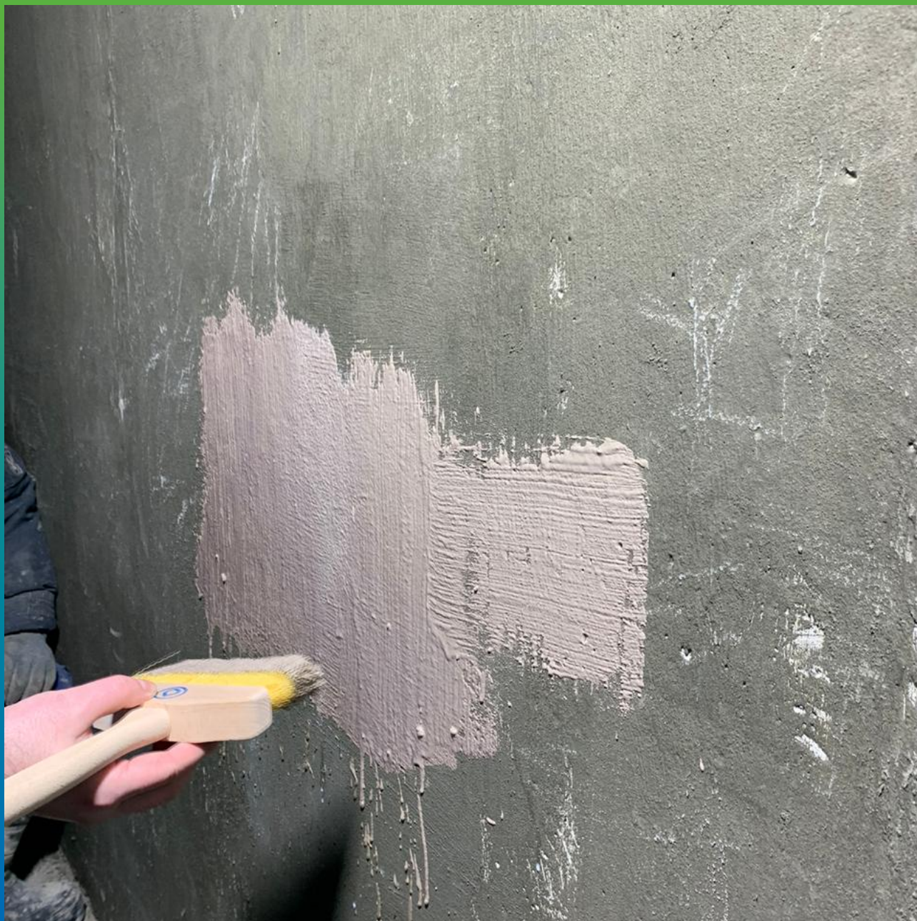
Нанесение Стармекс Эласт
