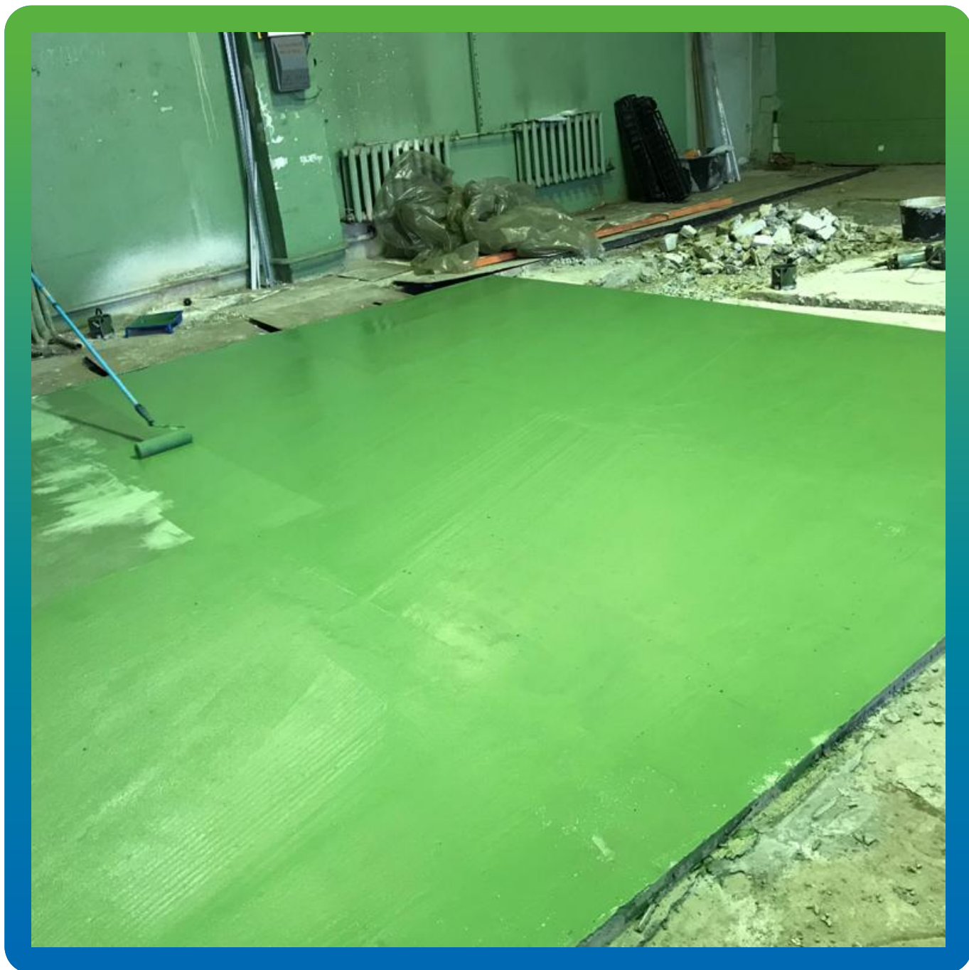
Защита основания от замасливания при помощи ДенТоп ЭП 201
