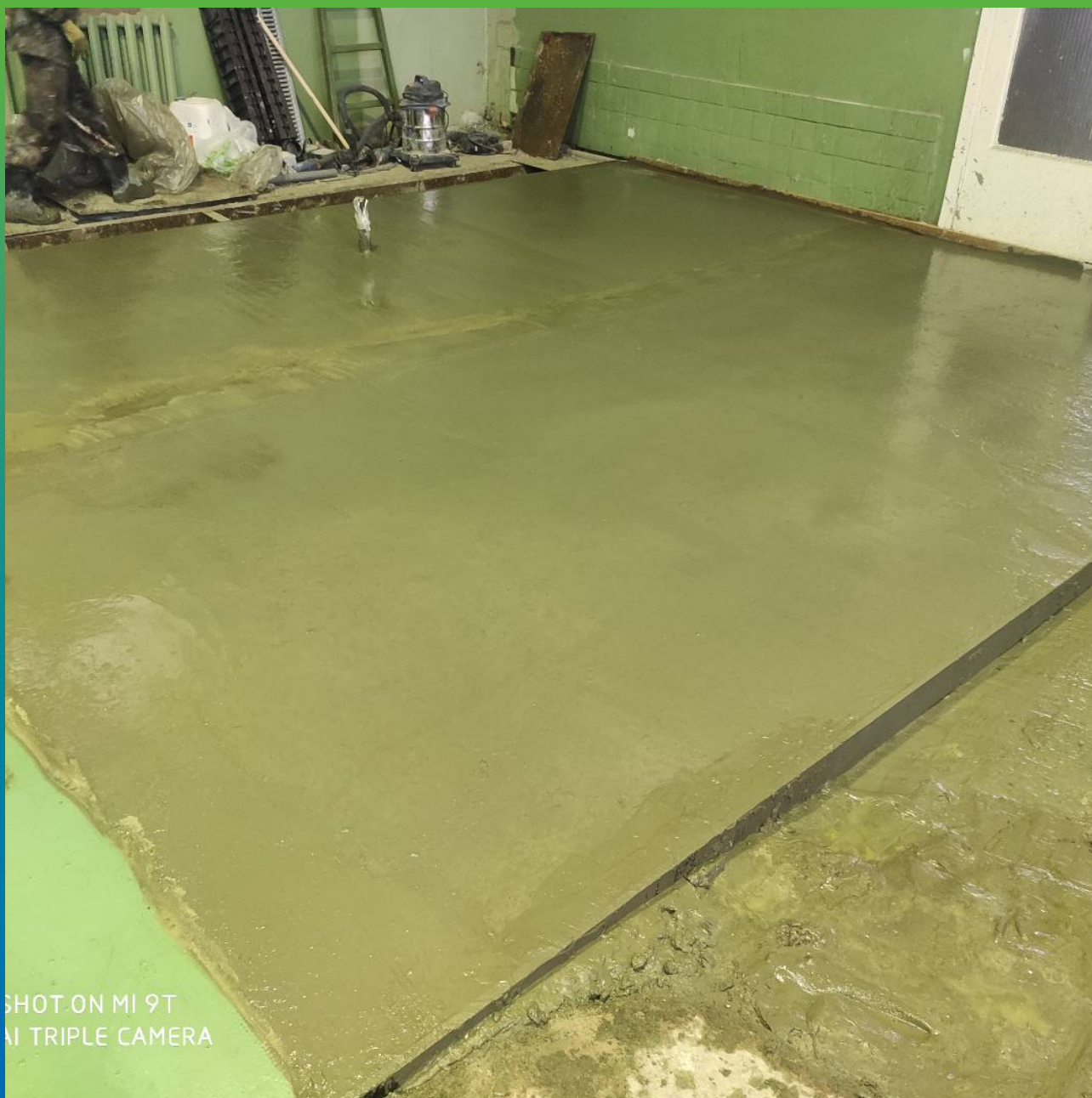
Устройство основания при помощи Стармекс ФМ7
