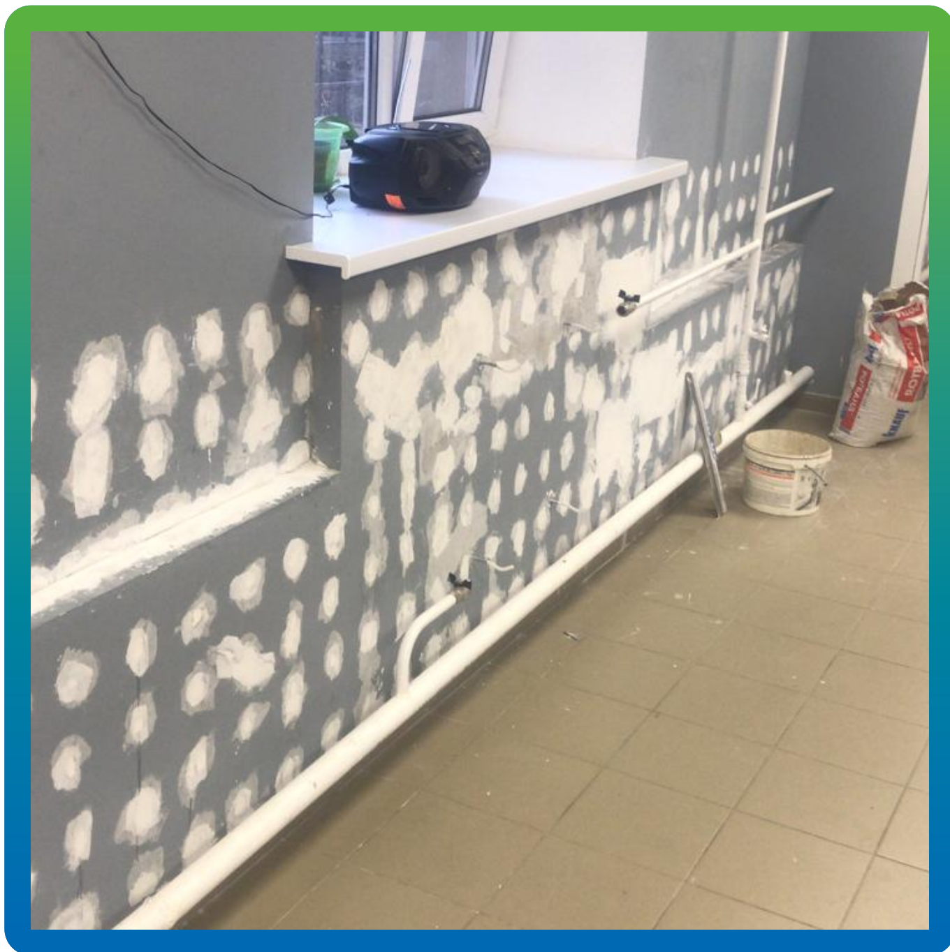
Зачеканка шпуров при помощи Стармекс РМЗ
