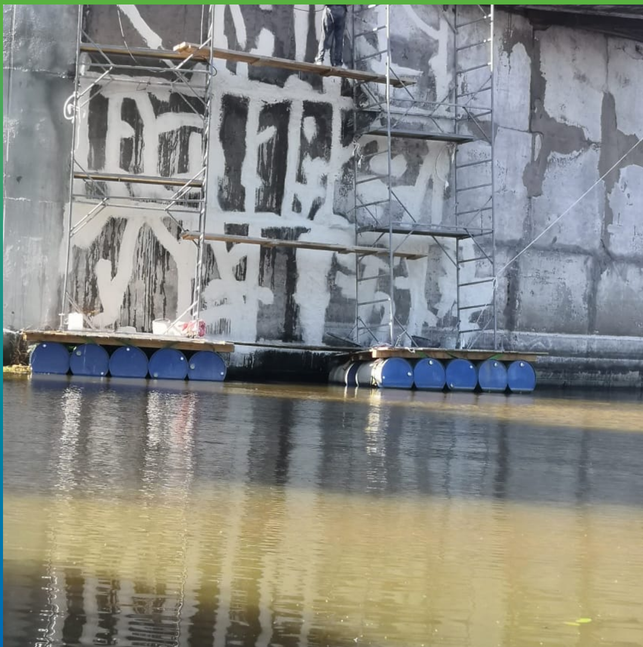
Внешний вид отремонтированной поверхности
