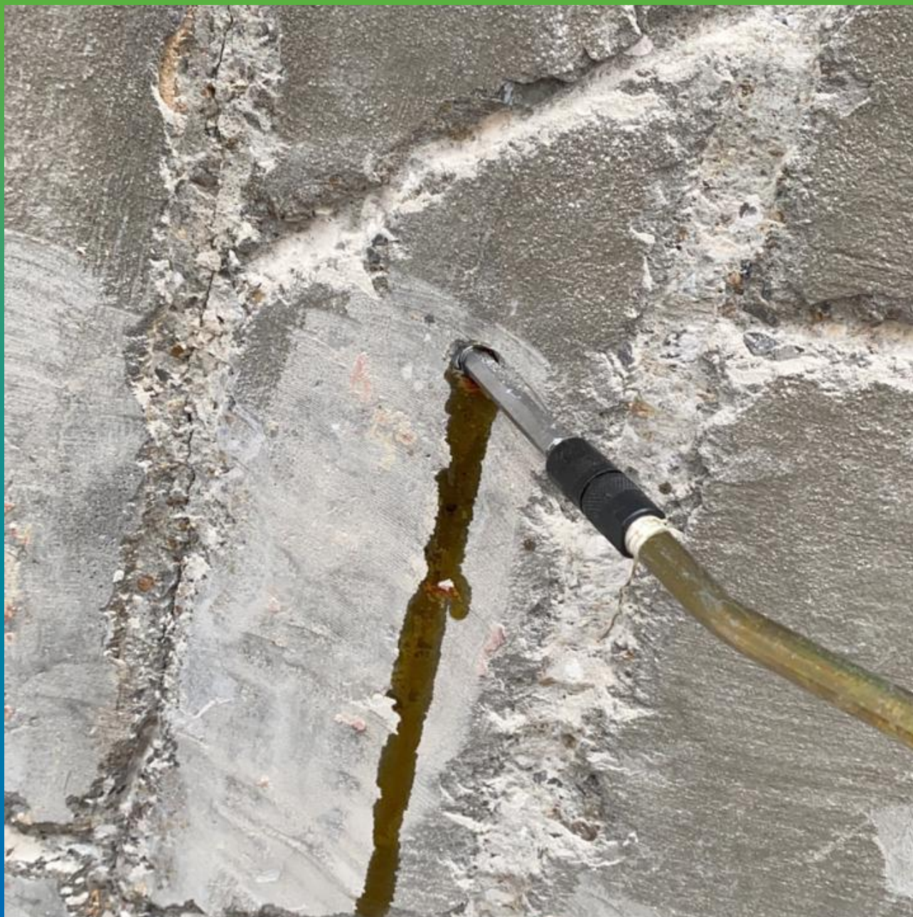
Инъектирование трещин эпоксидным составом Манопокс 352
