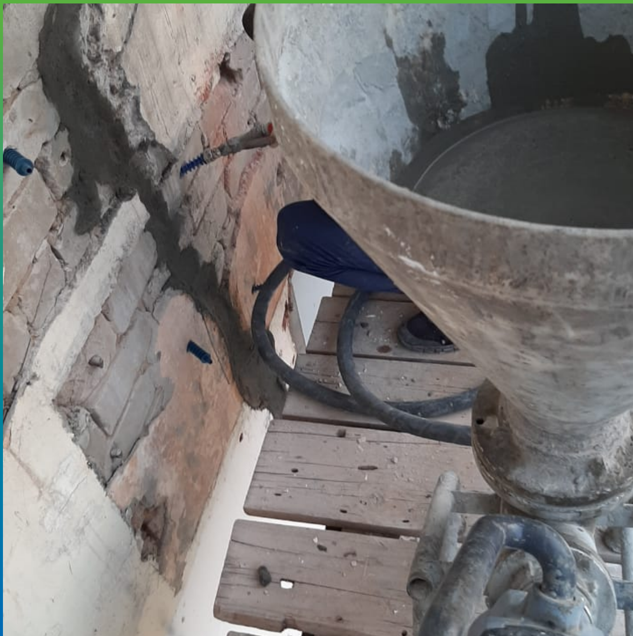
Инъектирование трещин составом Маноцем Гроут
