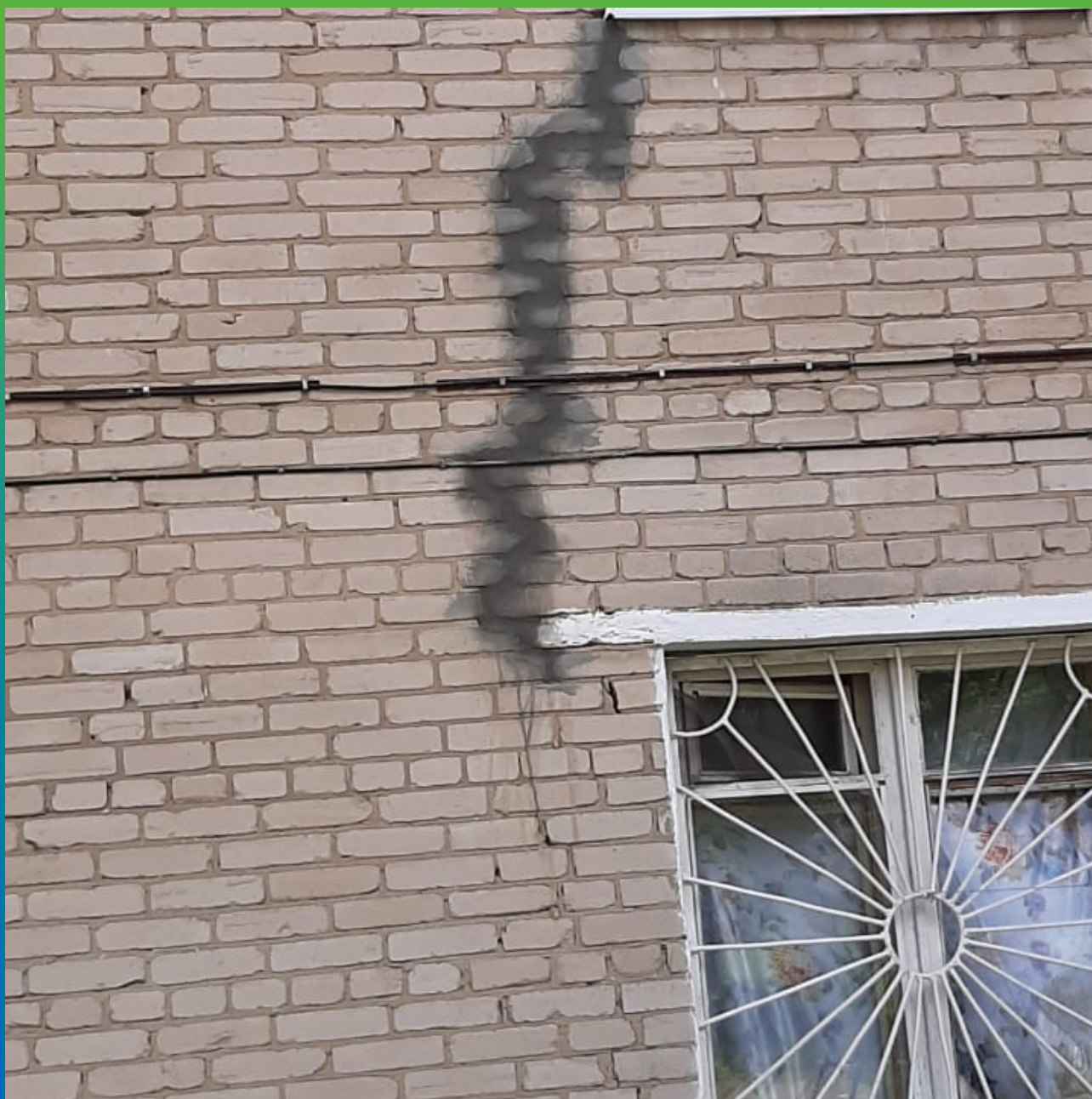
Зачеканка расшитой трещины ремонтным составом
