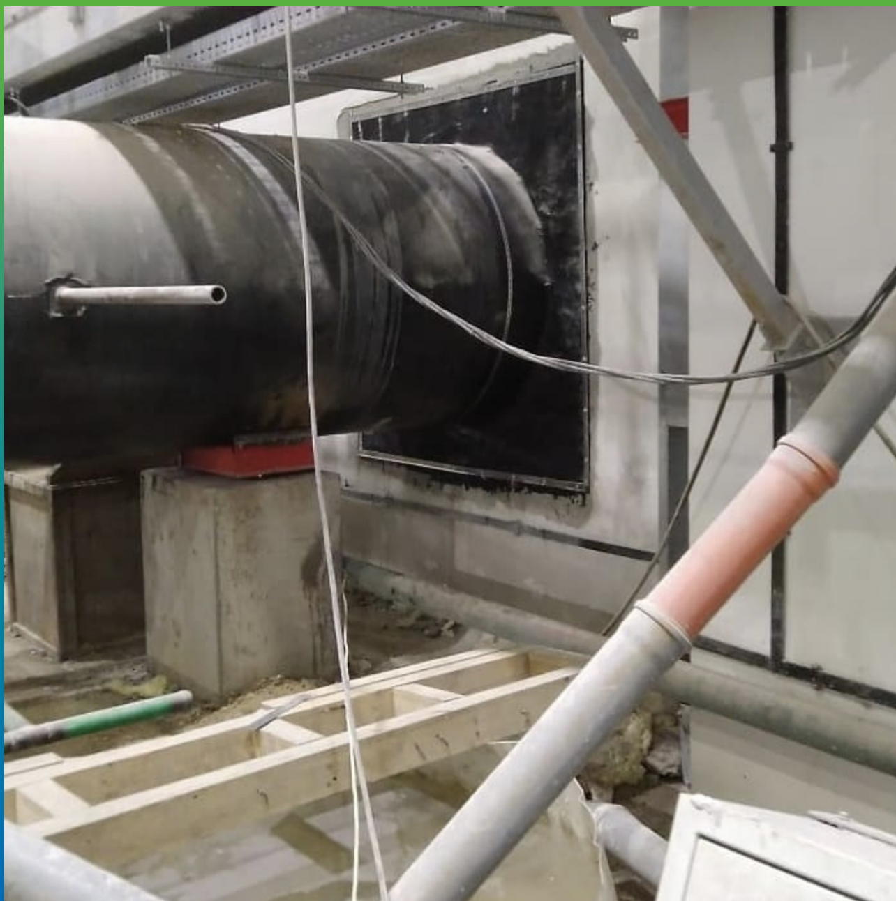
Обклейка ввода ЭПДМ мембраной Преласта СТ
