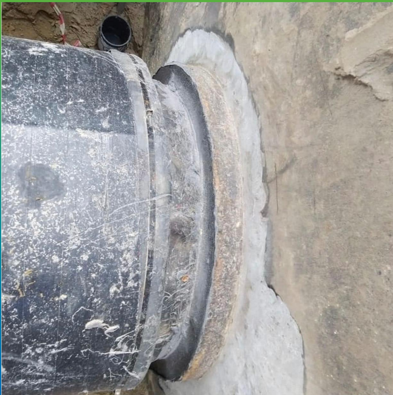
Ввод, зачеканеный составом Стармекс РМЗ и загерметезированный составом Манодил Бонд Ф
