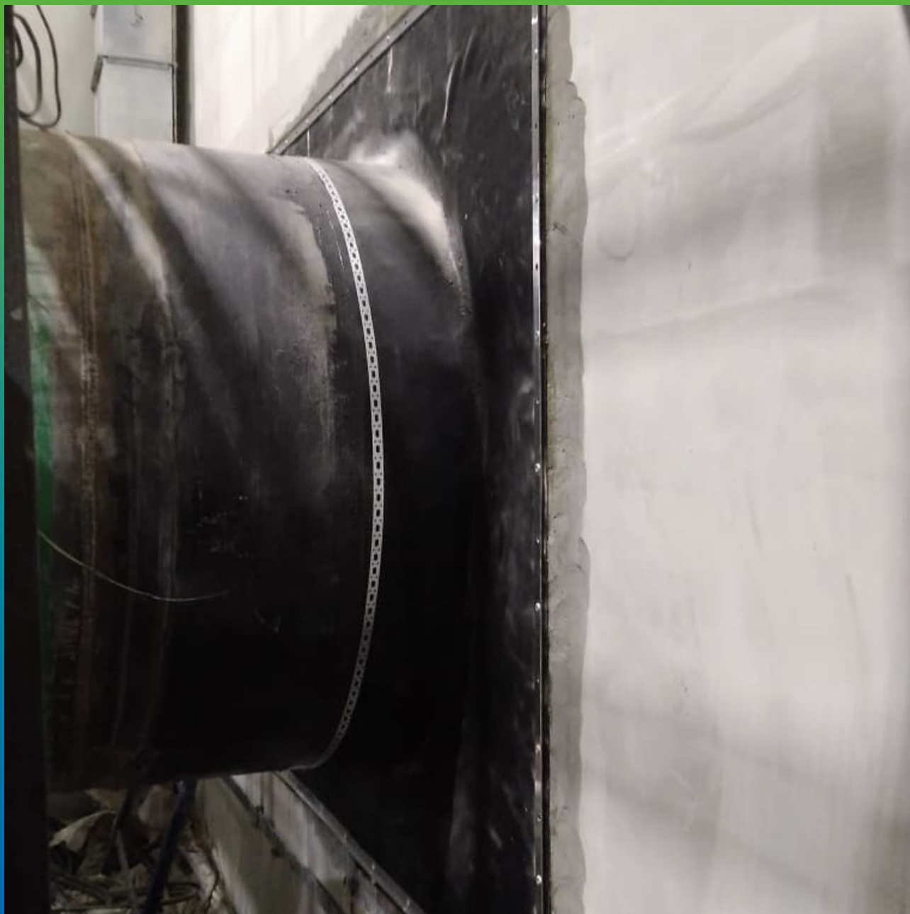
Обклейка ввода ЭПДМ мембраной Преласта СТ
