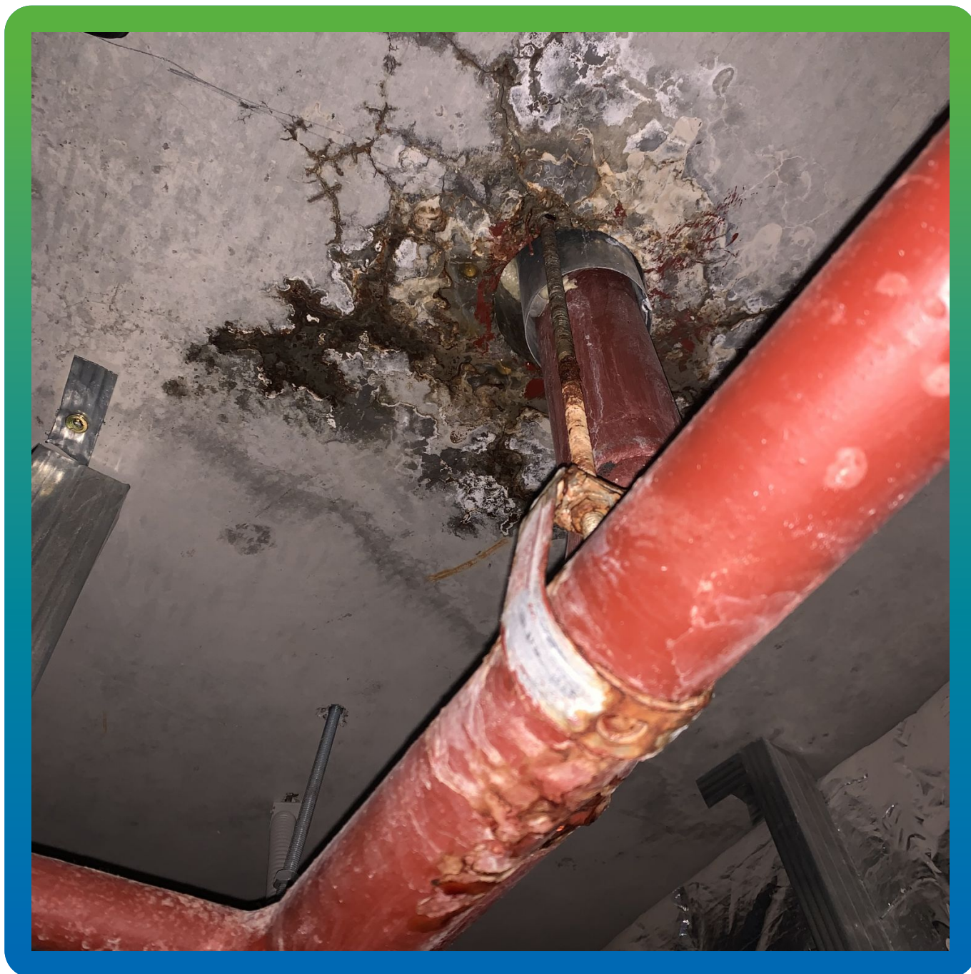
Ввод коммуникаций до проведения работ
