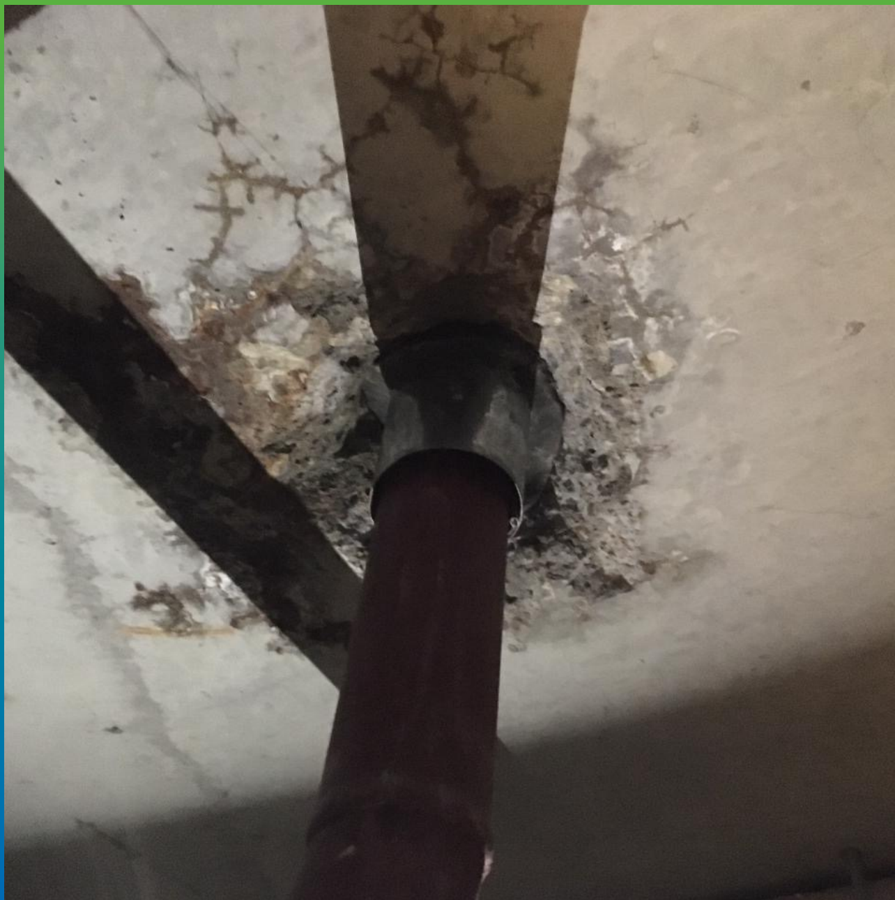
Ввод коммуникаций до проведения работ
