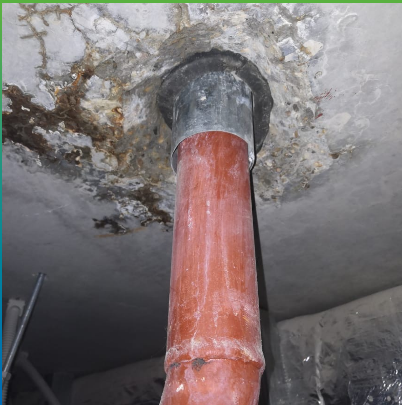
Ввод коммуникаций до проведения работ
