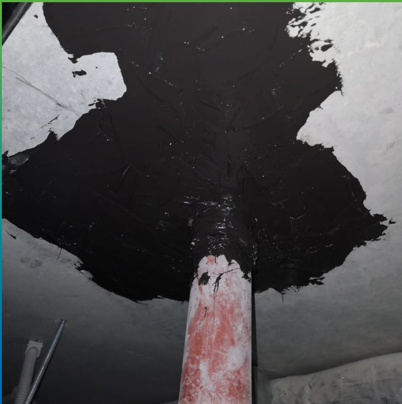
Ввод после проведения работ
