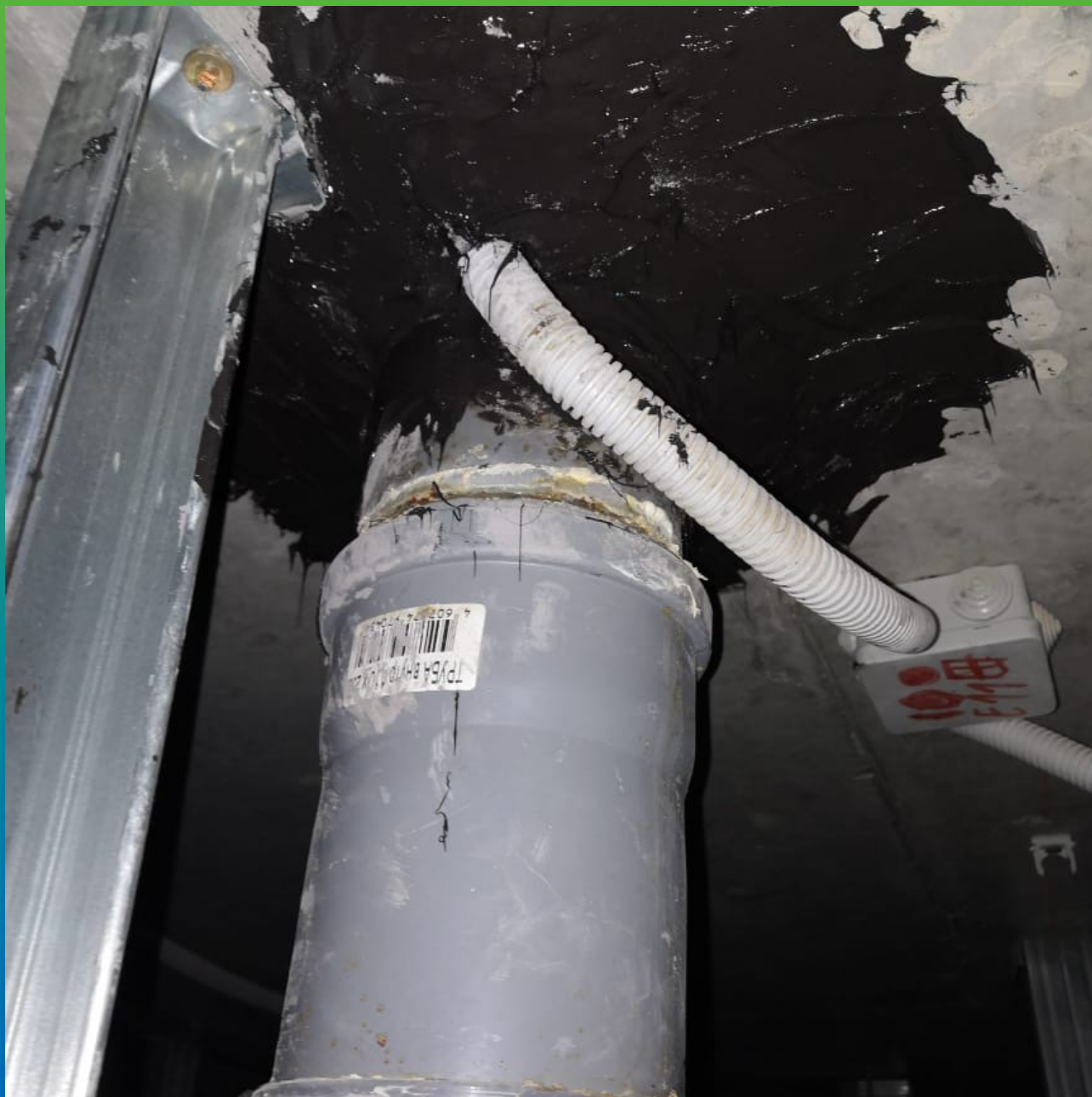
Ввод после проведения работ
