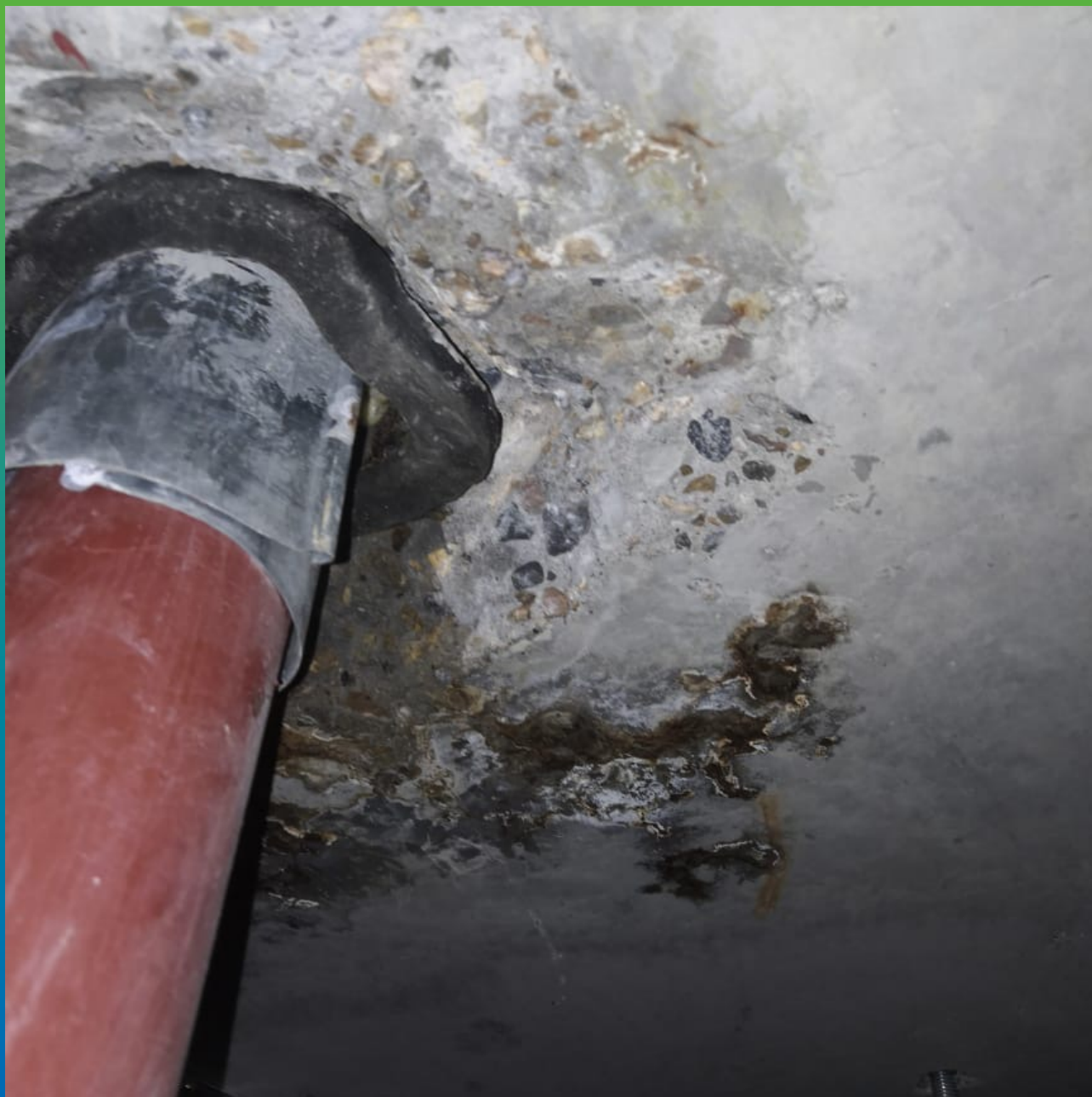
Ввод, зачеканеный составом Витрафин Флекс
